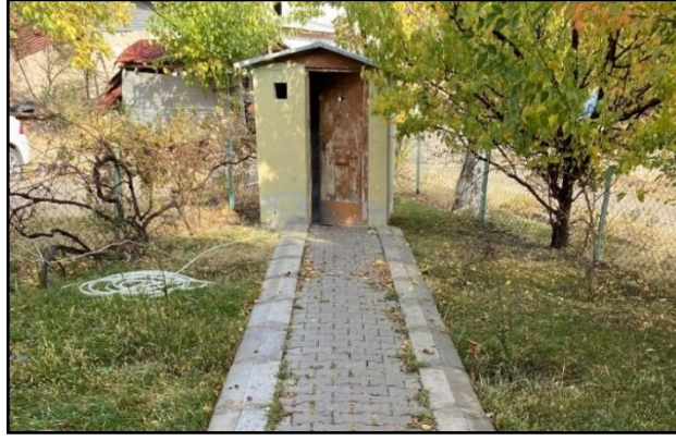
Şekil 93. Beklimçay Cami niteliksiz ek örneği: bahçeye sonradan eklenen depo yapısı
