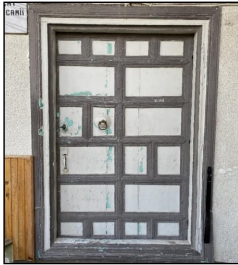
Şekil 86. Beklimçay Cami bilinçsiz müdahale örneği: özgün harim kapısına boya uygulaması
