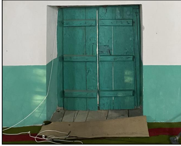
Şekil 67. Aşağıgedik Cami: harim giriş kapısına uygulanan niteliksiz boya uygulaması
