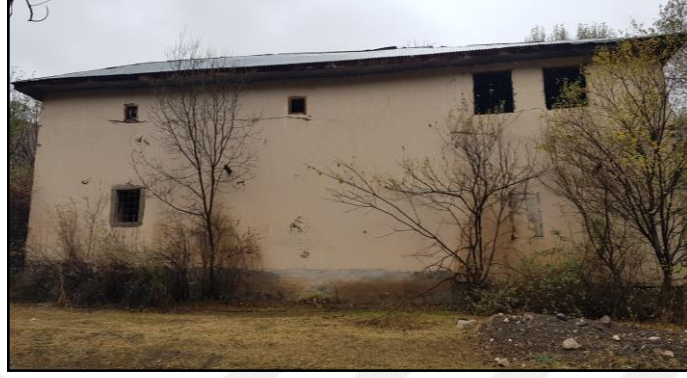
Şekil 72. Soğukpınar Cami: doğu cephe
