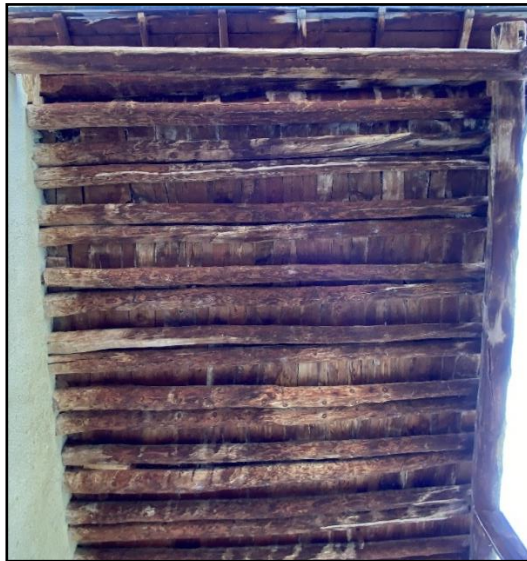
Şekil 69. Beklimçay Cami: ahşap tavan kaplamalarında tespit edilen renk değişimi ve küf oluşumu
