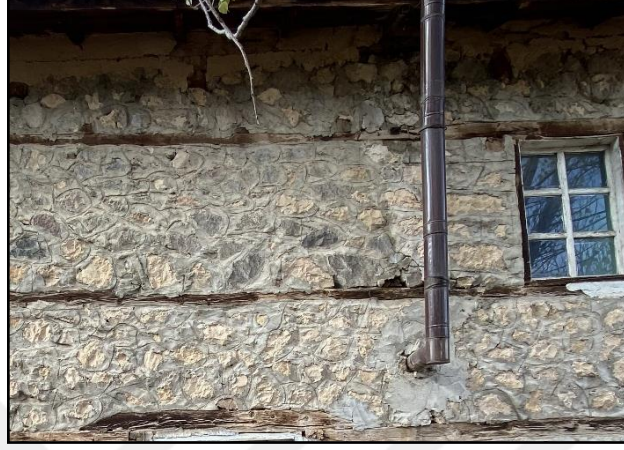
Şekil 87. Beklimçay Cami bilinçsiz müdahale örneği: özgün beden duvarlarının delinmesi
