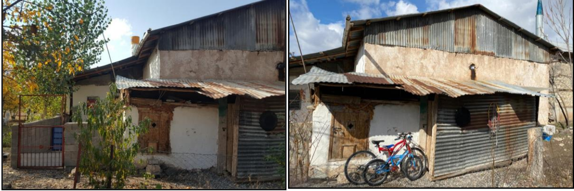
řekil 19. Lojman: dođu cephesi
