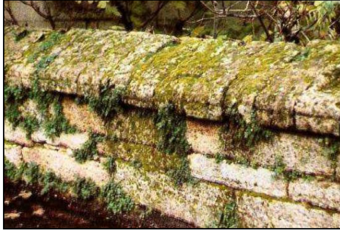
Şekil 18. Taş Elemanlardaki Bozulmalar: Yosunlaşma (Dolar ve Yılmaz 2014)
