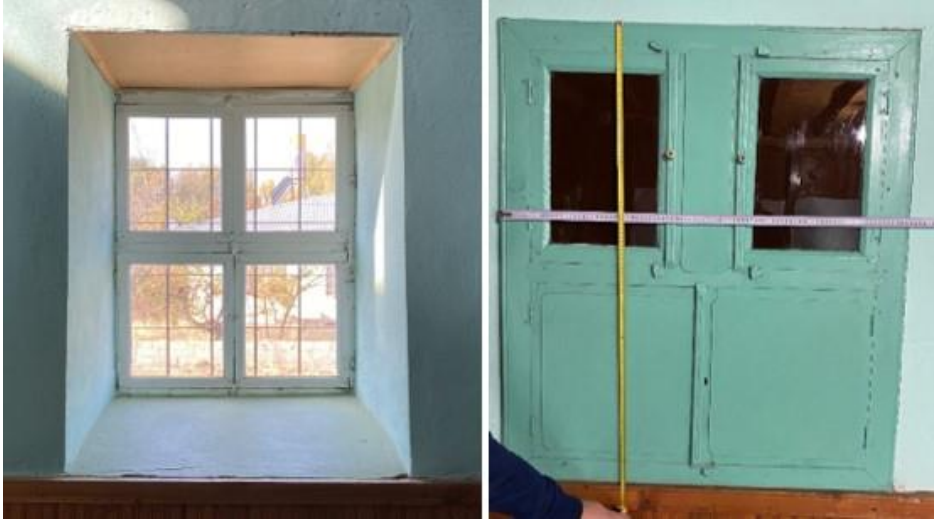
Şekil 84. Beklimçay Cami bilinçsiz müdahale örneği: özgün ahşap dolaba yağlı boya uygulaması
