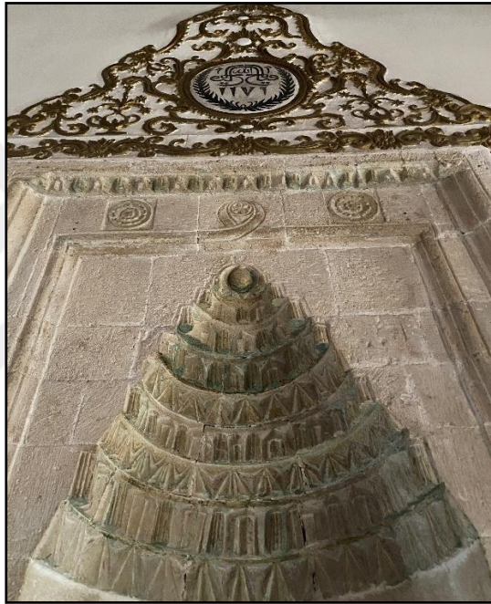
Şekil 121. Gülabibey Cami: taş mihrapta tespit edilen renk değişimi/ küflenme
