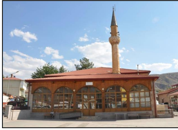
Şekil 114. Gülabibey Cami: kuzey cephesi
