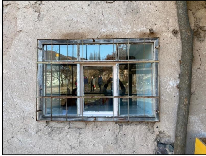
Şekil 66. Beklimçay Cami: ahşap pencere kasalarında oluşan renk değişimi
