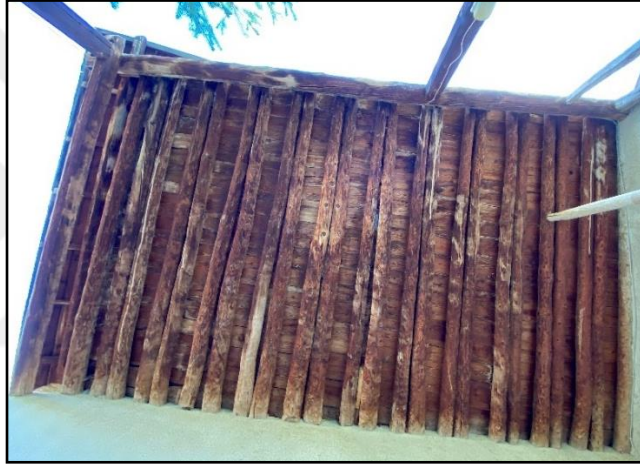
Şekil 98. Beklimçay Cami: son cemaat mahalindeki ahşap direklerde tespit edilen sehim ve şakülden kayma
