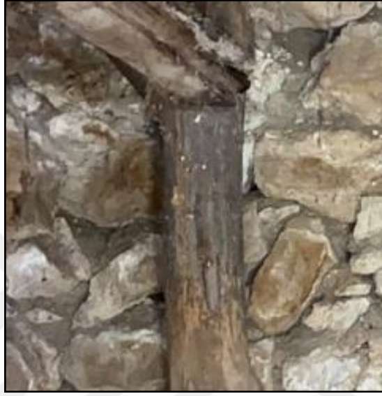
Şekil 8. Ahşap Elemanlardaki Bozulmalar: Renk Deęişimi ve Solma
