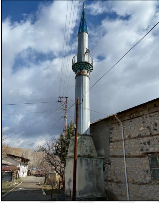
Şekil 89. Beklimçay Cami niteliksiz ek örneği: beton kaideli sac minare
