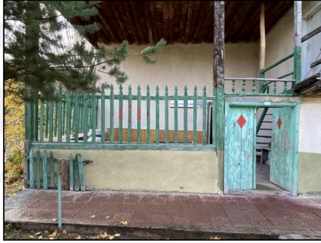
Şekil 85. Beklimçay Cami niteliksiz ek ve bilinçsiz müdahale örneği: özgün ahşap kapı ve korkuluklara yağlı boya uygulaması
