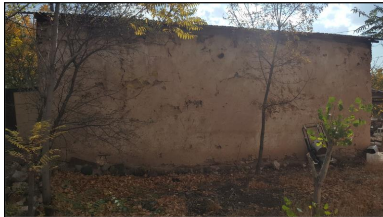
Şekil 27. Lojman: kuzey cephesi
