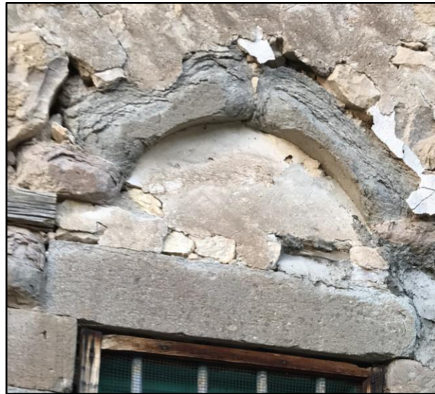
Şekil 60. Aşağıgedik Cami: pencere taş kemerlerinde oluşan yapraklanma
