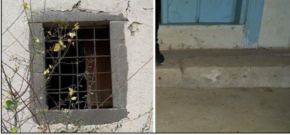
Şekil 84. Soğukpınar Cami: taş sövelerde ve taş basamakta oluşan yüzey kirliliği, çatlama, oyuklanma
