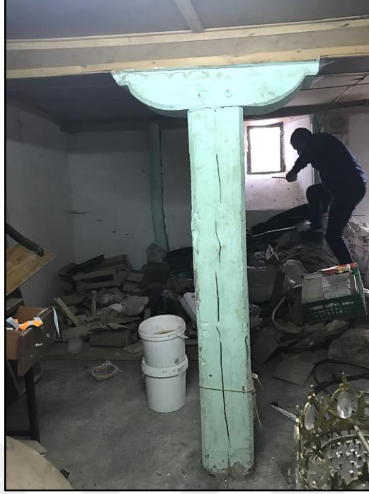
Şekil 65. Aşağıgedik Cami bilinçsiz müdahale ve niteliksiz ek örneği: depodaki niteliksiz tavan ve kontrplak uygulaması
