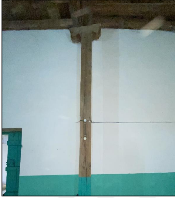
Şekil 69. Aşağıgedik Cami: harimdeki ahşap direklerde oluşan şakülden kayma
