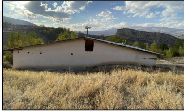
Şekil 50. Aşağıgedik Cami: doğu cephe
