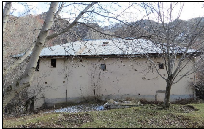
Şekil 74. Soğukpınar Cami: batı cephe
