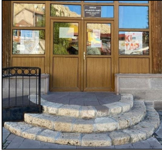
Şekil 120. Gülabibey Cami: taş basamaklarda oluşan aşınmalar
