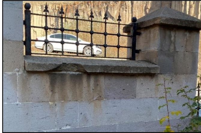
Şekil 13. Taş Elemanlardaki Bozulmalar: Parça Kaybı
