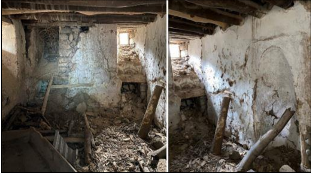
Şekil 80. Soğukpınar Cami: alt katta yer alan depo
