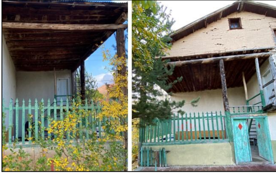
Şekil 97. Beklimçay Cami: son cemaat mahalindeki ahşap kirişlerde tespit edilen sehim
