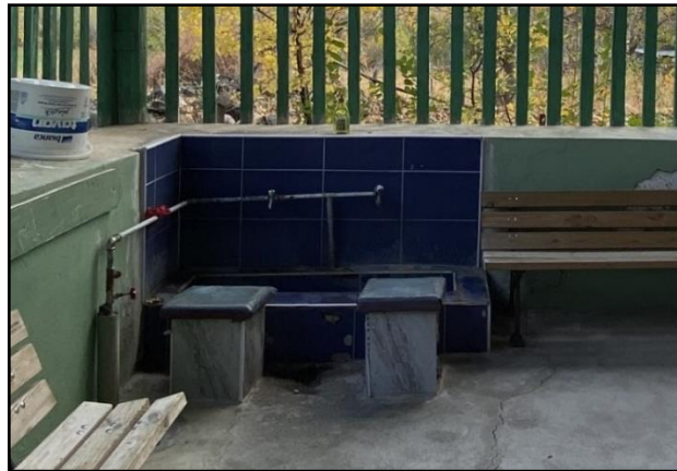
Şekil 221. Beklimçay Cami niteliksiz ek örneği: son cemaat mahaline sonradan eklenen abdest alma yeri
