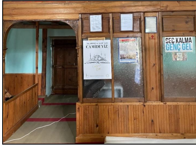
Şekil 90. Beklimçay Cami niteliksiz ek örneği: ahşap bölücü uygulaması
