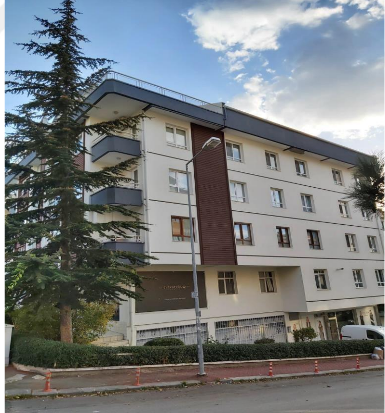
Şekil 6.8. Ankara'da mevcut yapılar
