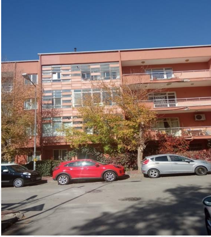
Şekil 6.5. Ankara'da mevcut yapılar
