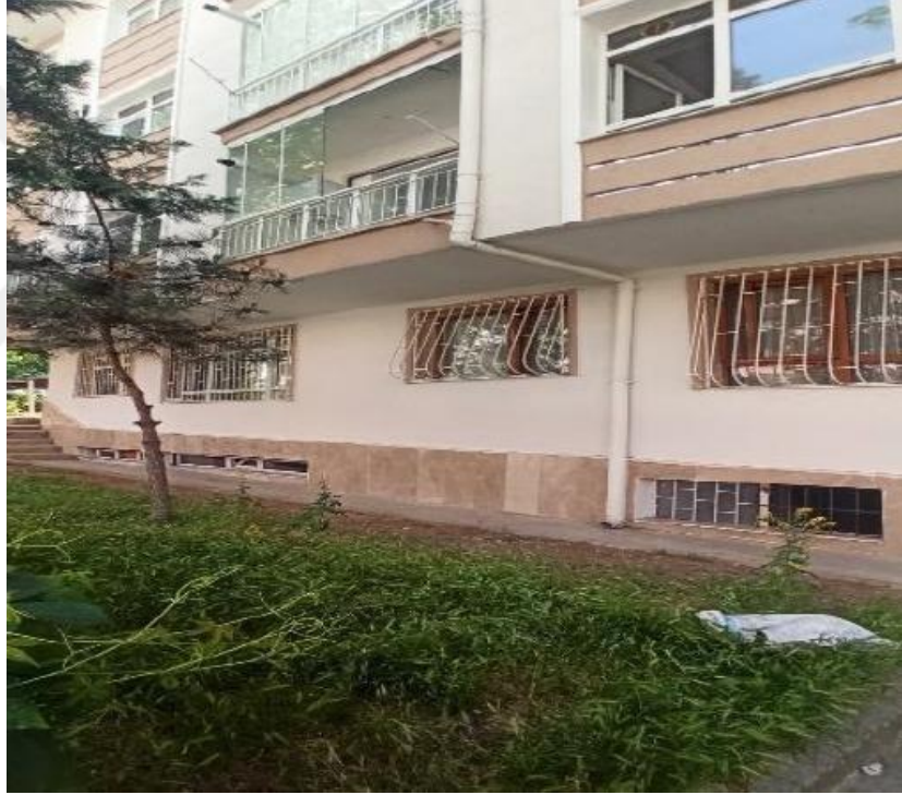
Şekil 3.11. Kısa kolonlu mevcut bir yapı
