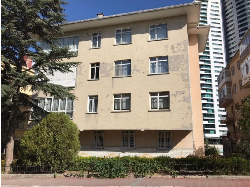
Şekil 3.13. Görünen yapı kalitesi kötü mevcut bir yapı
