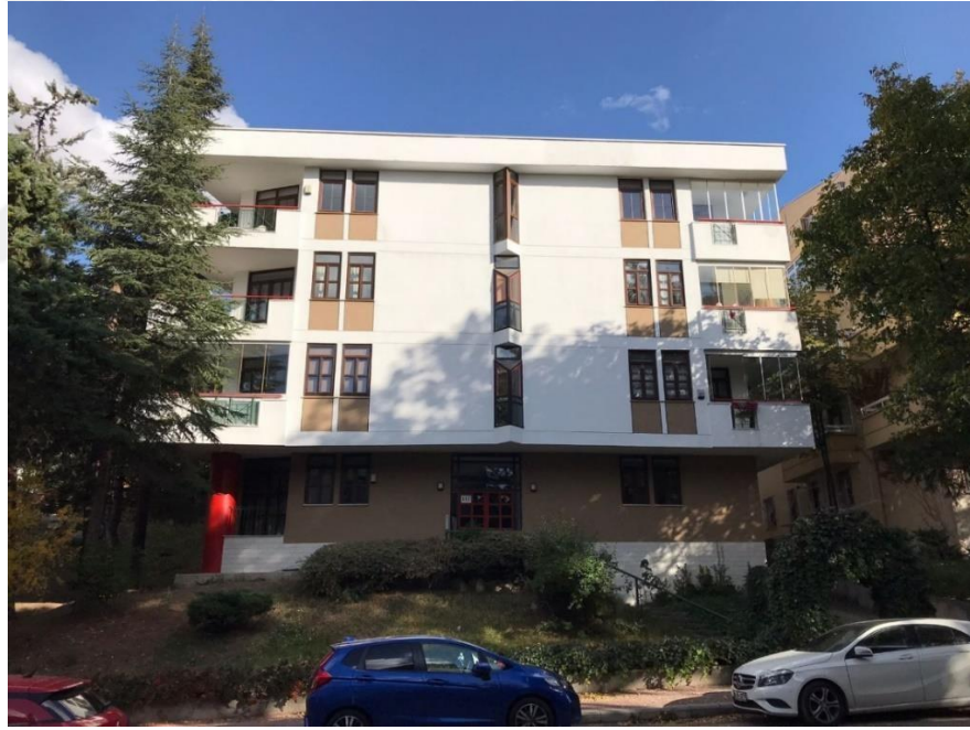
Şekil 3.15. Görünen yapı kalitesi iyi mevcut bir yapı
