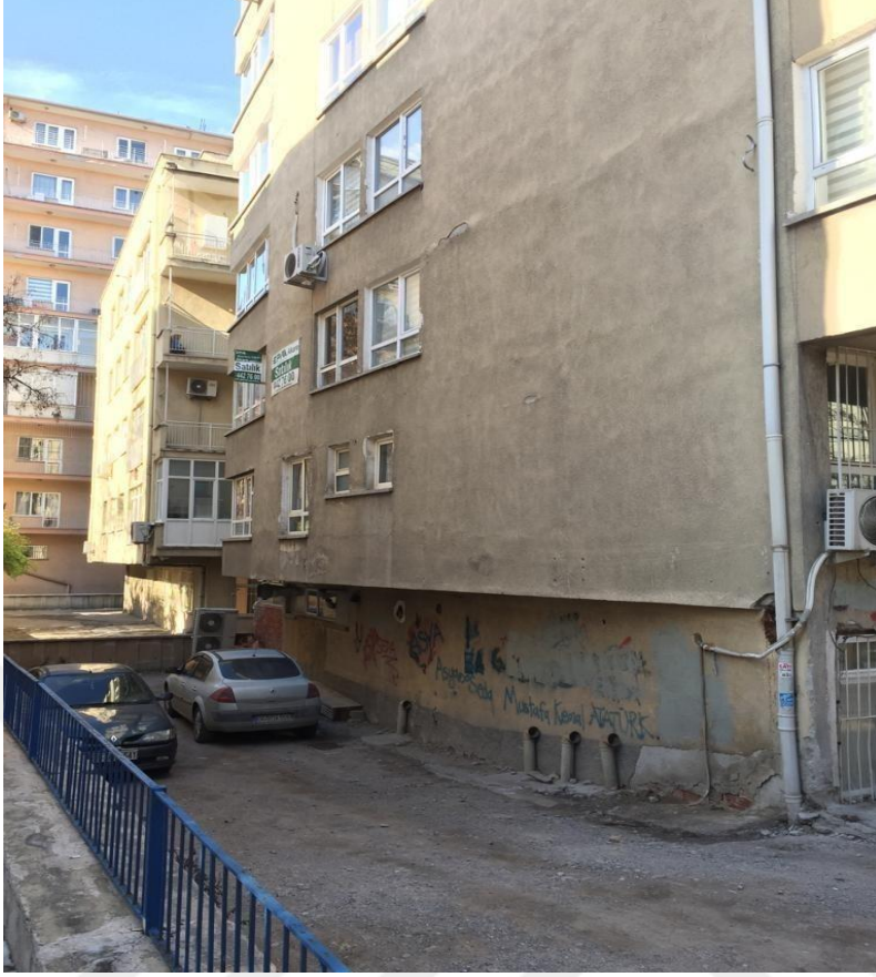
Şekil 3.12. Görünen yapı kalitesi kötü mevcut bir yapı
