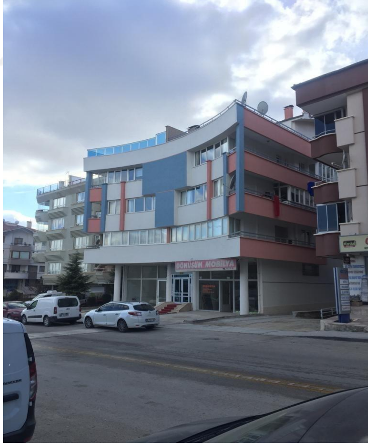
Şekil 3.10. Yumuşak kata sahip mevcut bir yapı
