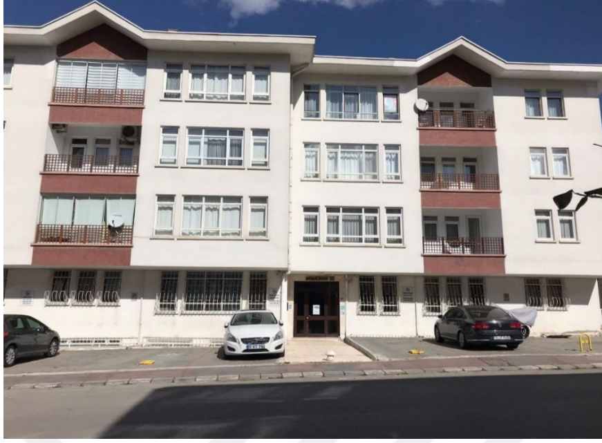
Şekil 3.14. Görünen yapı kalitesi iyi mevcut bir yapı
