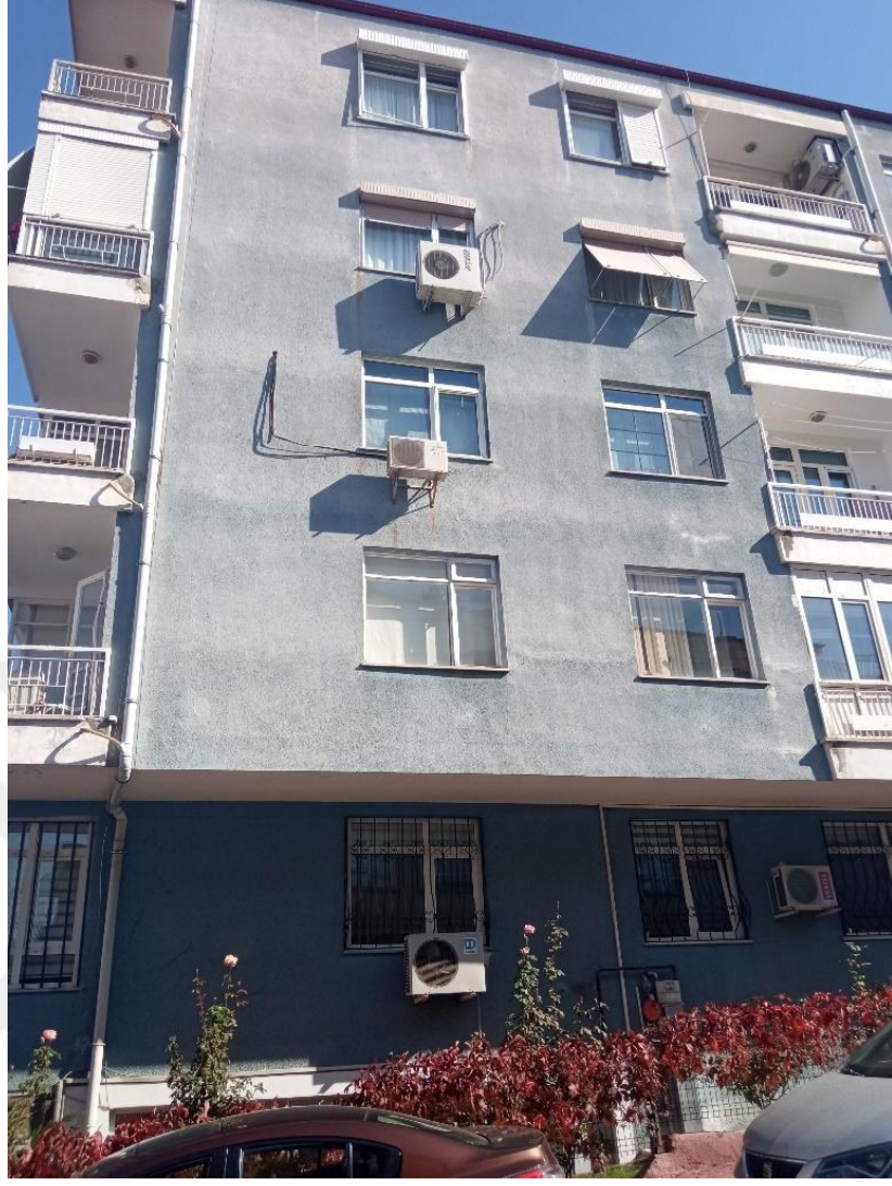
Şekil 3.9. Ağır çıkmalı mevcut bir yapı
