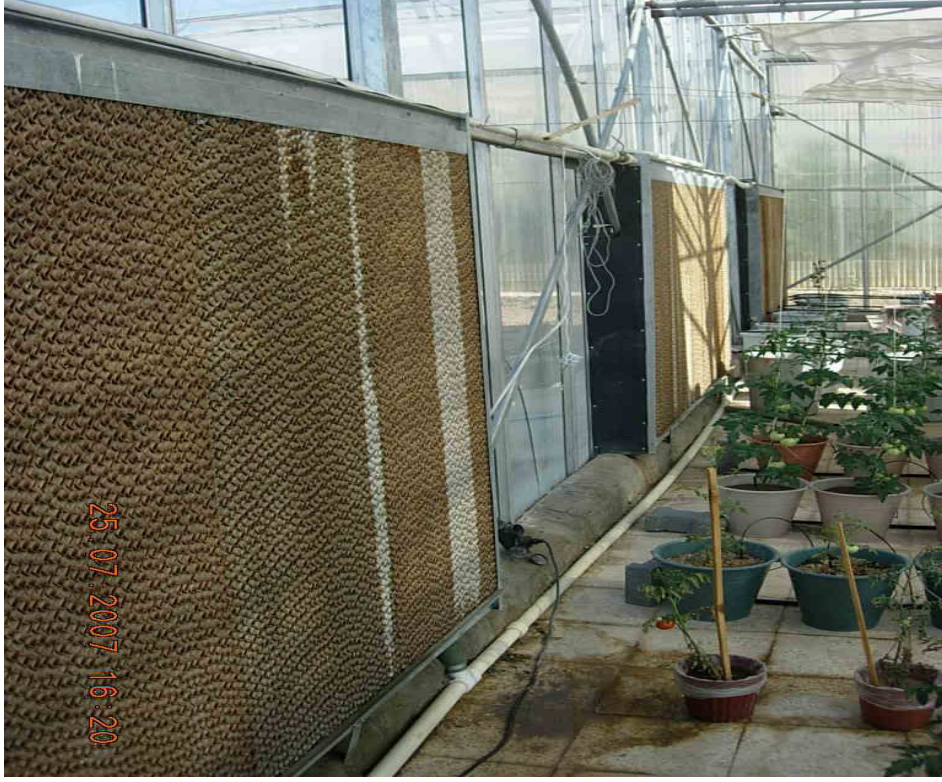
Şekil 3.1. Sera içindeki pedlerin görüntüsü
