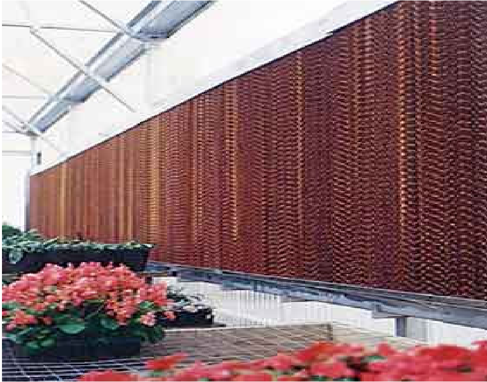
Şekil 2.5. Fan ped sistemi ile serinletme yapılan sera görüntüsü
