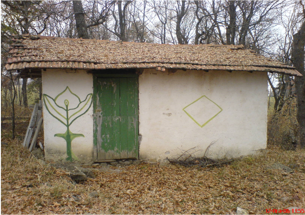
Resim 26: Ağca Dede türbesinin dıştan görünümü
