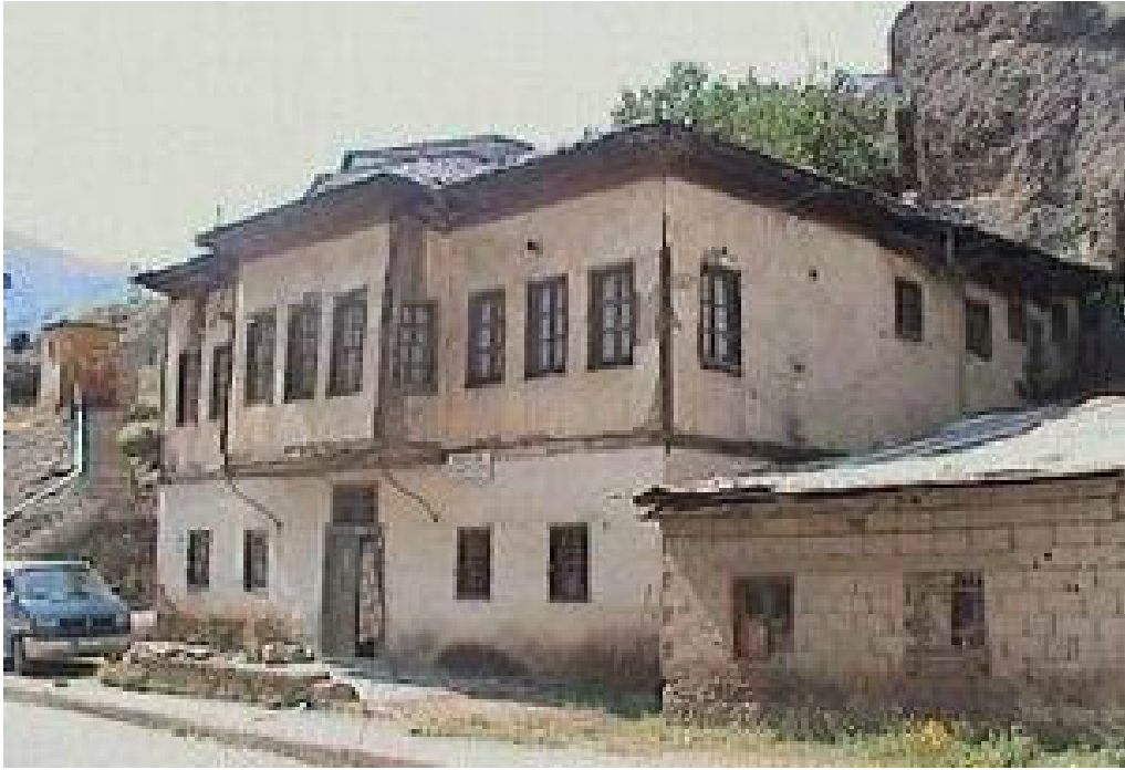
Resim 2.4. Gümüşhane Kelkit'te kerpiç yapı
