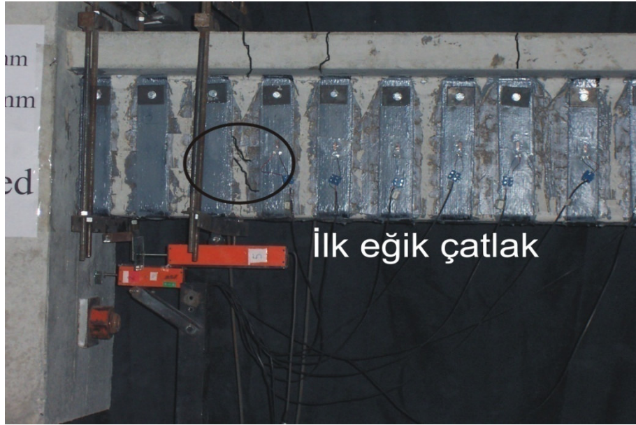
Şekil 3.36 İlk eğik çatlak, Deney Elemanı-6
