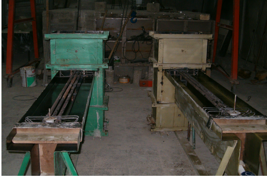
Şekil 2.15 Beton dökümüne hazır deney elemanları
