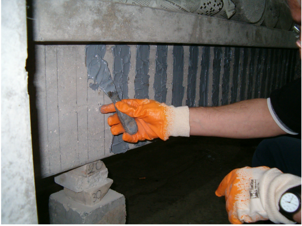
Şekil 2.17 Sikadur 330 (epoksi) uygulaması
