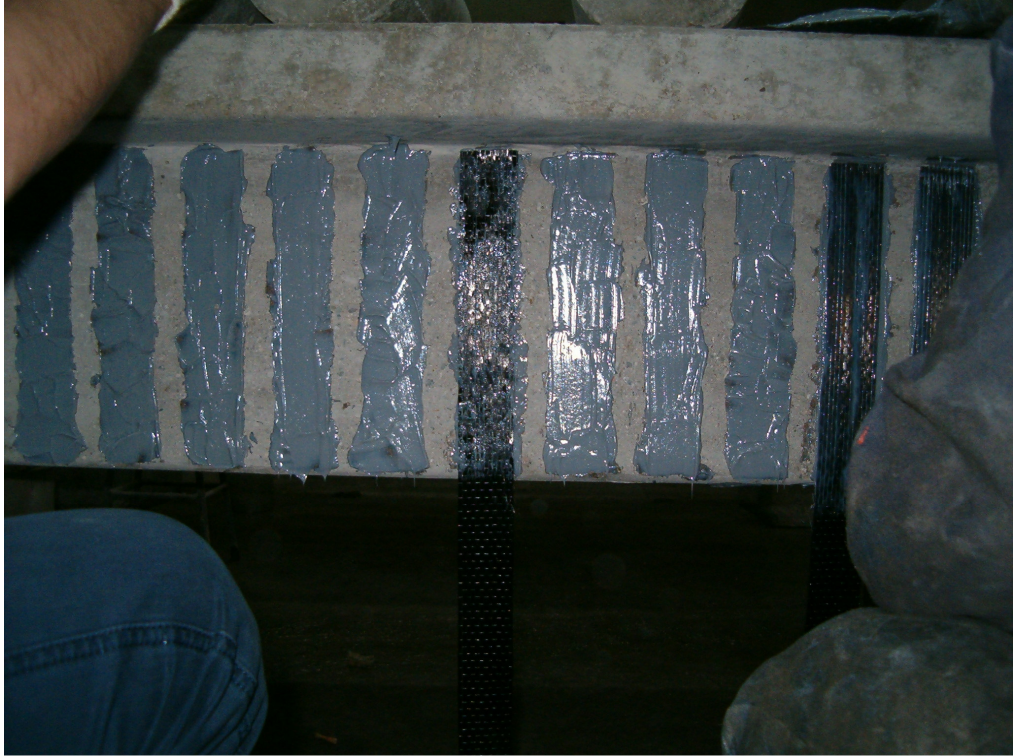
Şekil 2.18 CFRP şeritlerin yapıştırılması
