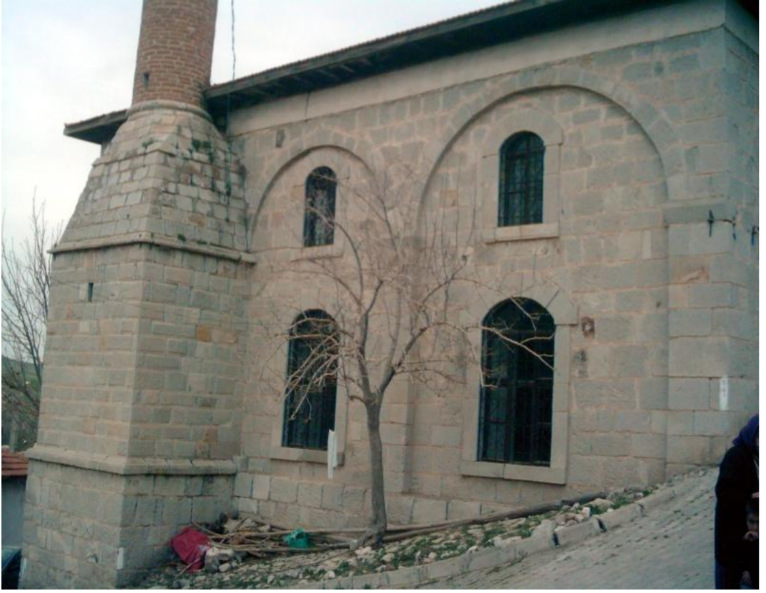
106. Resim: Tabakhane Camii, onarım öncesinde batı cephe
