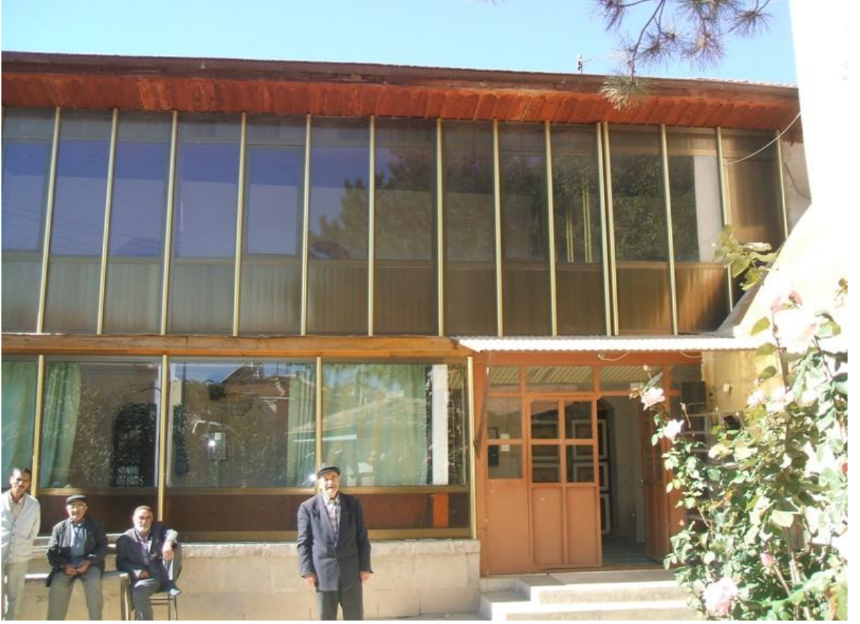
14. Resim: Çandır Köyü Camii, doğu cephe
