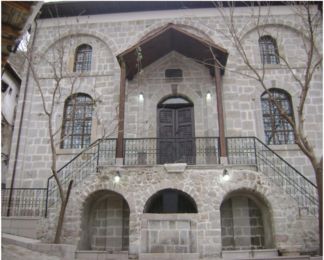
105. Resim: Tabakhane Camii, 2008 onarımından sonra kuzey cephe
