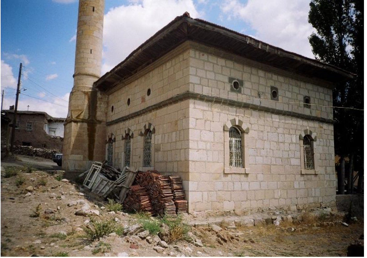
46. Resim: Gökçeören Köyü Camii, onarım sırasında, güneybatıdan görünüş (VGM Arşivi'nden)
