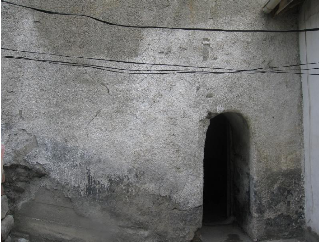
131. Resim: Çarşı Hamamı, güney cephe, kadınlar kısmına giriş kapısı
