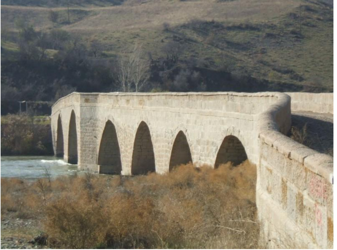
149. Resim: Kızılırmak Köprüsü Mensap Yönü
