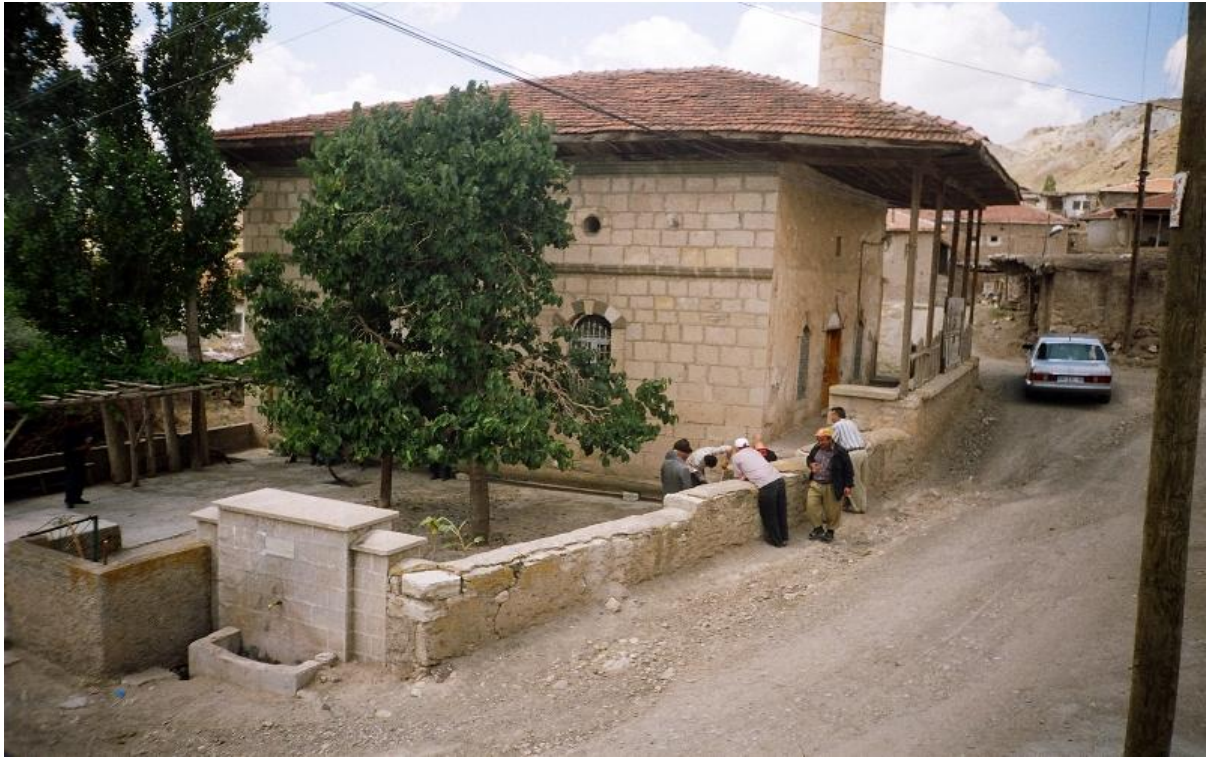
43. Resim: Gökçeören Köyü Camii, doğu cephe (VGM Arşivi'nden)
