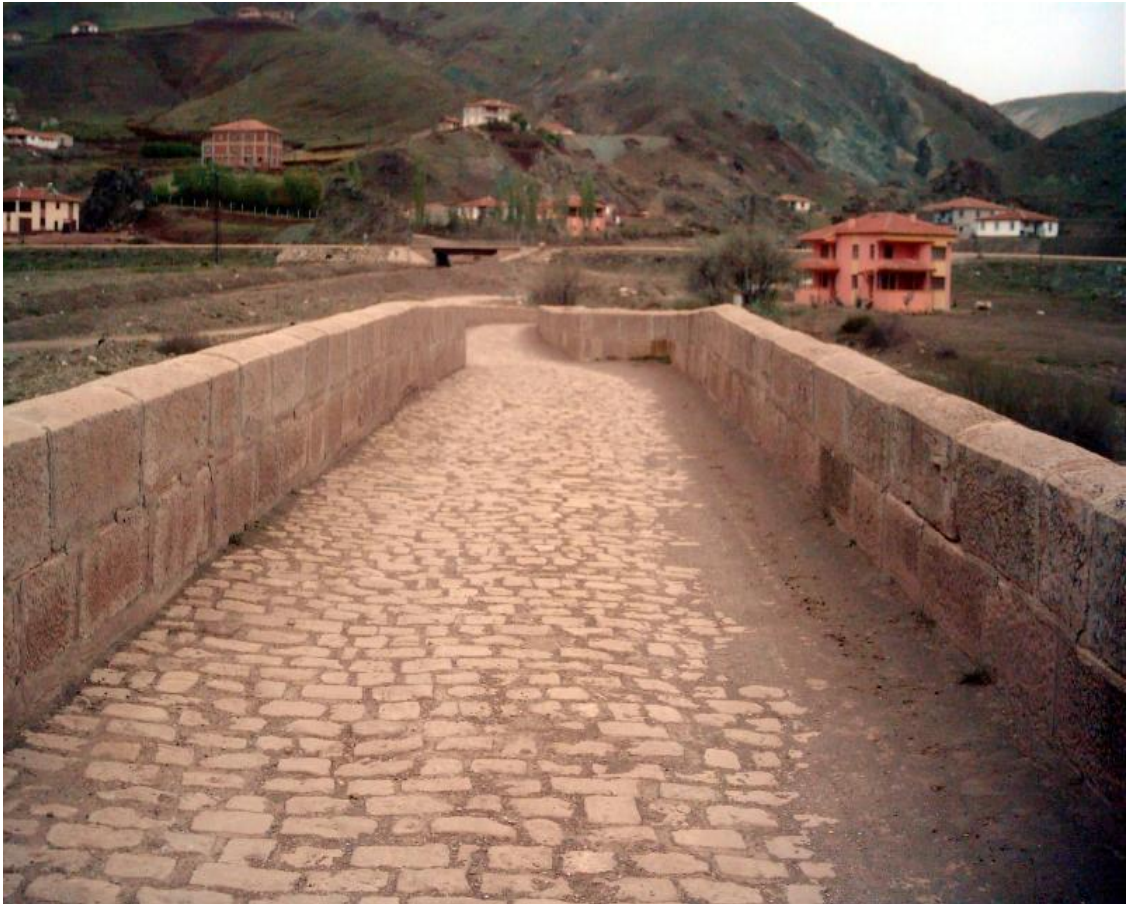
150. Resim: Kızılırmak Köprüsü, tabliye
