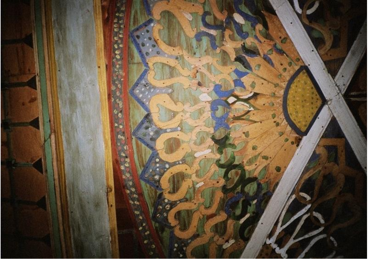
50. Resim: Gökçeören Köyü Camii, onarım öncesi tavan süslemesi (VGM Arşivi'nden)
