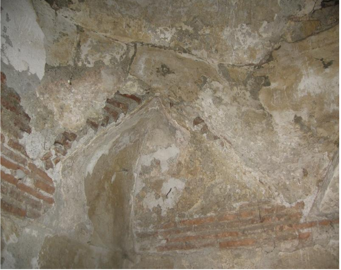
132. Resim: Çarşı Hamamı, aralık bölümü tromp
