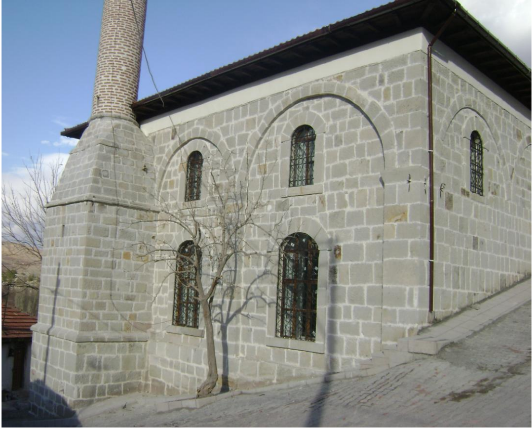
107. Resim: Tabakhane Camii, onarım sonrasında batı cephe
