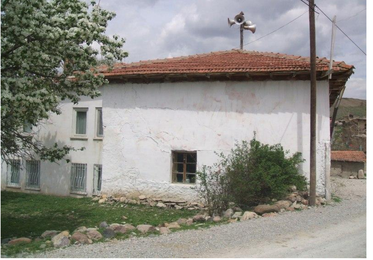
35. Resim: Eşmedere Köyü Camii, güney cephe
