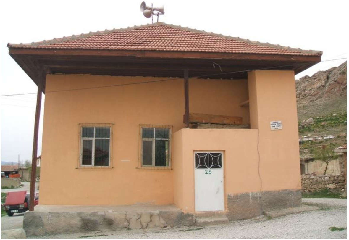
71. Resim: Kargın Köyü Camii, doğu cephe
