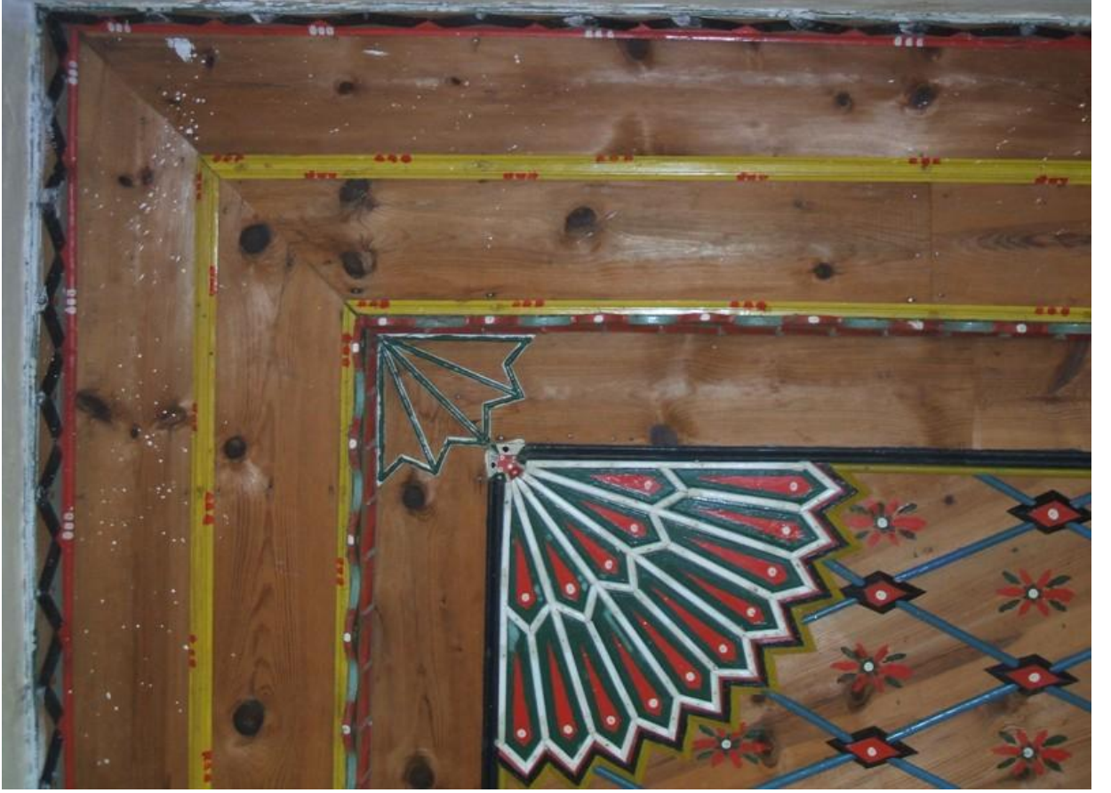
37. Resim: Eşmedere Köyü Camii, kuzeydoğu tavan köşeliği
