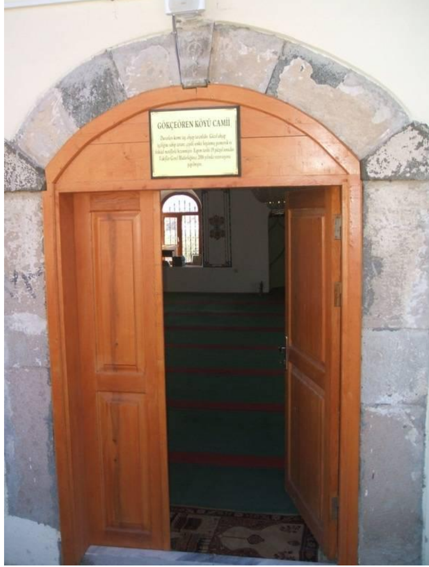
48. Resim: Gökçeören Köyü Camii, giriş kapısı ve onarım kitabesi
