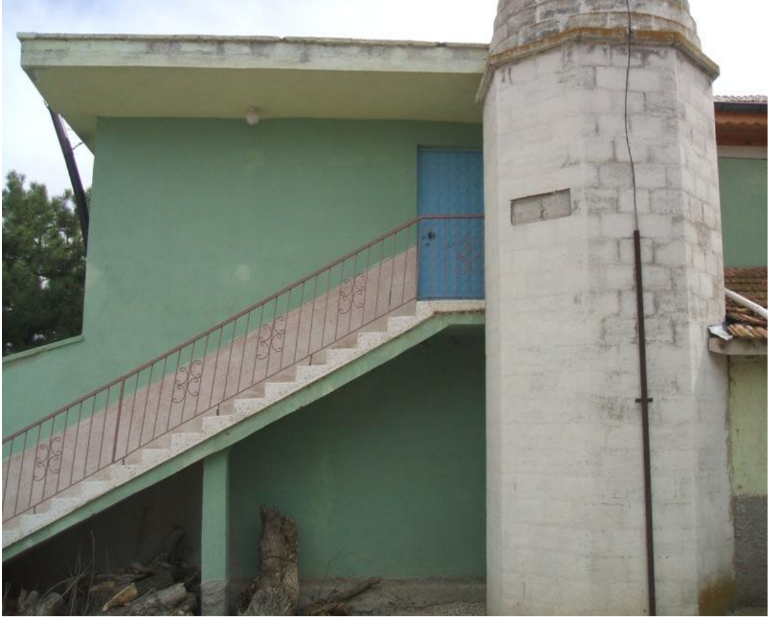
87. Resim: Kınık Köyü Camii, kuzey cephe ve kadınlar mahfiline açılan tali kapı
