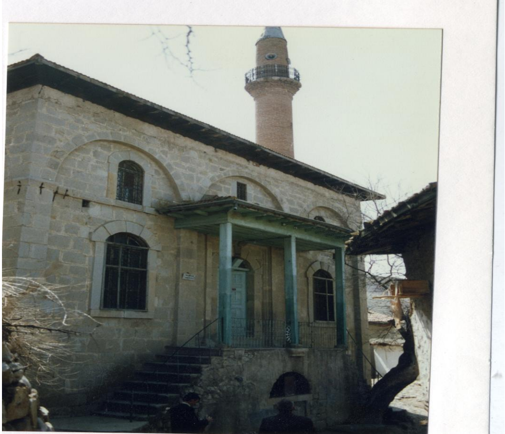
103. Resim: Tabakhane Camii, onarım öncesi kuzey cephe (VGM Arşivi'nden)
