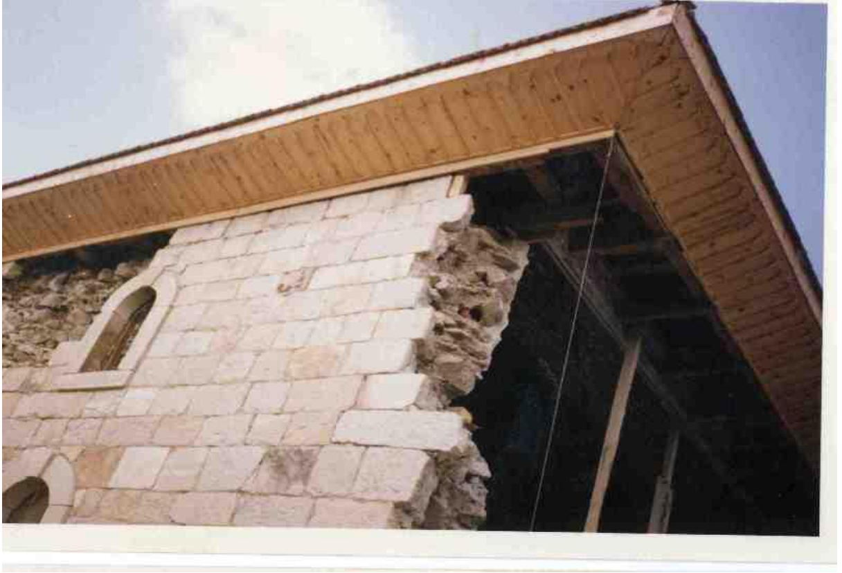
22. Resim: Çandır Köyü Cami Malzeme Ayrıntı (VGM Arşivi'nden)
