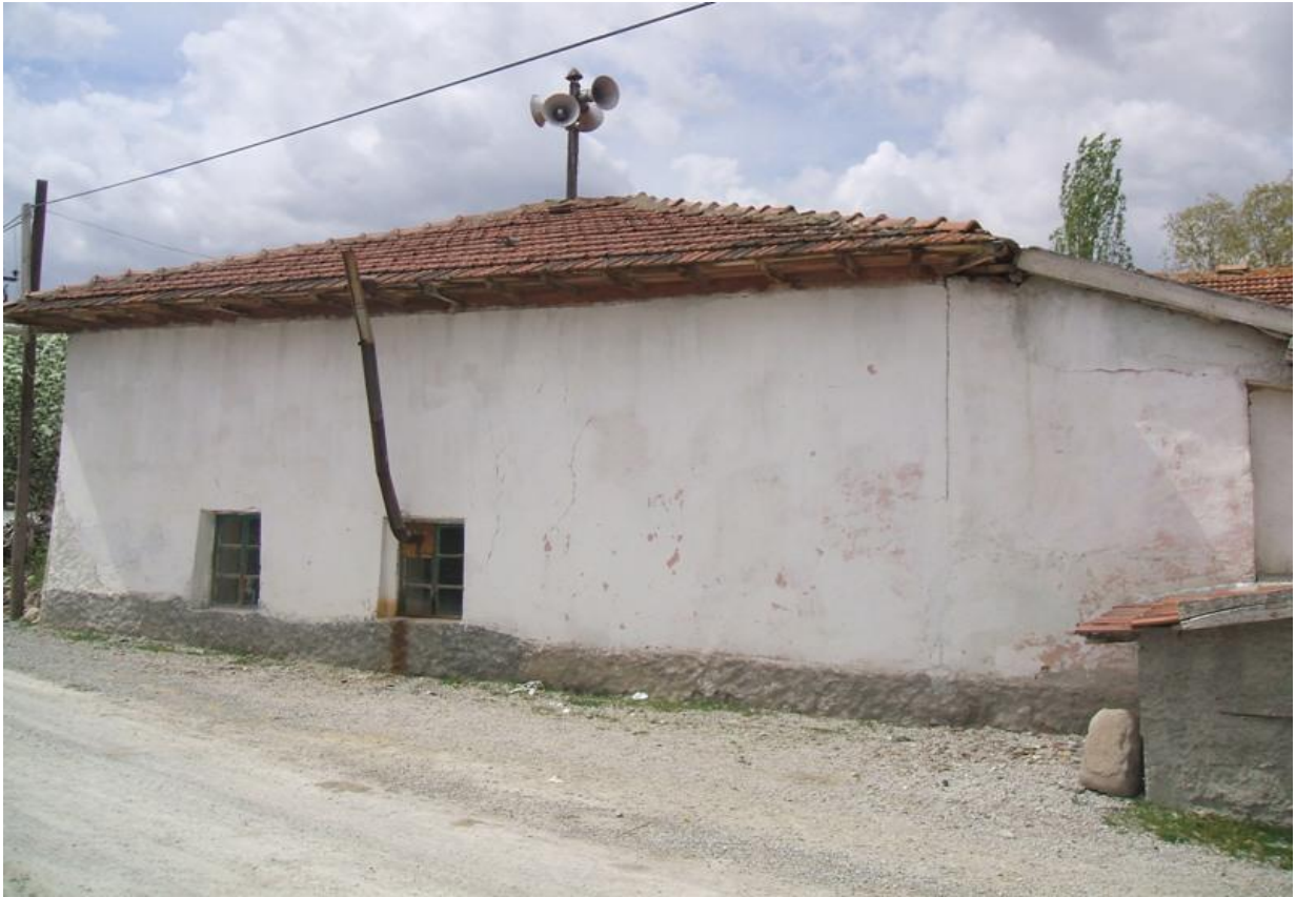
34. Resim: Eşmedere Köyü Camii, doğu cephe
