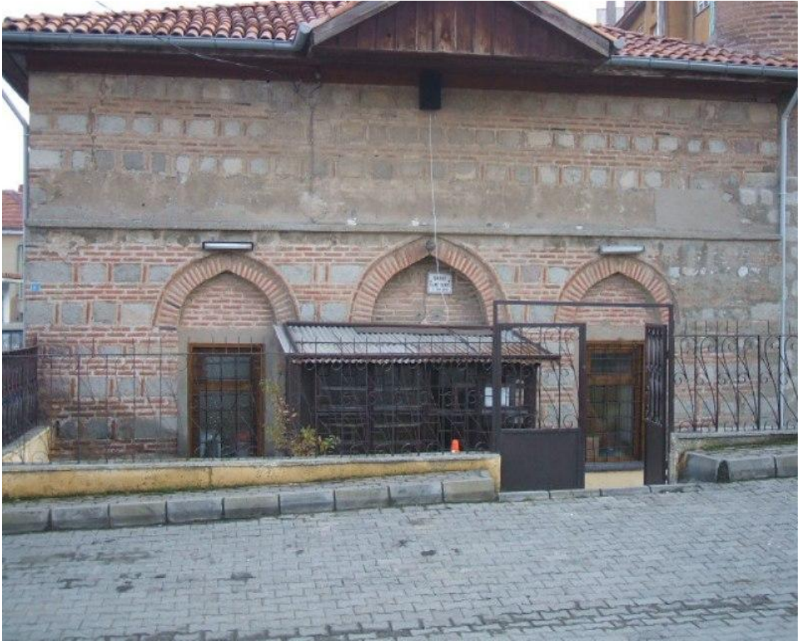
96. Resim: Saray Camii, kuzey cephe
