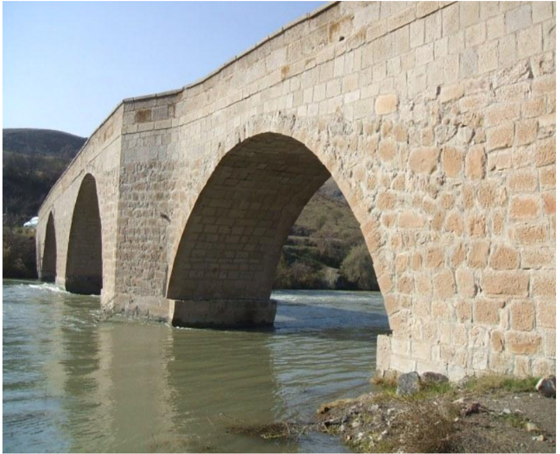
148. Resim: Kızılırmak Köprüsü Mensap Yönü
