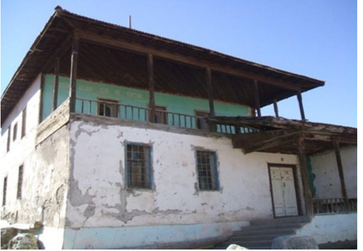
3. Resim: Altıntaş Köyü Camii, doğu cephe
