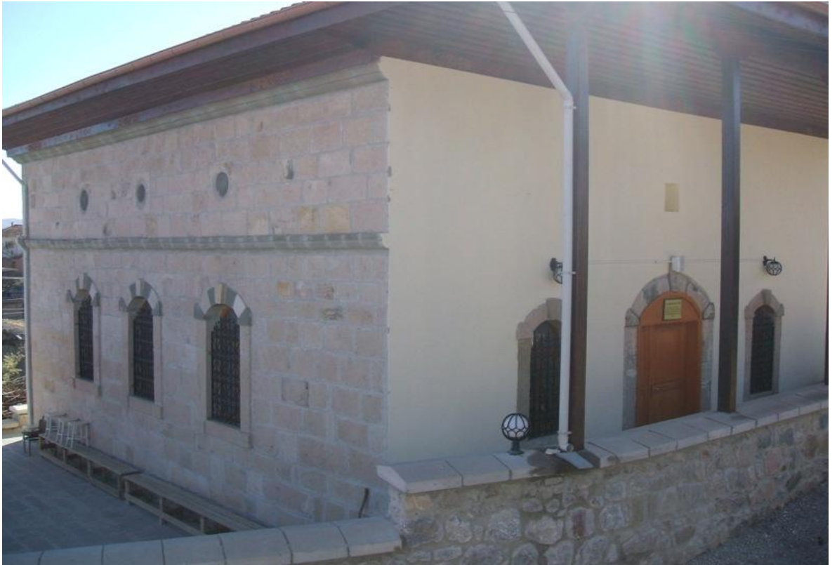
45. Resim: Gökçeören Köyü Camii, kuzeydoğudan görünüş
