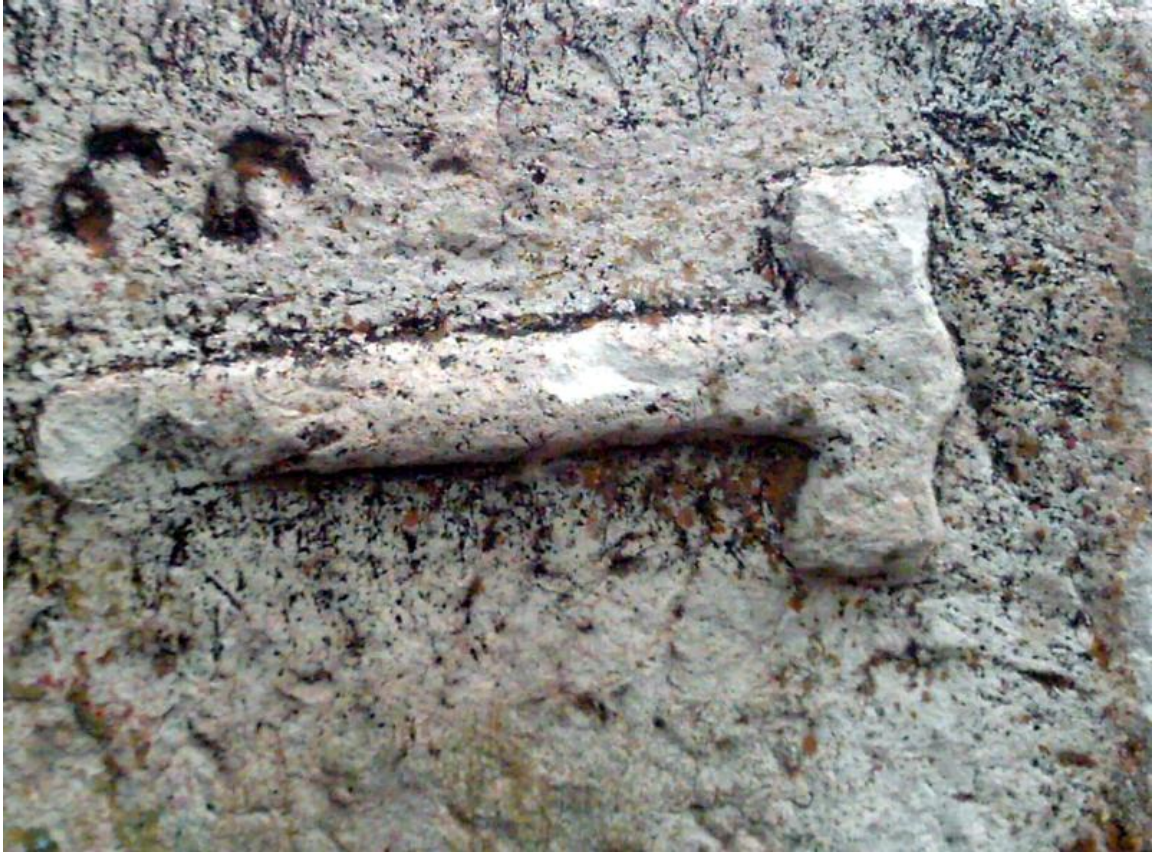
152. Resim: Kızılırmak Köprüsü, çekiç kabartması
