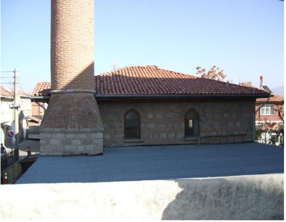
98. Resim: Saray Camii, batı cephe
