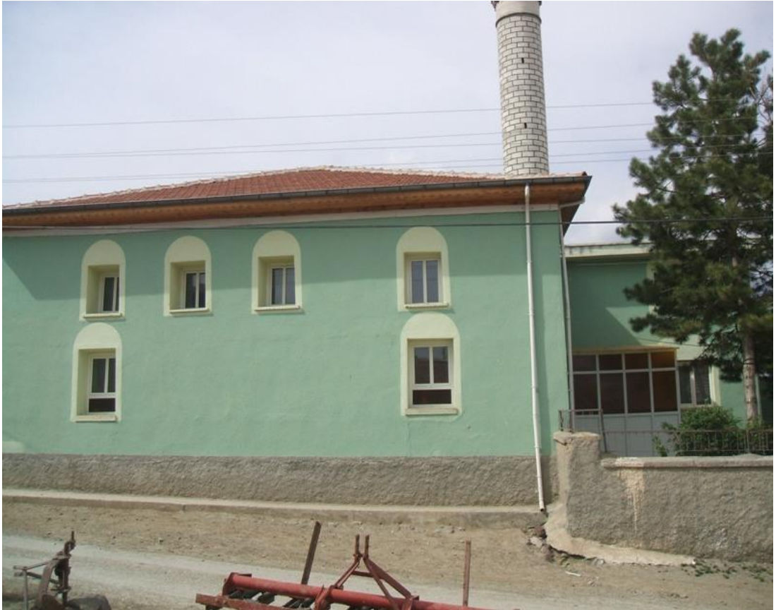
86. Resim: Kınık Köyü Camii, güney cephe
