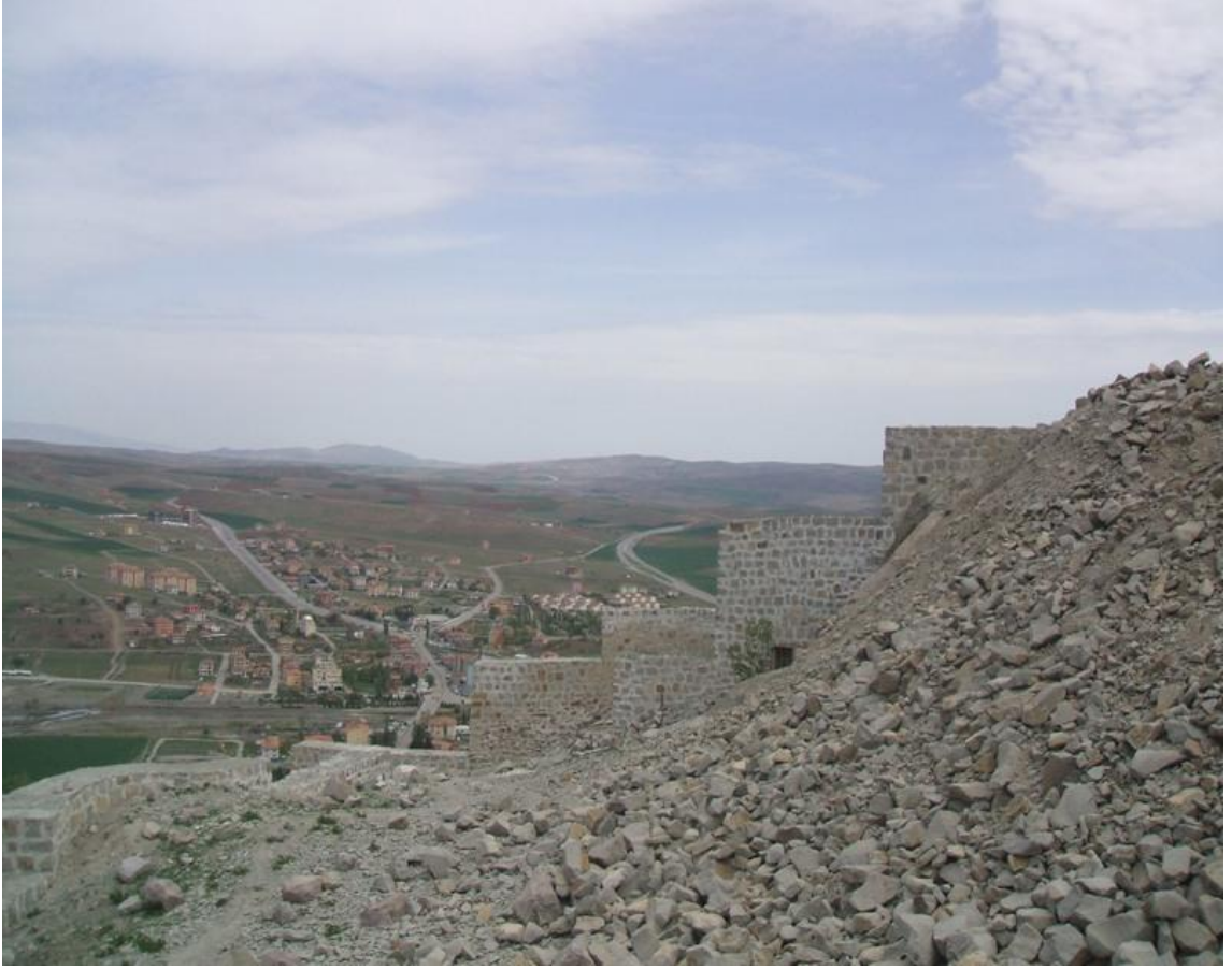
161. Resim: Kalecik Kalesi, batı cephesindeki burçlar
