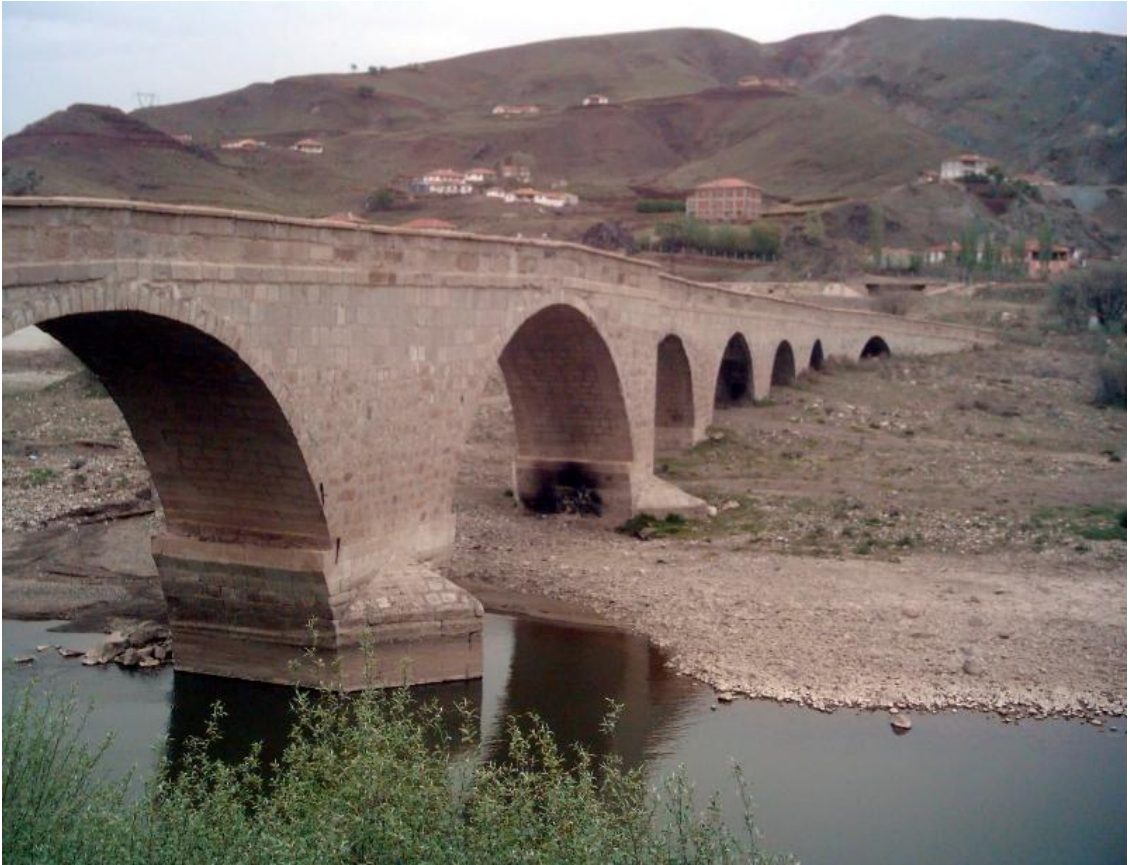
144. Resim: Kızılırmak Köprüsü, menba yönü
