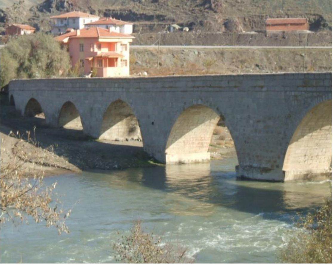
144. Resim: Kızılırmak Köprüsü, mensap yönü
