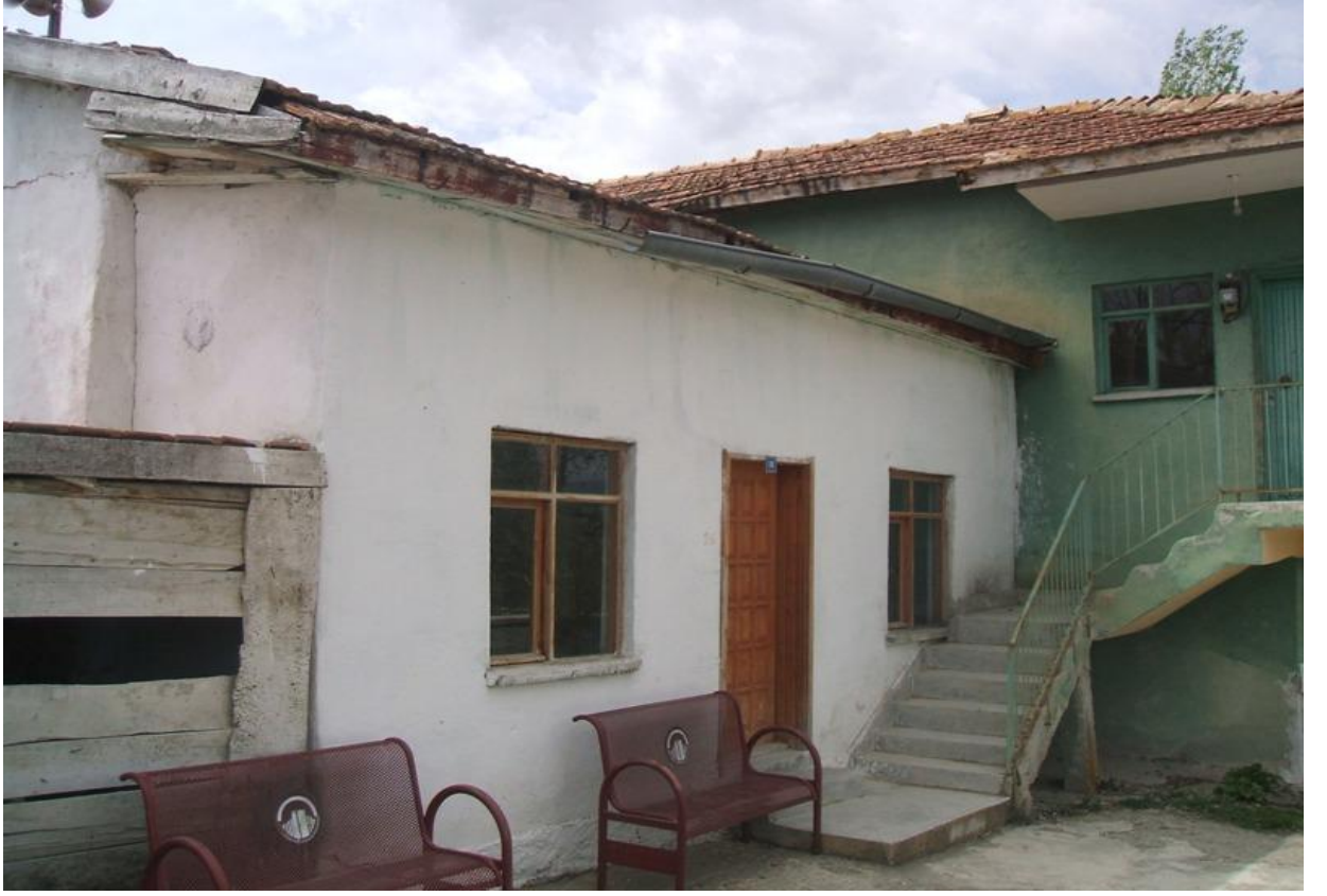
33. Resim :Eşmedere Köyü Camii, kuzey cephe
