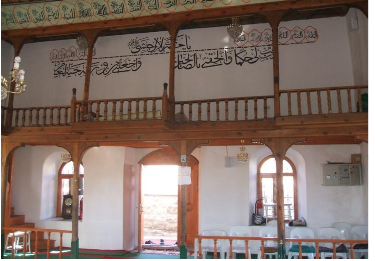
55. Resim: Gökçeören Köyü Camii, onarım sonrası, mahfil
