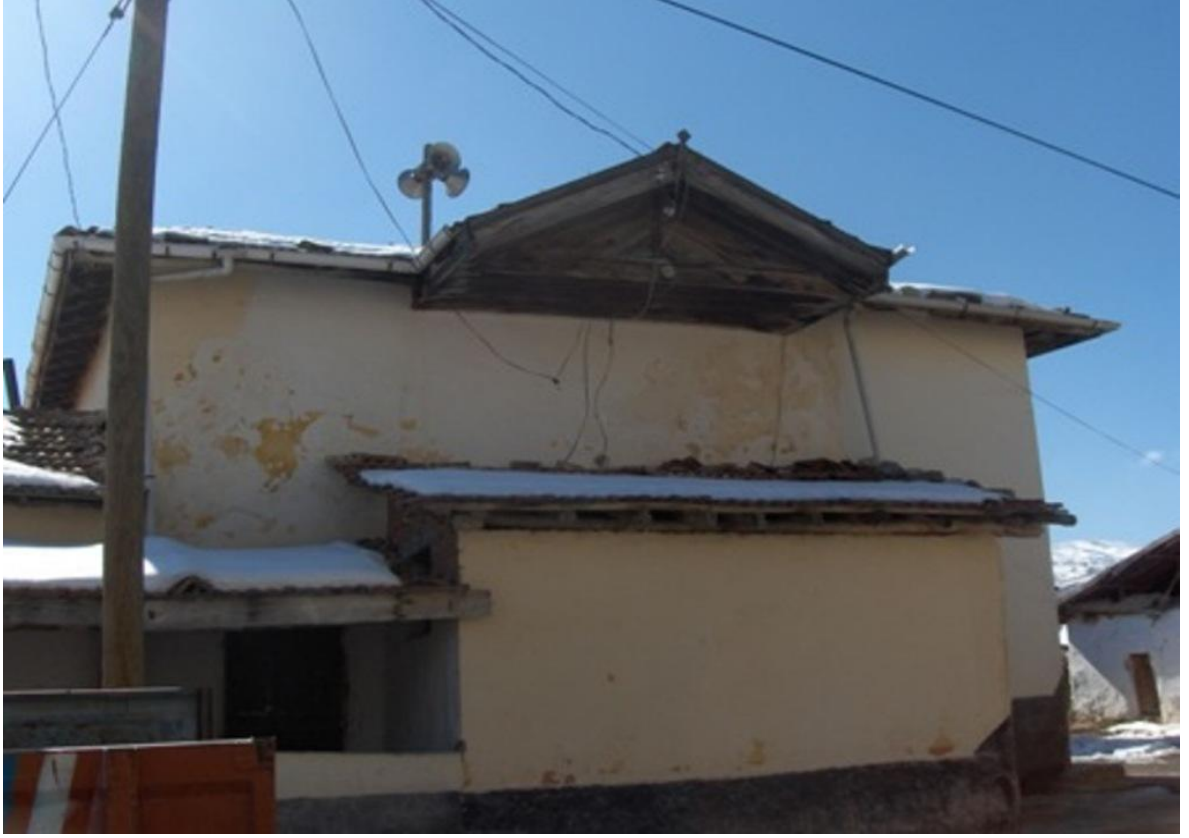
65. Resim: Kale Camii, kuzey cephe
