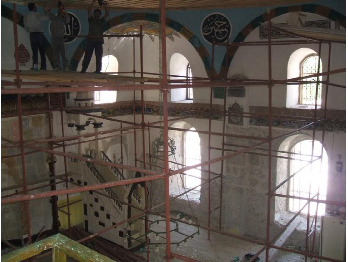
111. Resim: Tabakhane Camii, onarım sırasında harimden görünüş
