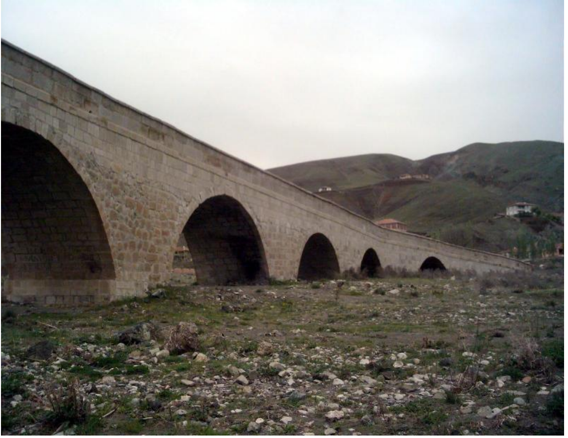
145. Resim: Kızılırmak Köprüsü, Menba Yönü
