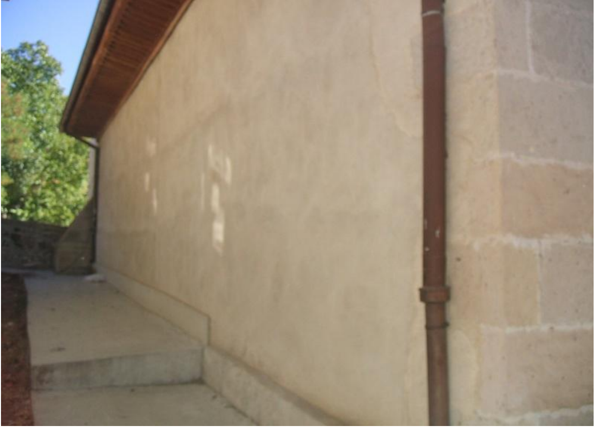
20. Resim: Çandır Köyü Camii, batı cephe
