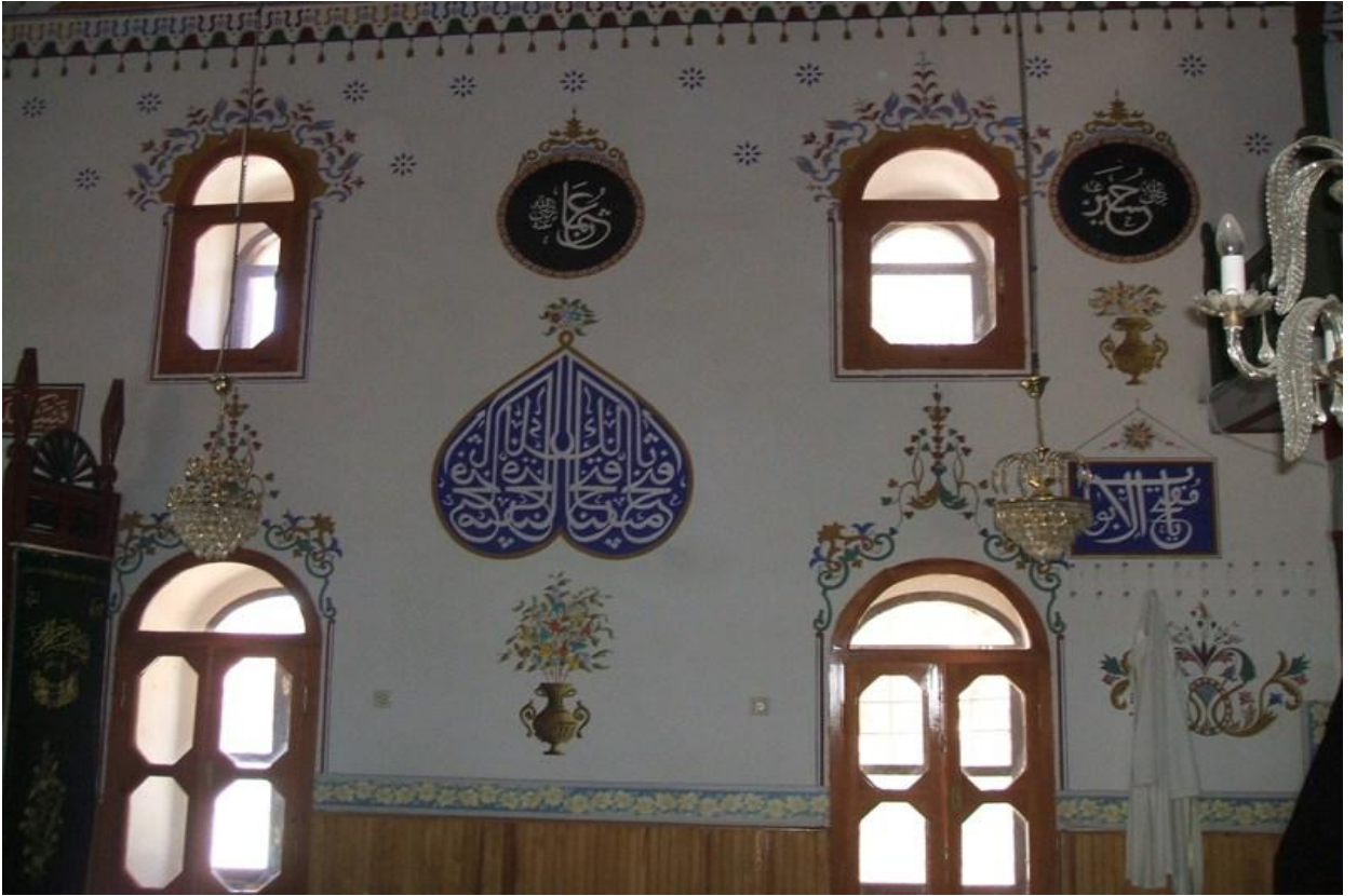
28. Resim:Çandır Köyü Camii, Batı cephesi kalemişi süslemeleri
