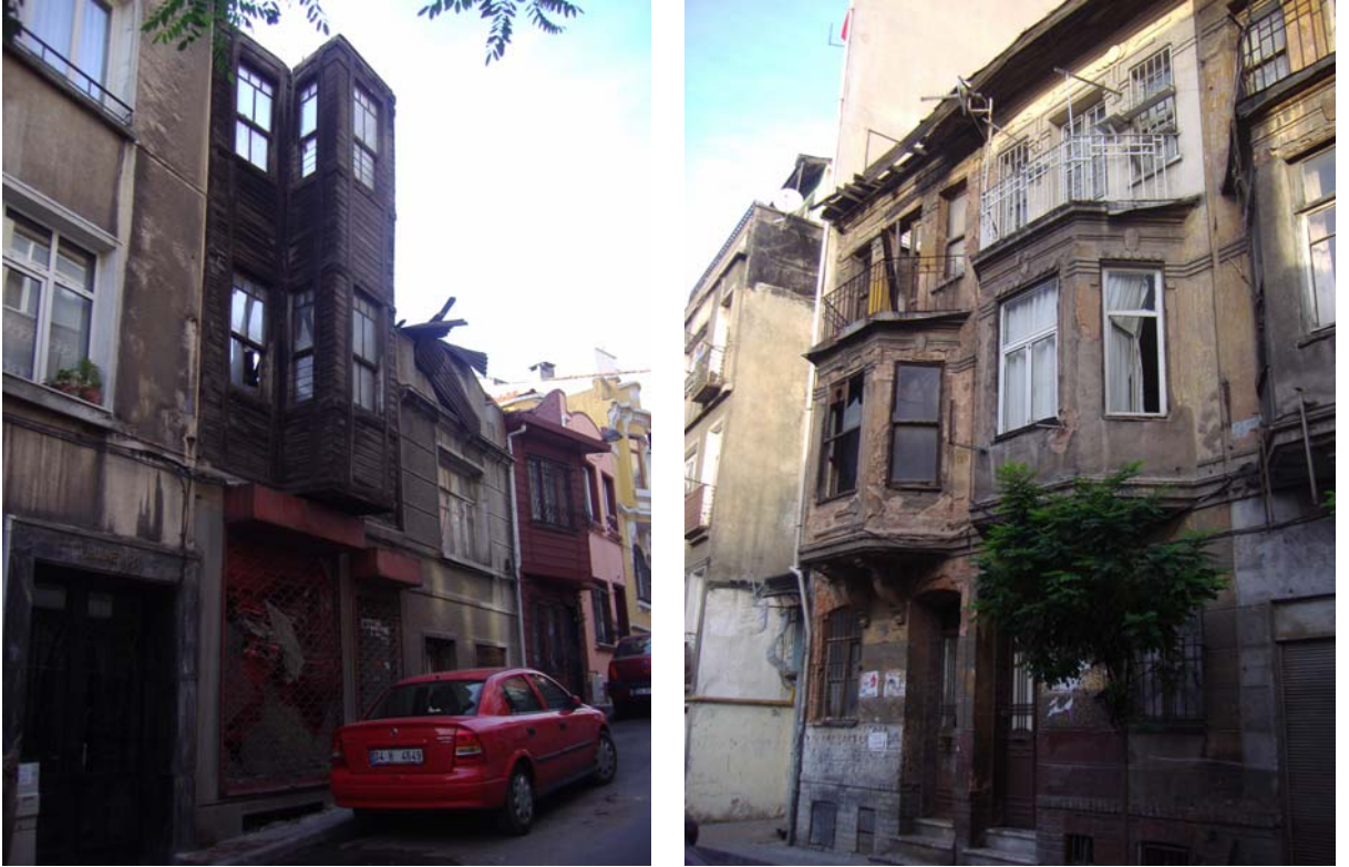
Şekil 4.11 Yunus Bey Sokak'ta yer alan Vakıflar Müdürlüğü'ne ait yapılar (C.Elgin)
