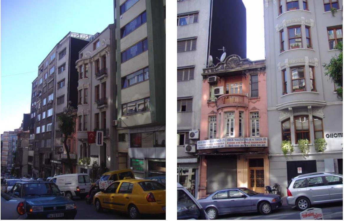
Şekil 5.8 Pangaltı'ya çıkan Dolapdere Caddesi'ndeki trafik sorunu (C.Elgin)
