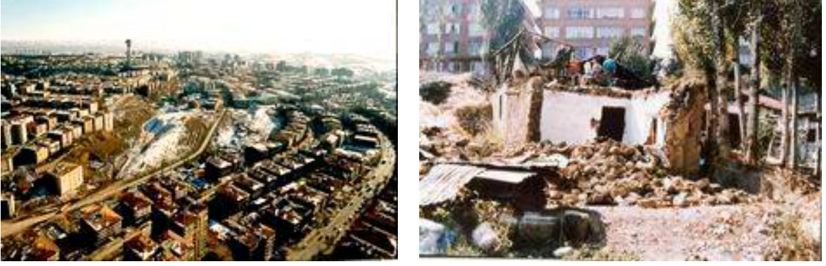
Şekil 3.27 Portakal Çiçeği alanı ve yıkım çalışmaları ( Göksu, 2004)
