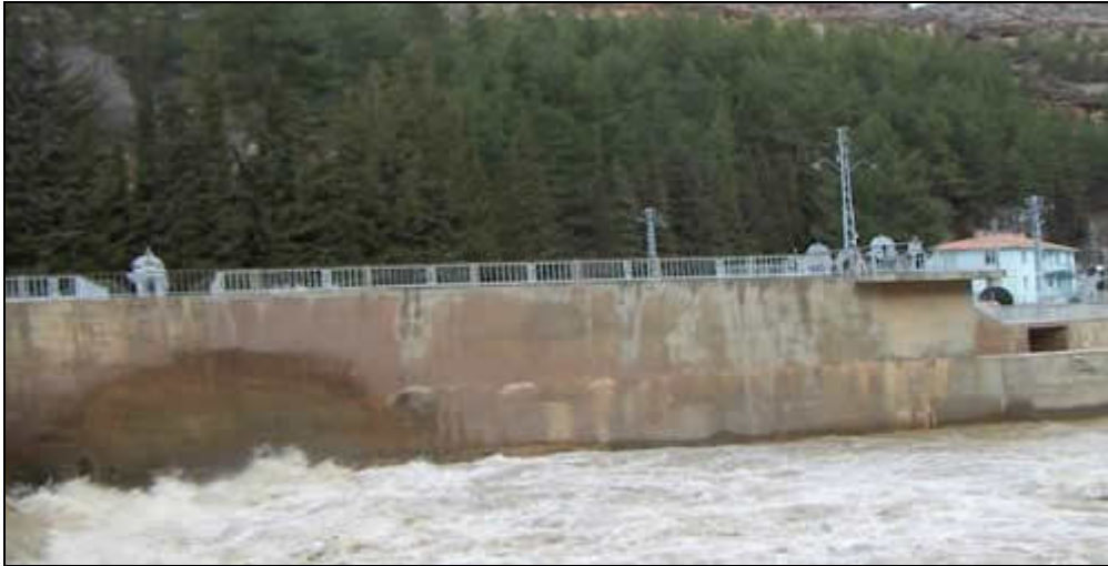
Resim 9: Göksu Hidroelektrik Santralinden Bir Görünüm.
