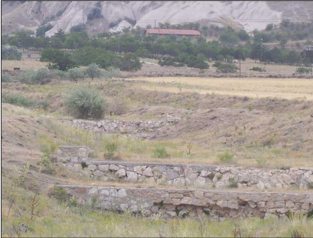
Foto 4.8: Keçili Deresi Doğusunda (Beyşehir Yolu-Sille Arası) Dere Islah Çalışmaları Yapılmış Bir Alan
