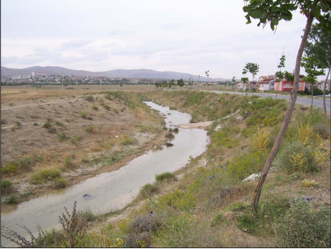
Foto 4.9: Keçili Deresi Tahliye Kanalı
