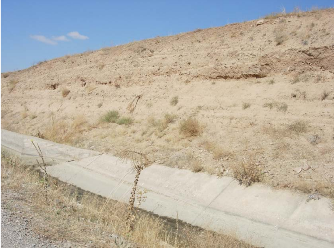
Foto 2.3. Çalışma alanındaki eski alüvyon taraçalarının görünümü
