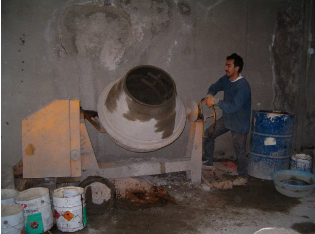
Resim 2.7. Betonun hazırlanması [21]
