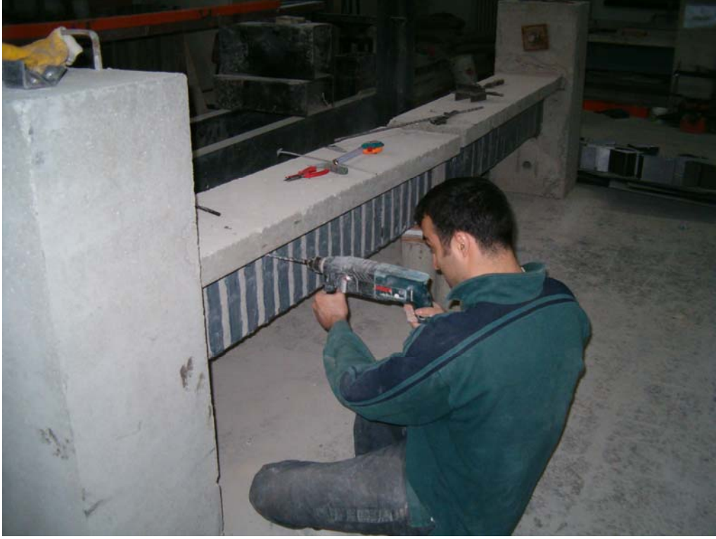
Resim 2.11. Ankraj deliklerinin açılması [21]
