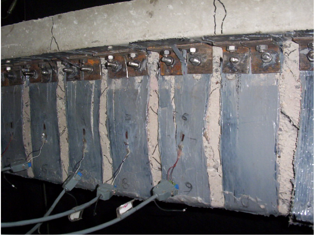
Resim 3.7. CFRP Őeritlerde meydana gelen soyulma ve yýrtýlmalar [21]
