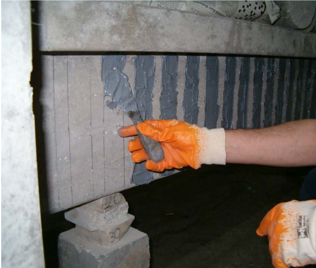
Resim 2.10. Epoksinin sürülmesi [21]
