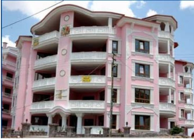
Resim 2.20. Keçiören Belediyesinde ön cephesi dekore edilmiş bir apartman bloğu
