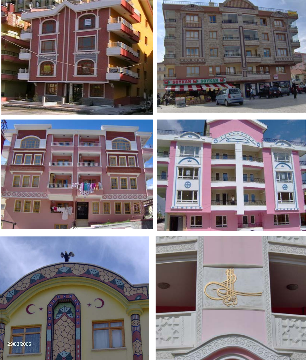
Resim 2.22. (Devam) Dekore edilmiş cepheleri ile Keçiören Apartman blokları
