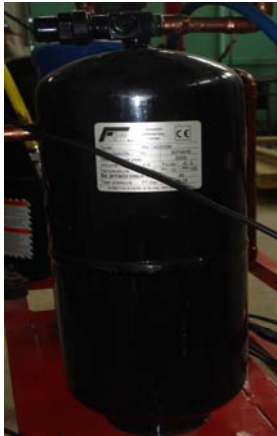
EK 1.6. Soğutucu akışkan için kullanılan sıvı deposunun resmi ve teknik özellikleri
