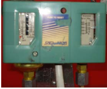
EK 1.8. Alçak ve yüksek basınç otomatığının görünümü
