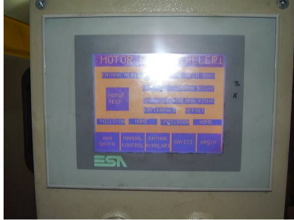
Şekil 7.5. Servo Motorlu Kaynak Kabin Kontrol Ünitesi
