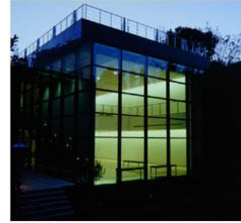
Resim 3.16 SSM- Dış Görünüm
