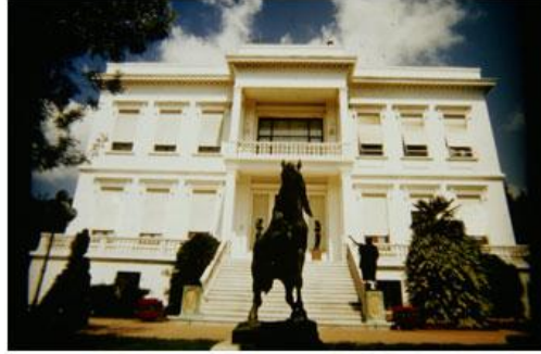
Resim 3.15. SSM- Dış Görünüm
