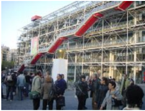
Resim 2.1. Pompidou Dış Görünüş
