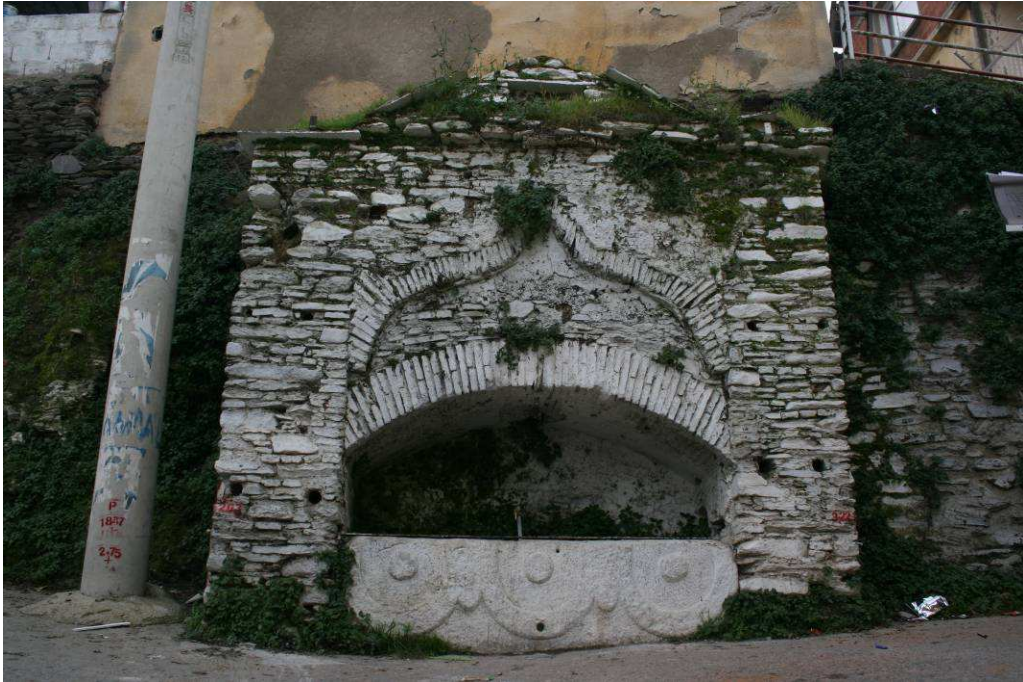
Resim 12: Tire Çatal Çeşme Genel Görünüşü
