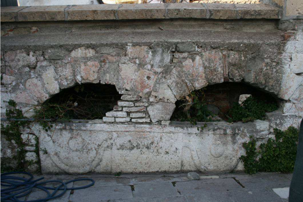
Resim 10: Bergama Ansarlı Camii Çeşmesi Arka Cephesi
