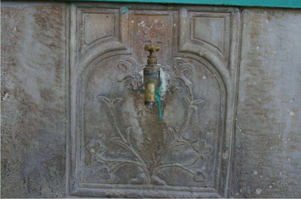
Resim 187: Tire Yalınayak Camii Şadırvanı Su Haznesi Panosu
