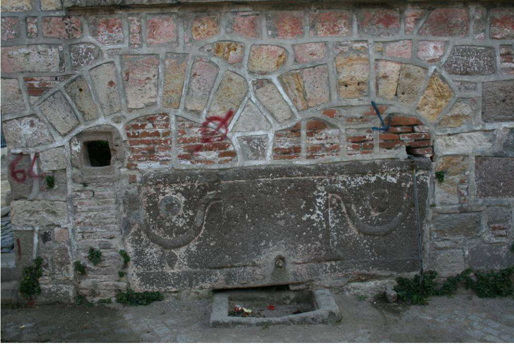
Resim 9: Bergama Ansarlı Camii Çeşmesi Genel Görünüşü
