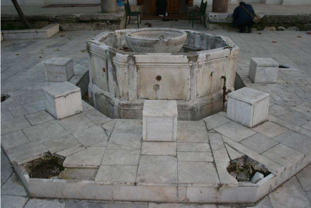
Resim 178: Tire Yeşil İmaret Camii Şadırvanı Su Haznesi
