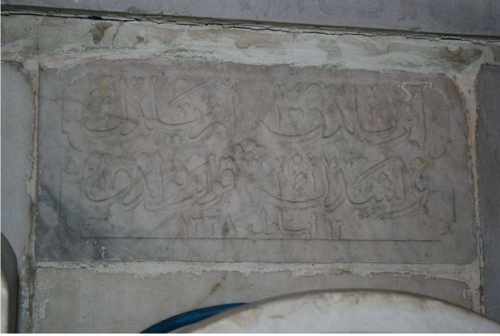
Resim 129: Ural Ahmet Ağa Çeşmesi Güney Cephe Kitabesi
