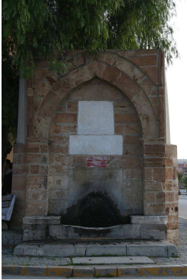
Resim 61: Çeşme Hacı Saliha Çeşmesi Genel Görünüşü
