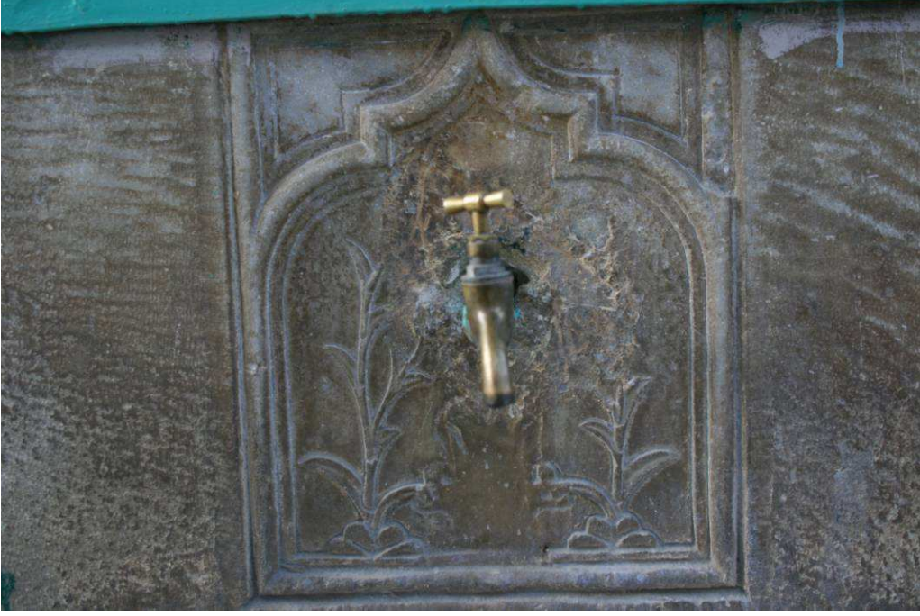
Resim 185: Tire Yalınayak Camii Şadırvanı Su Haznesi Panosu
