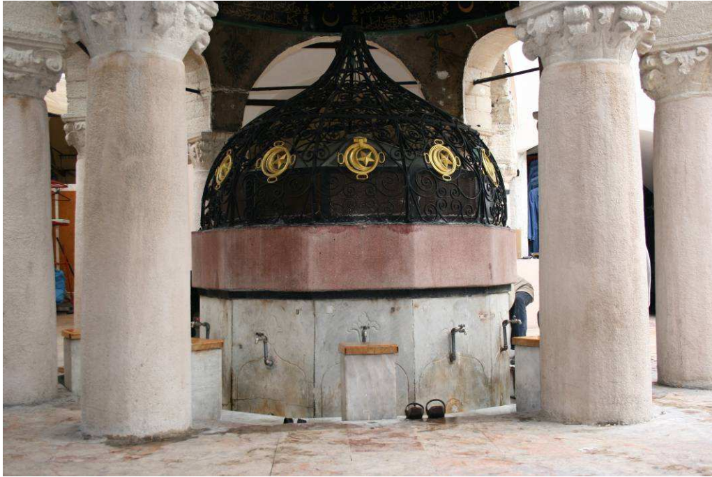
Resim 208: İzmir\Merkez Şadırvanaltı Camii Şadırvanı Su Haznesi
