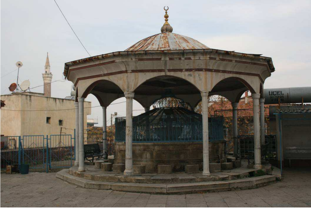
Resim 251: Tire Yeni Camii Şadırvanı Genel Görünüşü
