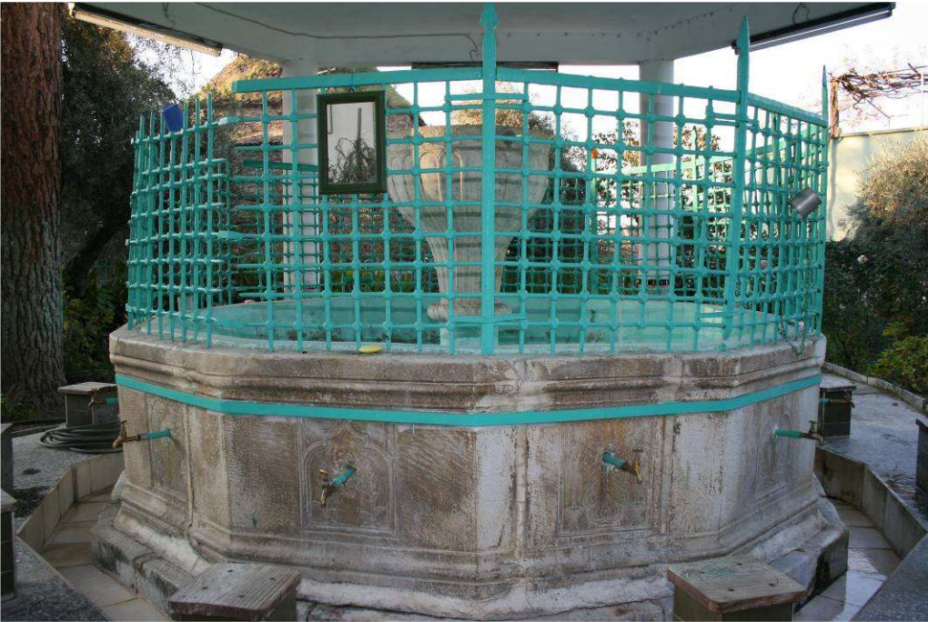
Resim 184: Tire Yalınayak Camii Şadırvanı Su Haznesi
