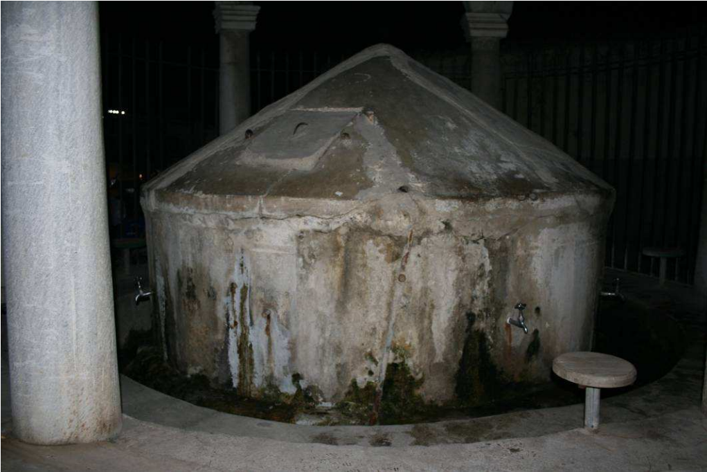
Resim 244: Urla Hacı Turan Kapan Camii Su Haznesi
