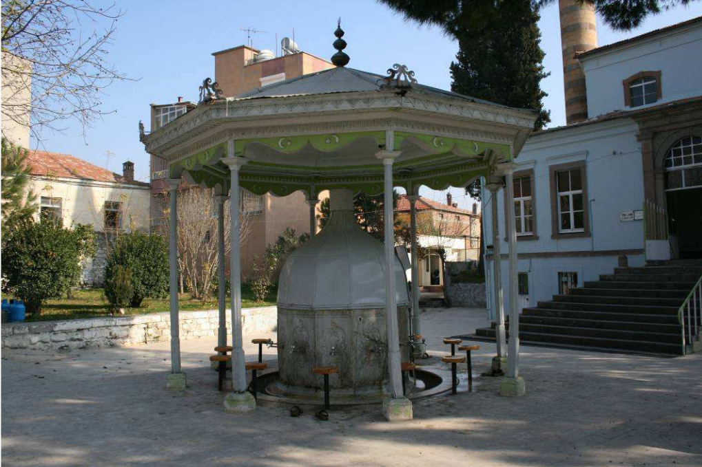
Resim 214: Bergama Yeni Camii Şadırvanı Genel Görünüşü
