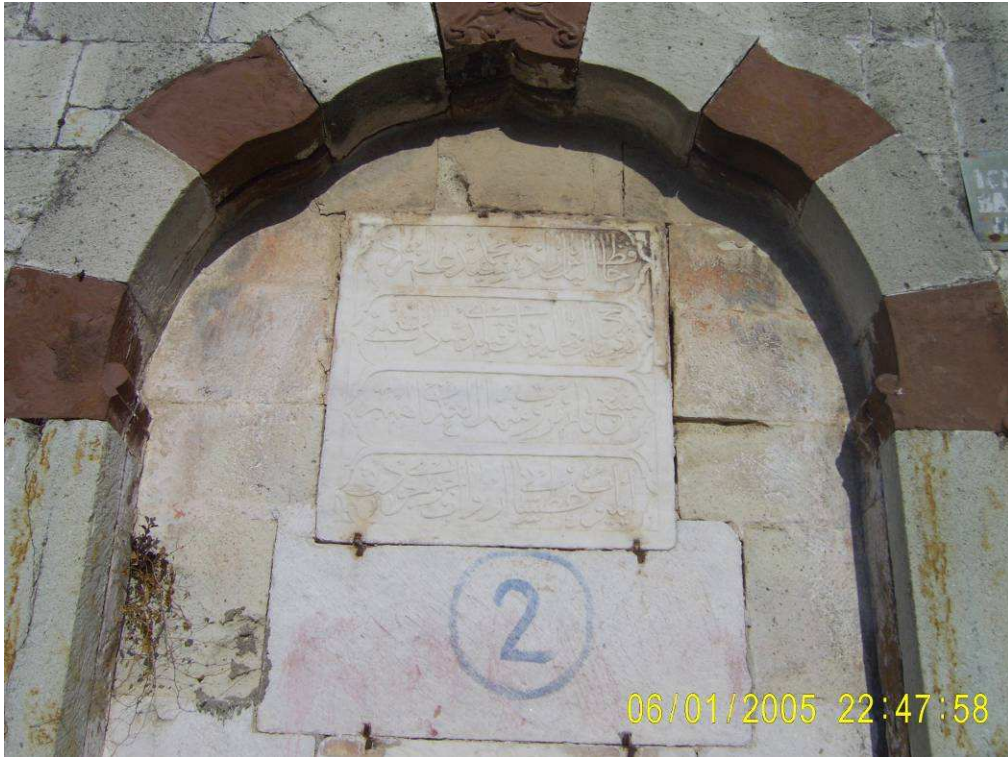
Resim 28: Çeşme Maraş Çeşmesi Batı Cephe Kitabesi
