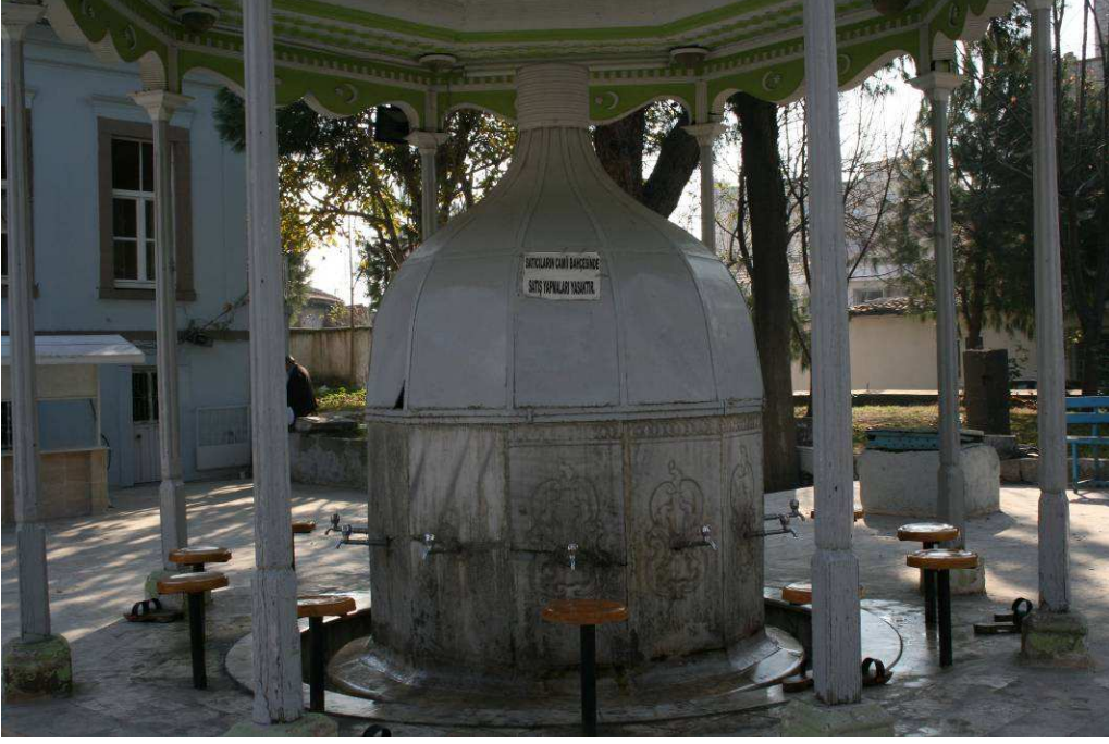
Resim 215: Bergama Yeni Camii Şadırvanı Su Haznesi
