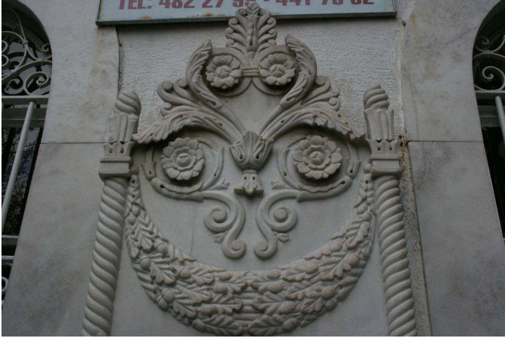
Resim 109: İzmir Merkez Hisar Camii Avlu Çeşmesi Taç Kısım
