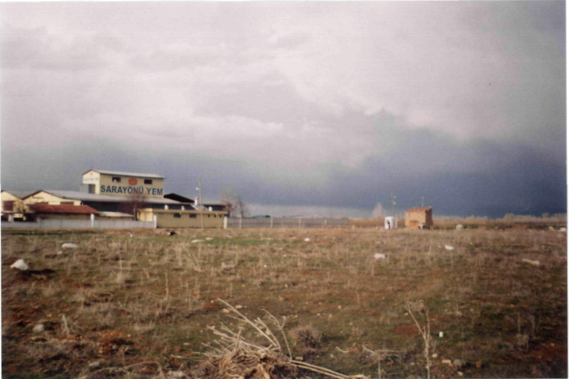
Foto I. 18- Sarayönü Yem Fabrikası
