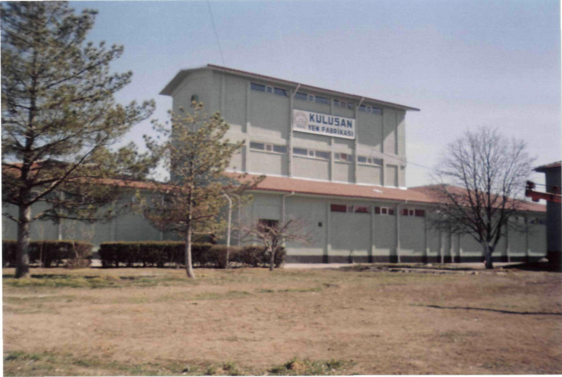
Foto I. 15- Kulu ilçesinde bulunan Kulusan Yem Fabrikası
