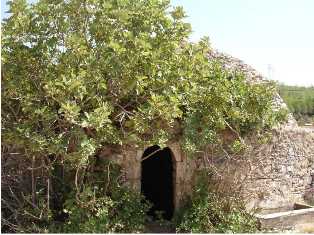
Fotoğraf 38. Muğla, Yatağan İlçesi Kavak Köyü Girişinde Bulunan Sarnıç, Genel Görünüş
