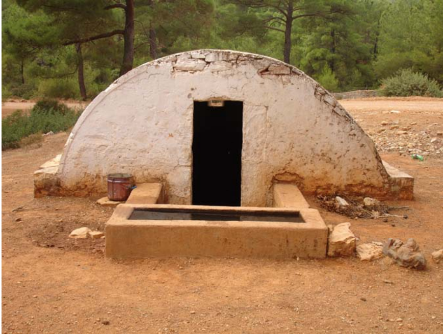
Fotoğraf 63. Muğla, Bodrum İlçesi, Yalı Köyü Sarnıcı 4 Giriş Cephesi ve Yalak
