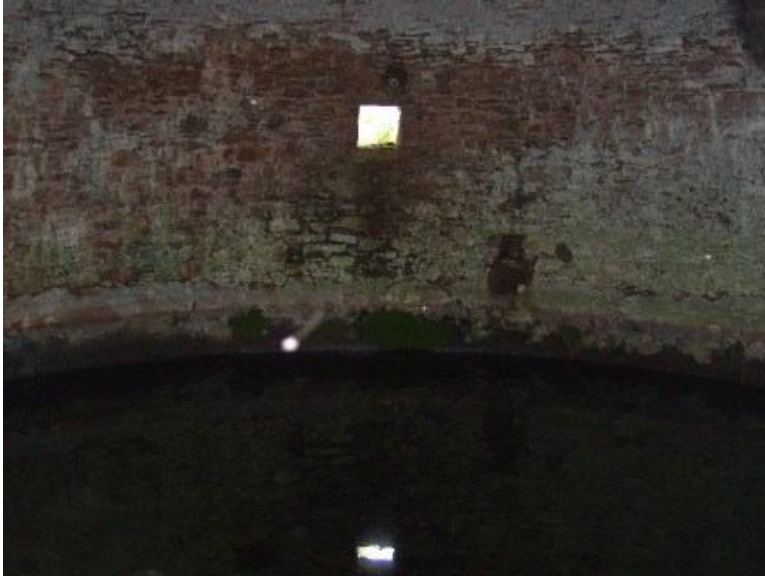
Fotoğraf 5. Muğla, Aydın Yolu Yerkesik Kavşağındaki Sarniç İç Görünümü
