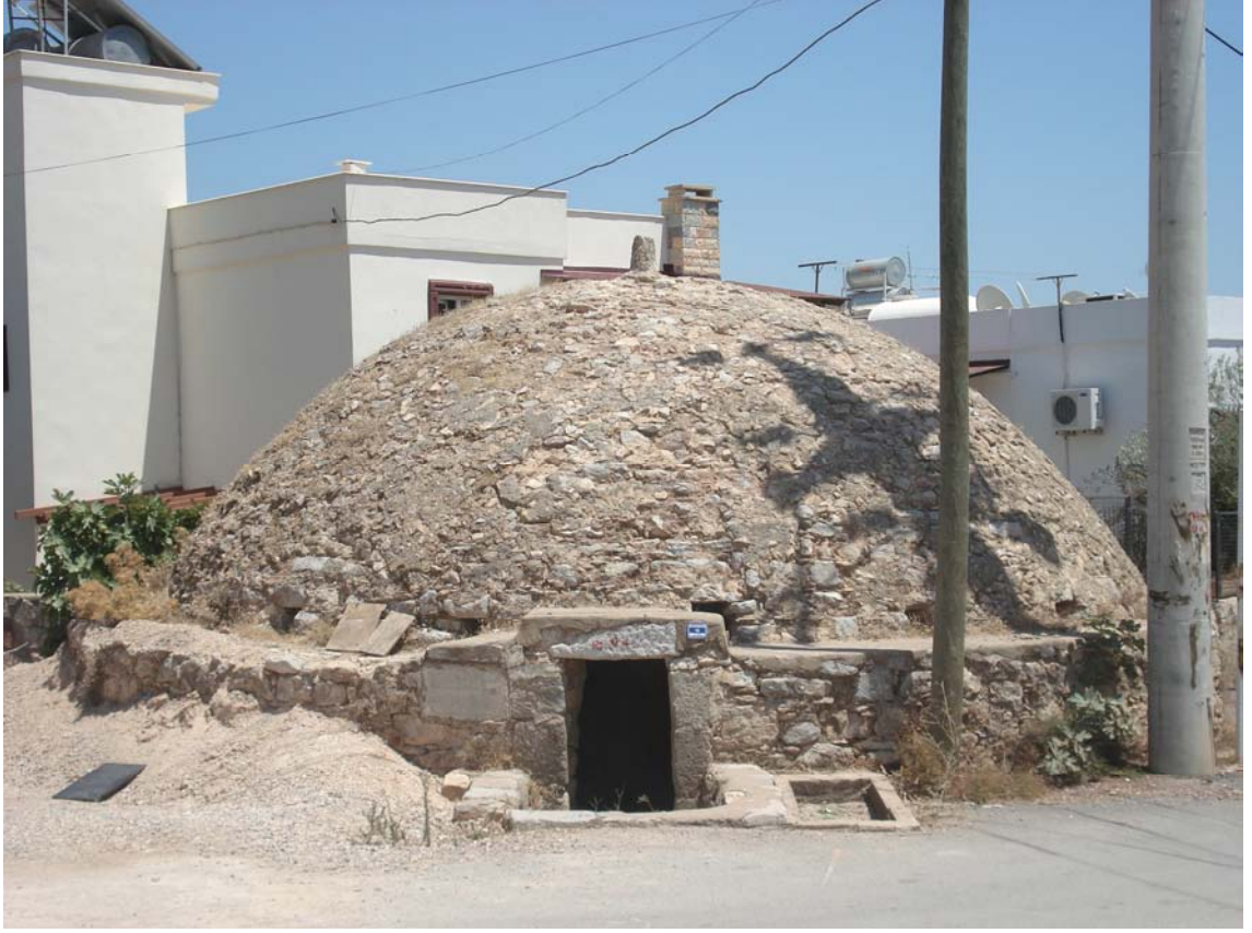
Fotoğraf 42. Muğla, Bodrum İlçesinde Bulunan Sarnıç 1 Genel Görünüş
