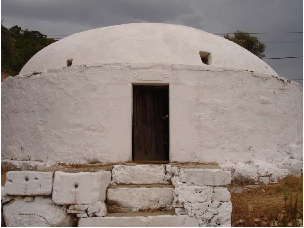
Fotoğraf 46. Muğla, Bodrum İlçesinde Bulunan Sarnıç 3 Genel Görünüş
