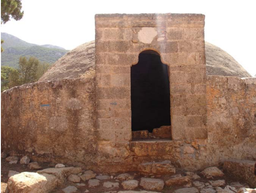
Fotoğraf 120. Muğla, Fethiye İlçesi, Boğaziçi Köyü Sarnıcı 2 Giriş Cephesi
