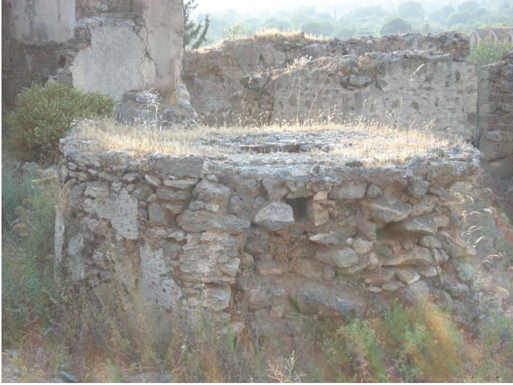
Fotoğraf 132. Muğla, Fethiye İlçesi, Kaya Köyü Sarnıcı 3 Genel Görünüş
