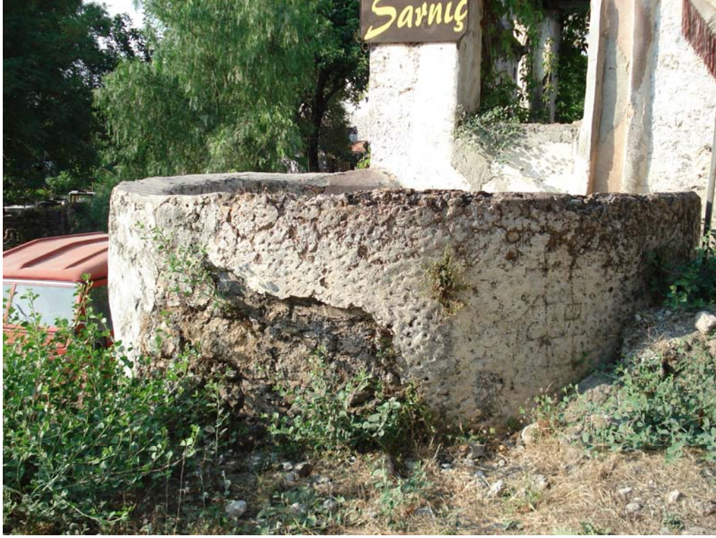
Fotoğraf 128. Muğla, Fethiye İlçesi, Kaya Köyü Sarnıcı Genel Görünüş
