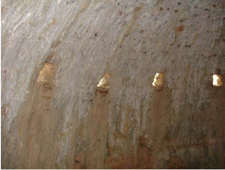
Fotoğraf 37. Muğla, Yatağan İlçesi Kavak Köyü Sarnıcı, Kubbe Eteğindeki Pencereler
