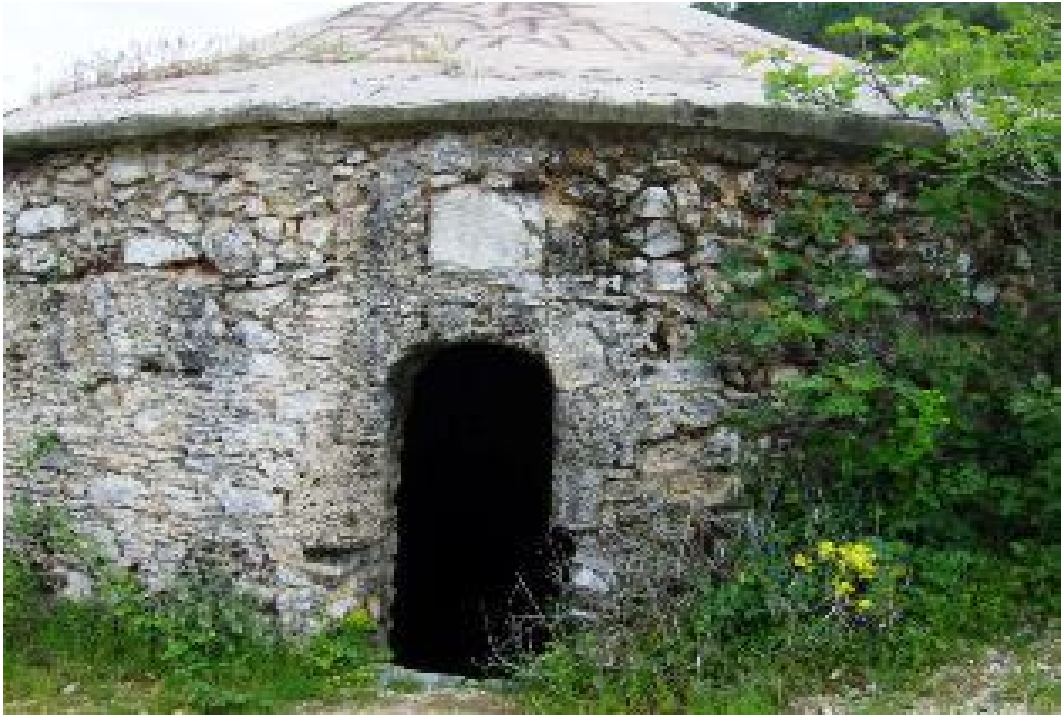
Fotoğraf 3. Muğla, Aydın Yolu Yerkesik Kavşağındaki Sarnıç, Kapı
