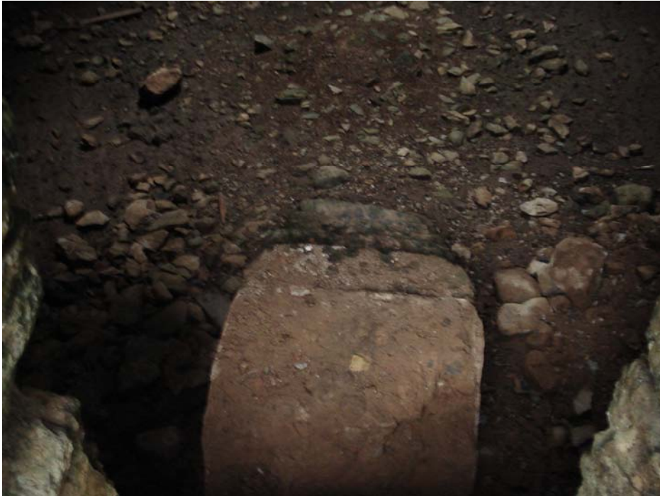
Fotoğraf 137. Muğla, Datça İlçesi, Hızırşah Köyü Sarnıcı Merdivenleri
