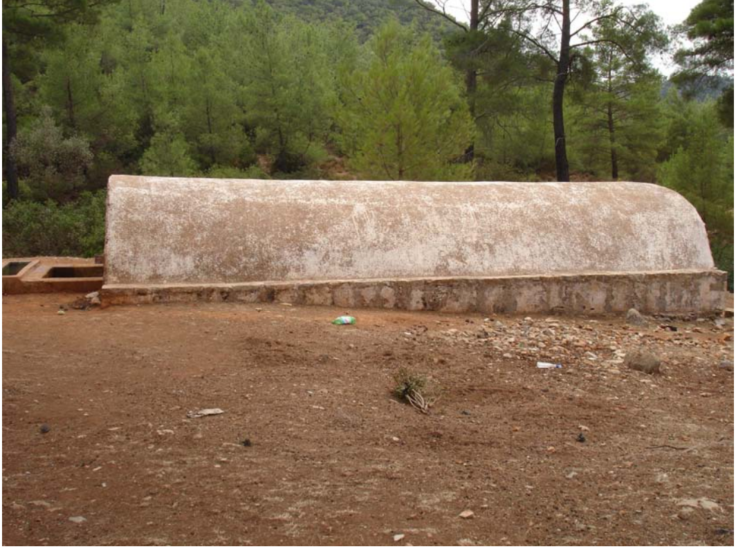
Fotoğraf 62. Muğla, Bodrum İlçesi, Yalı Köyü Sarnıcı 4 Genel Görünüş
