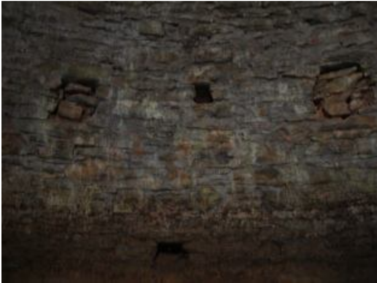
Fotoğraf 7. Muğla, Akkaya Yolundaki Sarnıç, Kubbe Eteğindeki Pencereilerin İçten Görünüşü
