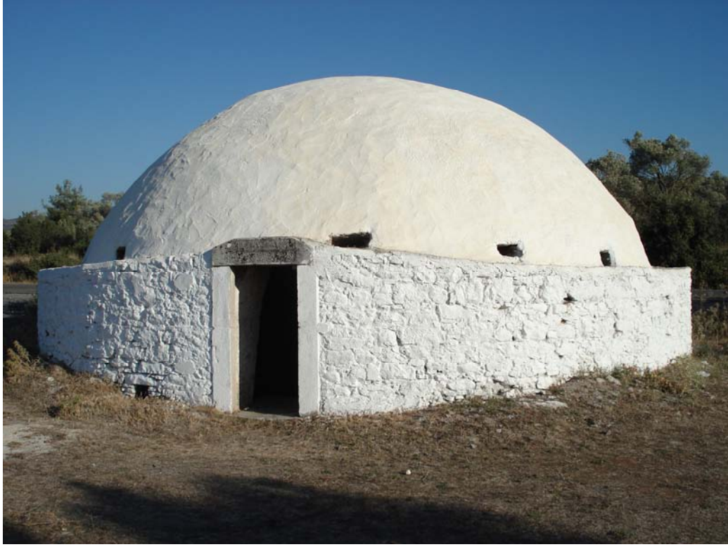
Fotoğraf 77. Muğla, Bodrum İlçesi, Mumcular Köyü Sarnıcı Genel Görünüş
