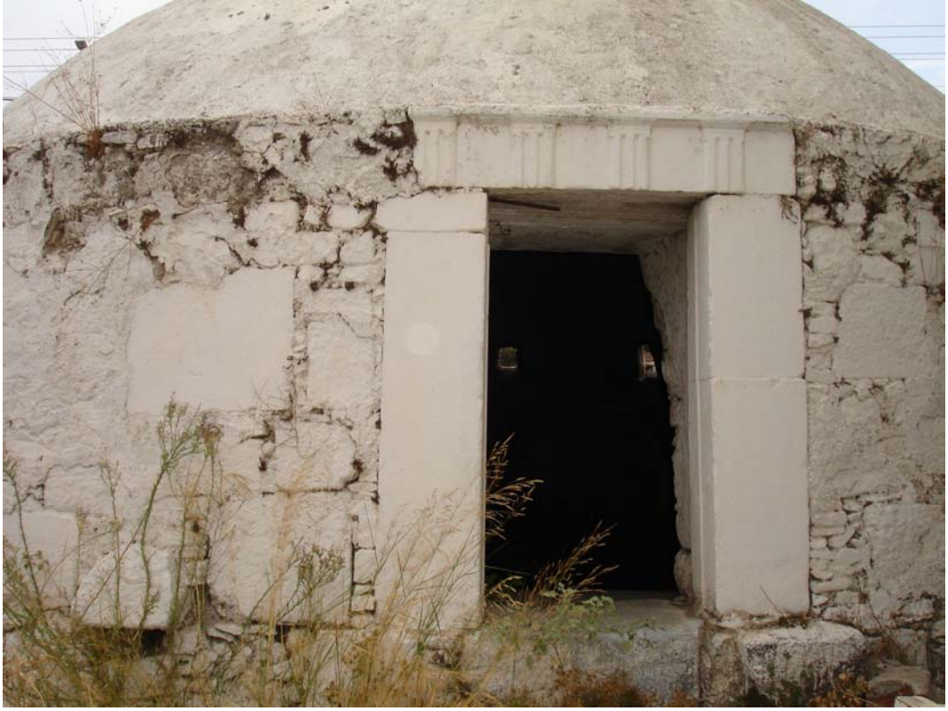
Fotoğraf 44. Muğla, Bodrum İlçesinde Bulunan Sarnıç 2 Giriş Cephesi
