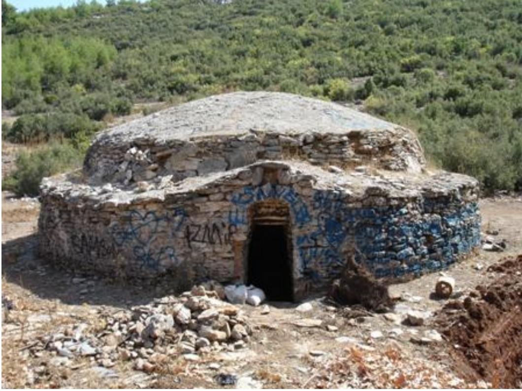
Fotoğraf 6. Muğla, Akkaya Yolundaki Sarnıç, Genel Görünüş
