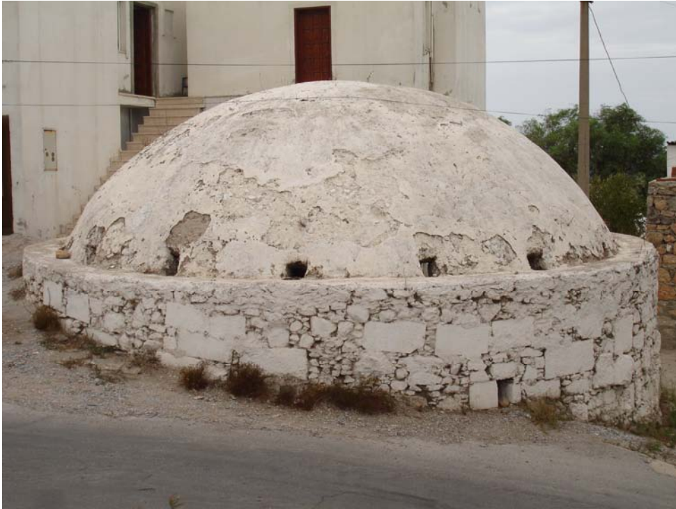
Fotoğraf 45. Muğla, Bodrum İlçesinde Bulunan Sarnıç 2 Kubbe Eteğine açılan Pencereler
