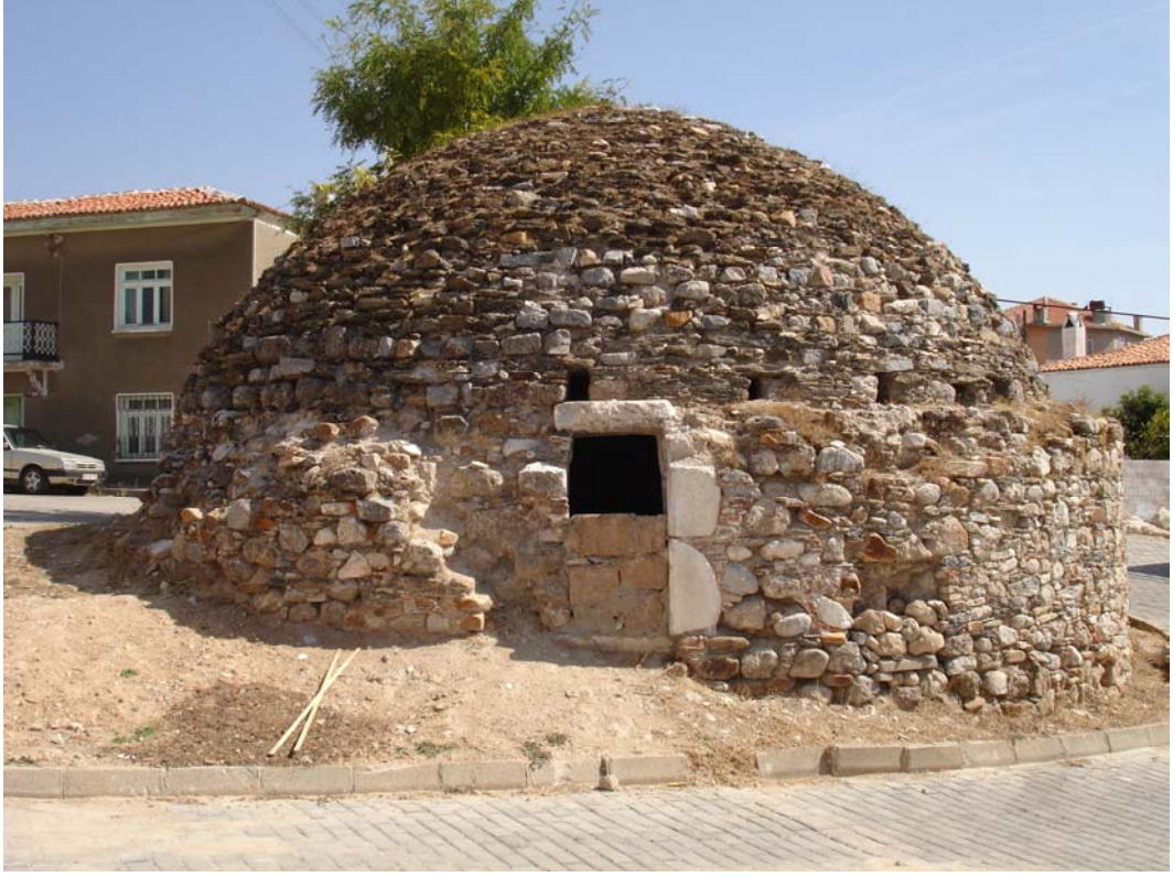
Fotoğraf 28. Muğla, Yatağan İlçesinde Bulunan Sarnıç, Genel Görünüş
