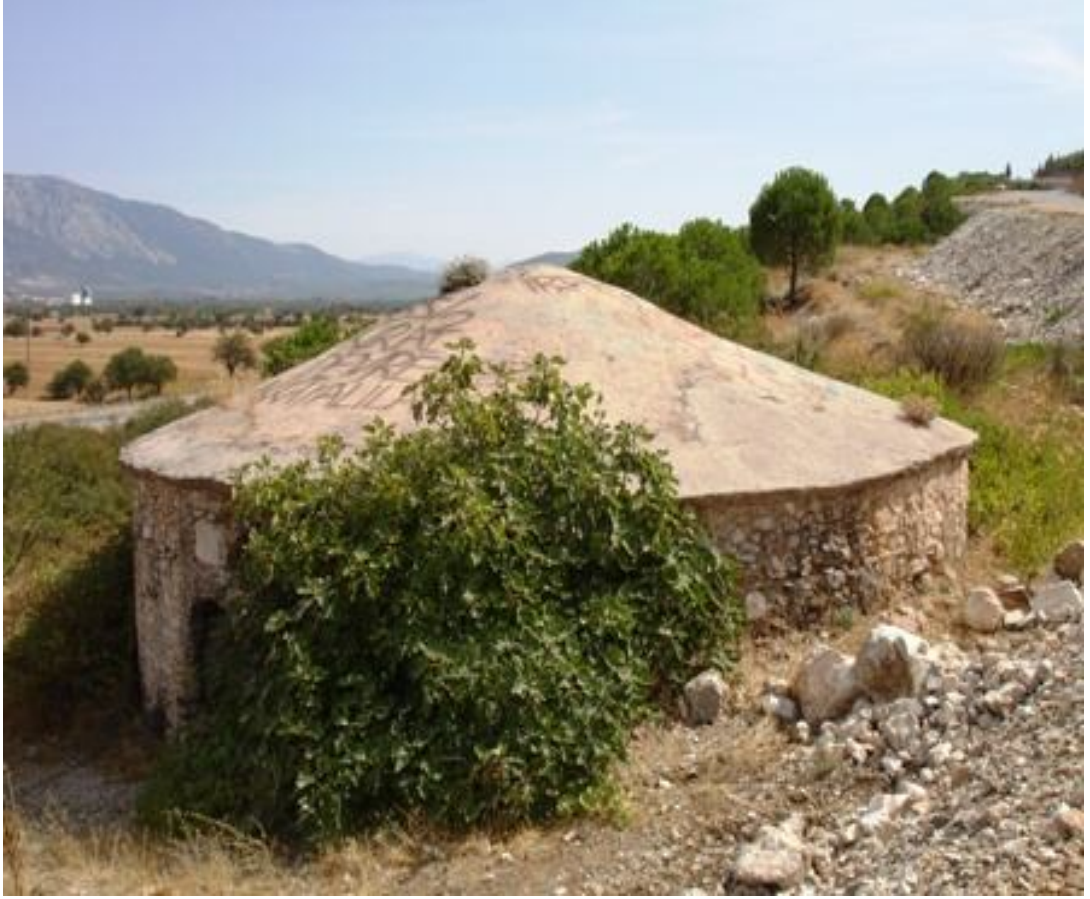
Fotoğraf 2. Muğla, Aydın Yolu Yerkesik Kavşağındaki Sarnıç, Genel Görünüş
