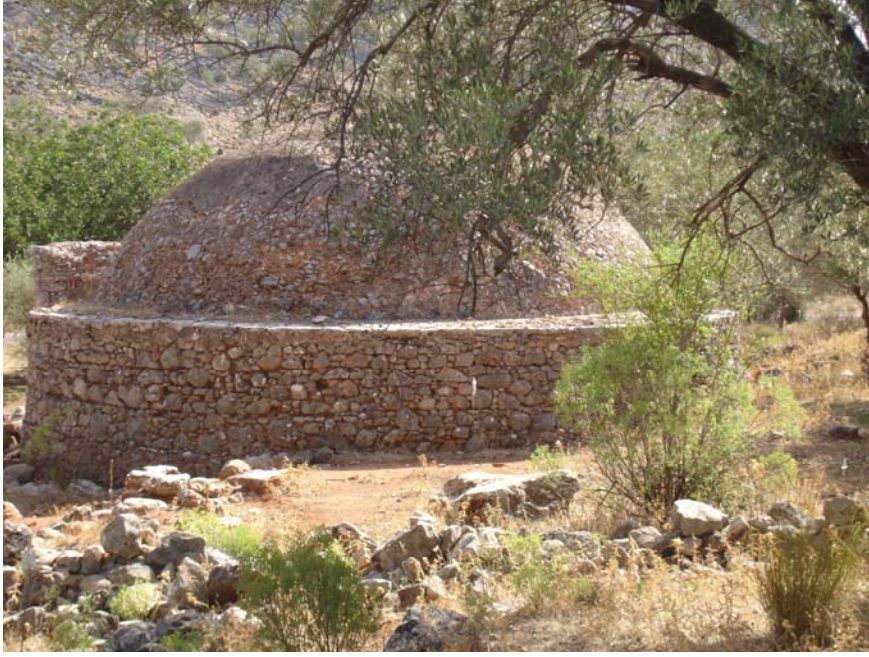
Fotoğraf 101. Muğla, Fethiye İlçesi, İzzettin Köyü Sarnıcı 2 Kubbe
