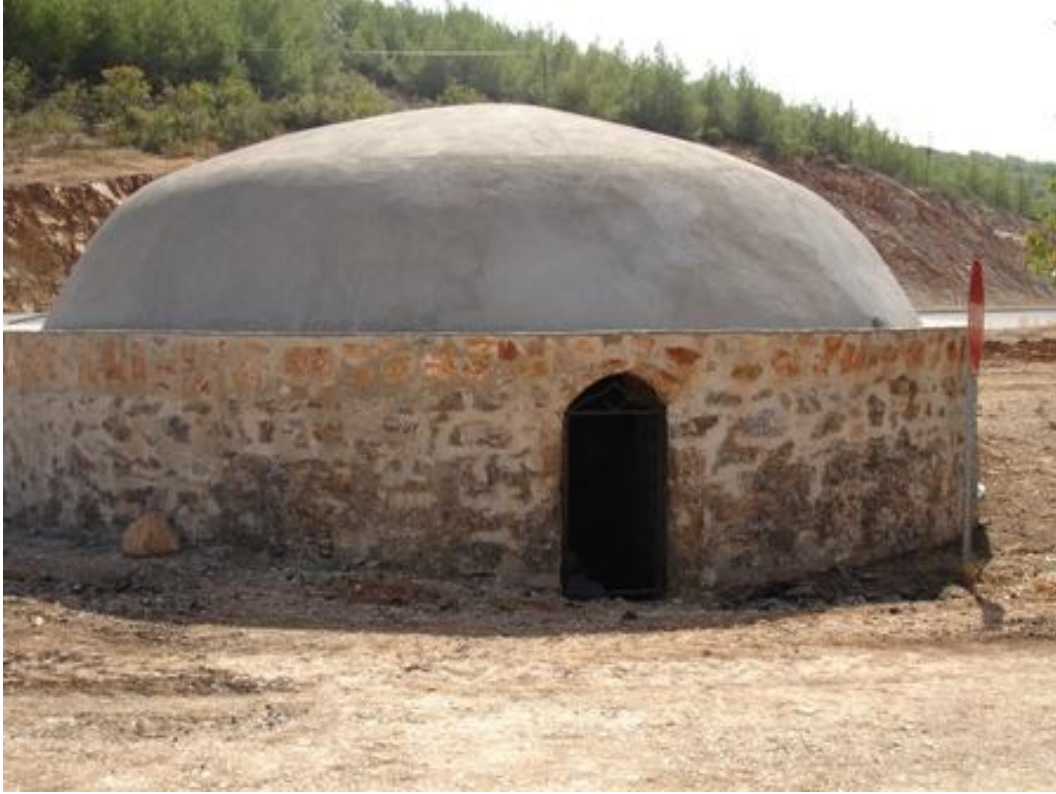
Fotoğraf 79. Muğla, Ula İlçesi, Kızılağaç Köyü Sarnıcı 1 Genel Görünüş
