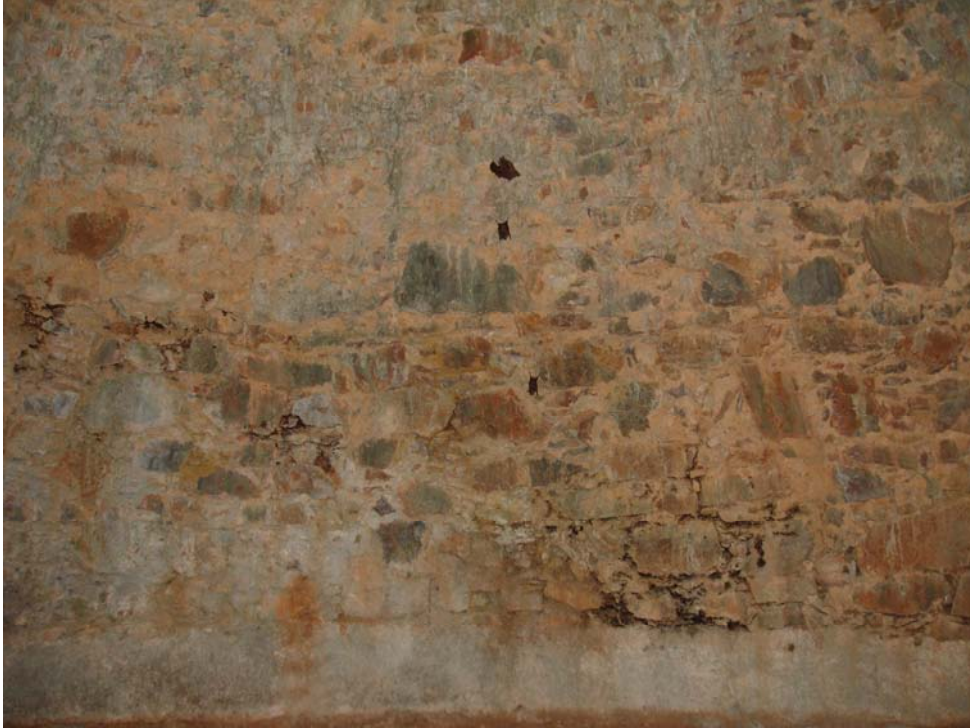
Fotoğraf 51. Muğla, Bodrum İlçesi, Dereköyü Sarnıcı 2 İçten Görünüş
