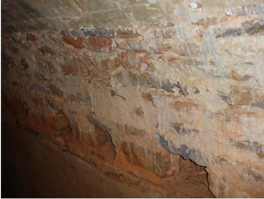
Fotoğraf 61. Muğla, Bodrum İlçesi, Yalı Köyü Sarnıcı 3 Su Gözleri
