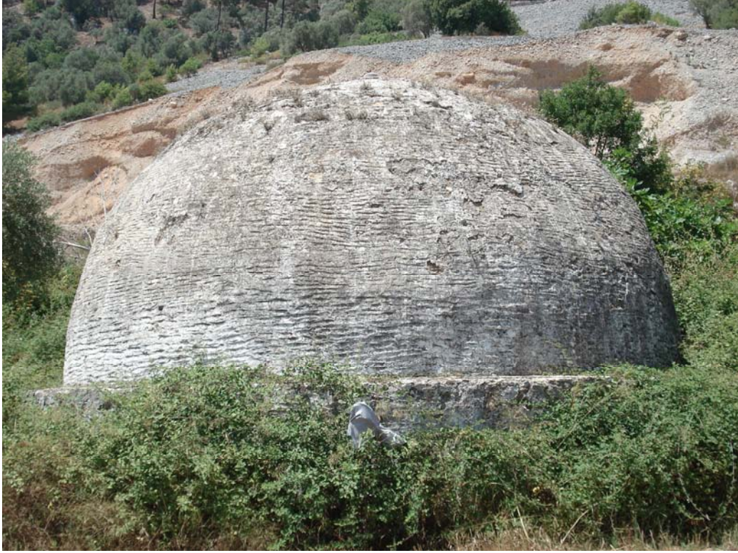
Fotoğraf 91. Muğla, Ula İlçesi, Gökova Köyü Sarmıcı Genel Görünüş
