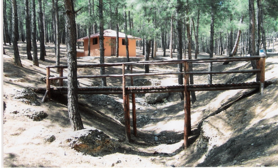
Şekil 4.5. Ahır Dağı Kent Ormanındaki Ahşap Köprü.
