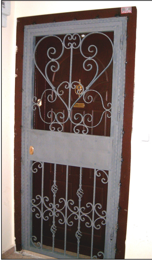
Resim 7.3. Konut giriş kapısında güvenlik nedeniyle yapılmış olan çelik kapı ile beraber koruma amaçlı demir korkuluk örneği
