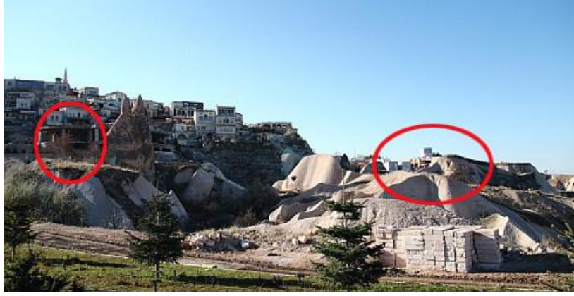
Görsel 3. 21. 2013 yılında inşaatı durdurulan oteller ( http-91 )
