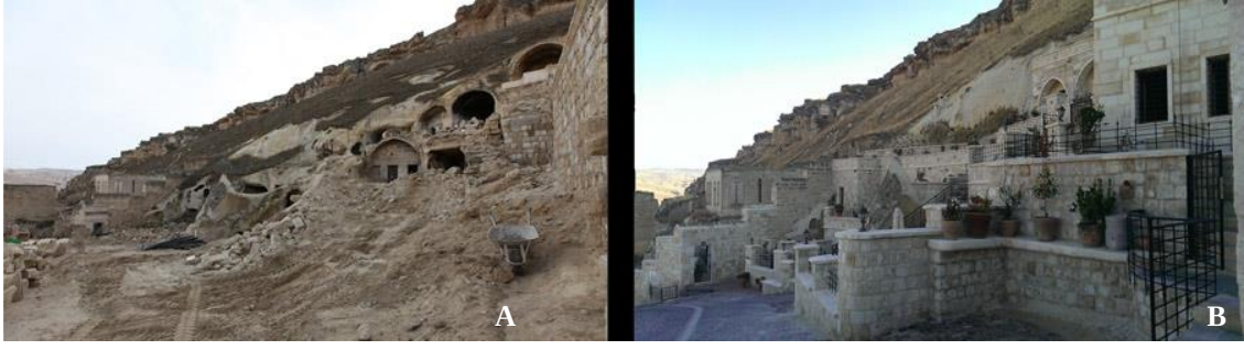
Görsel 3. 9. Kayakapı Kültürel ve Doğal Çevre Koruma ve Canlandırma Projesi (A.Öncesi, B.Sonrası (http-85))
