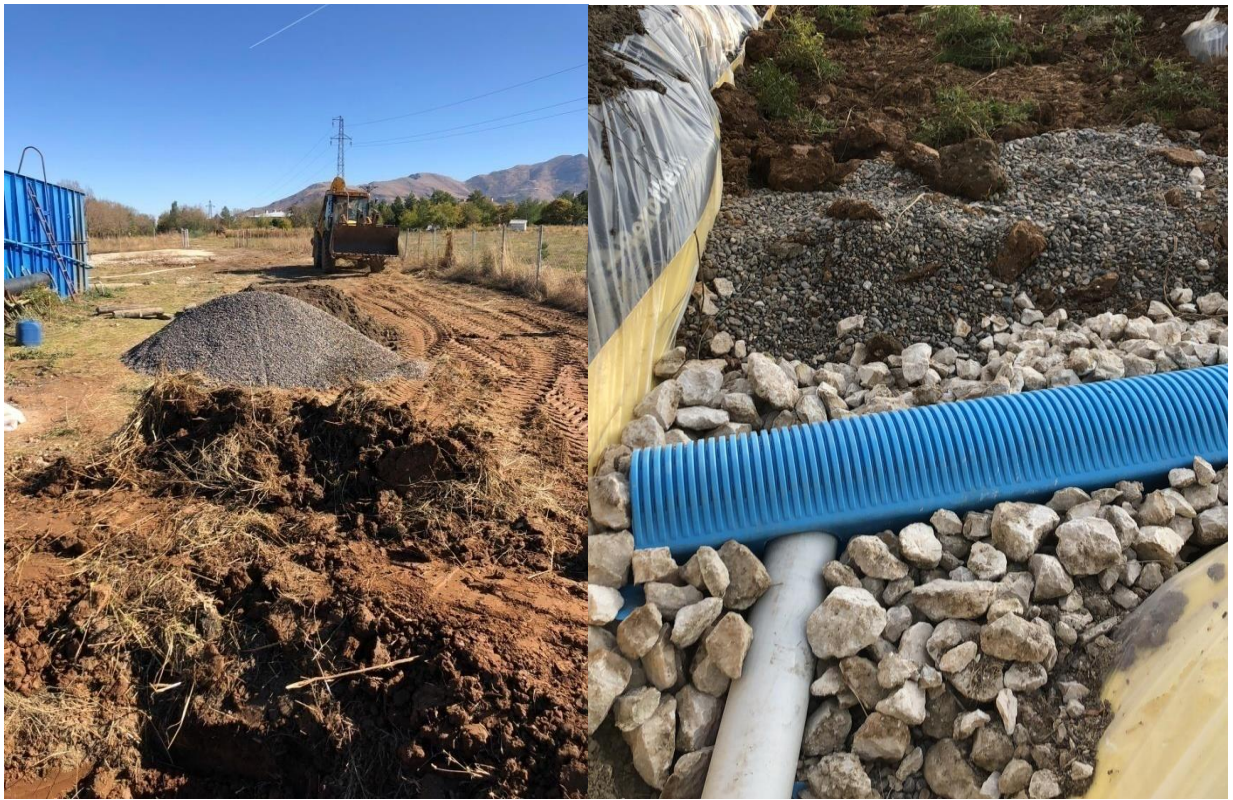
Şekil 2.2. Muş Şeker Fabrikası Yapay Sulakalan Sisteminin Yatak Malzemesine ait bir görünüm
