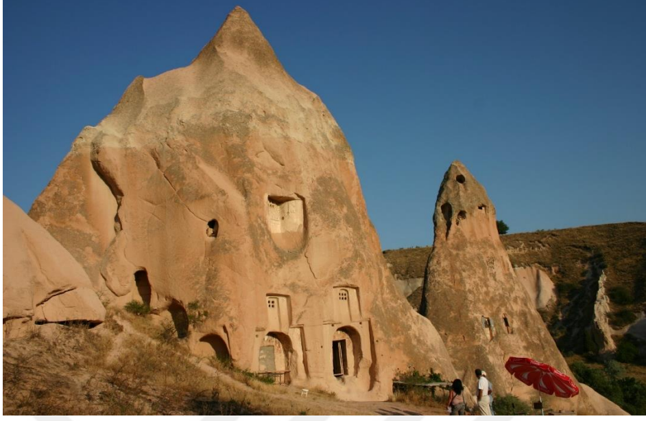
Fotoğraf 5. 67. Çavuşin Güllüdere Ayvalı Kilise- Vaftizci Yahya Kilisesi; Genel Görünüş ve Giriş Cephesi (Murat Gülyaz'dan)
