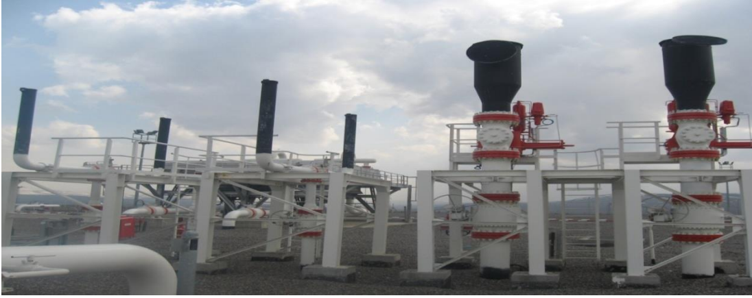
Şekil 3.14. Tahliye (Relief ve Blowdown vanaları) sistemi
