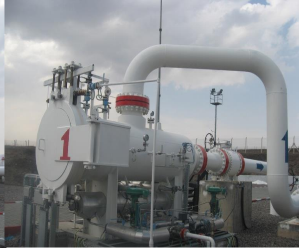
Şekil 3.4b. Ayırıcı-Separator filtre
