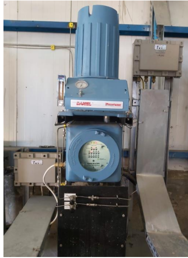
Şekil 3.21. Gaz Kromatografi
