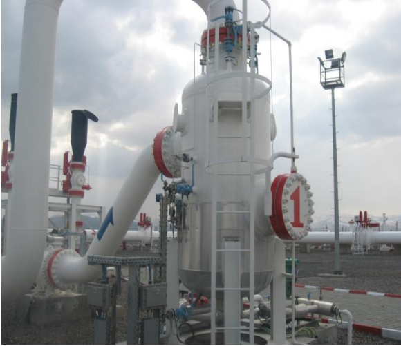
Şekil 3.4a. Siklon filtre
