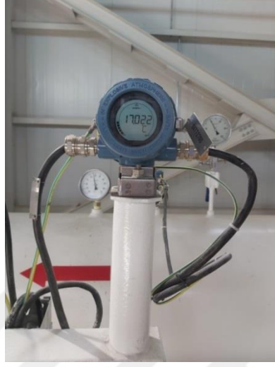
Şekil 3.20. Sıcaklık Transmitteri
