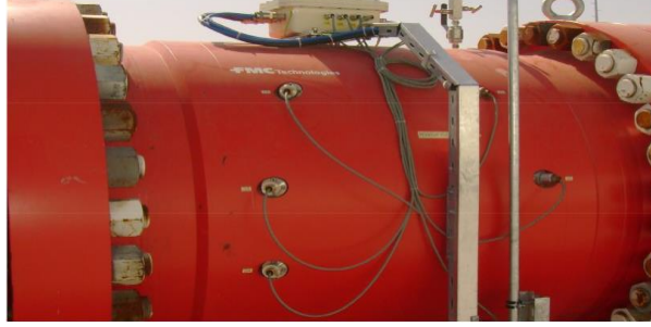
Şekil 3.18. Ultrasonikmetre
