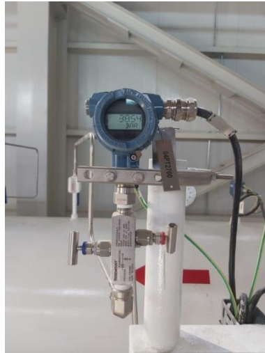
Şekil 3.19. Basınç Transmitteri
