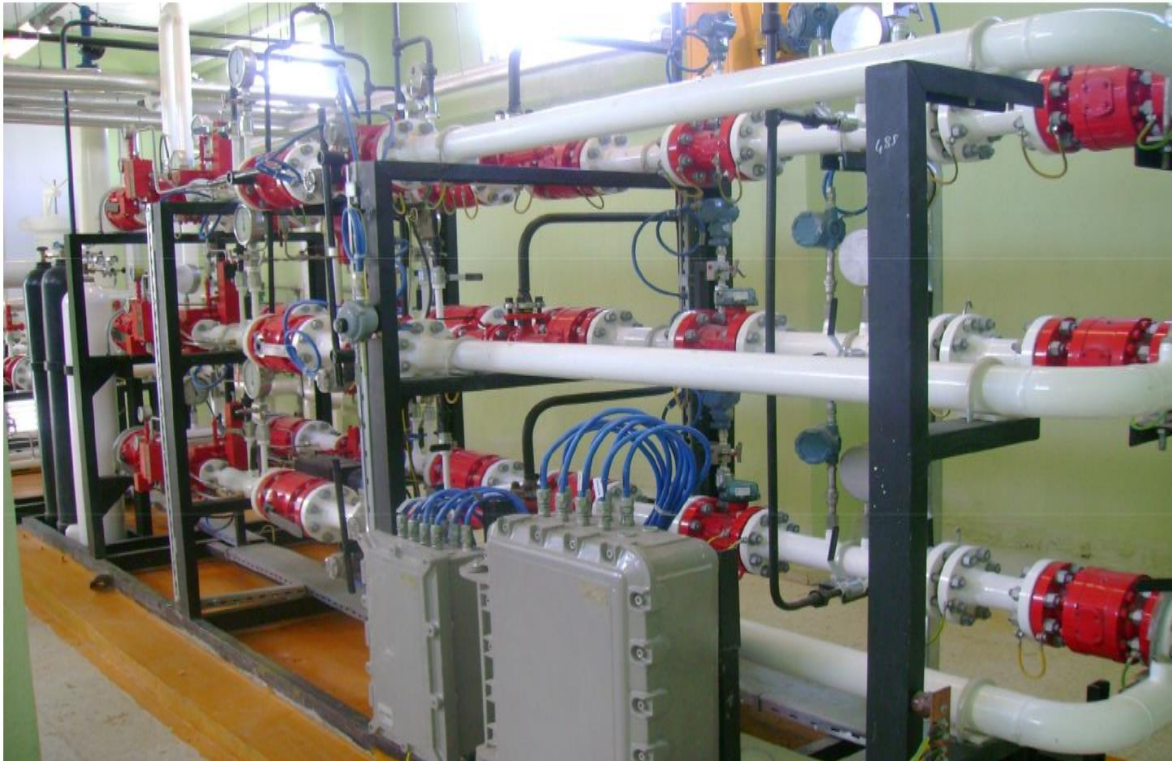
Şekil 3.22. Türbin yakıt gazı sistemi
