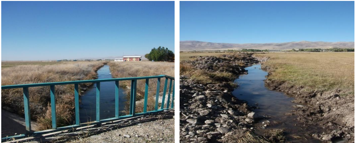
Şekil 4.3. Üretici koşullarında yapılmış drenaj kanalları
