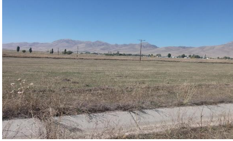
Şekil 4.2. Düşük kotlu kanal
