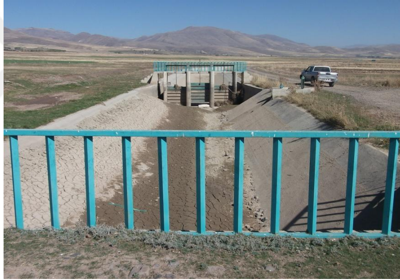
Şekil 4.1. Rusubat dolmuş kanal
