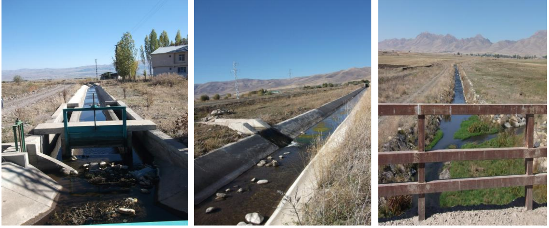
Şekil 4.5. Havuz sistemi, tahliye yapıları, eski tahliye yapısı
