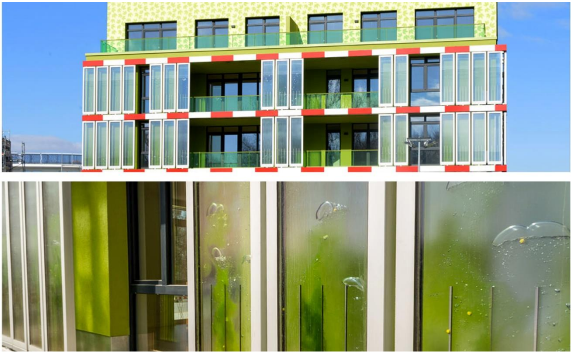
Şekil 3.4. B.I.Q. House yapısının güney cephesi, cephe sistemi içerisinde mikroalgler (URL-10)
