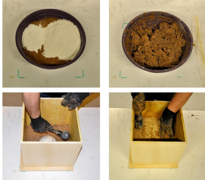
Şekil 5.7. Sıkıştırılmış toprak bloğun yapım süreci
