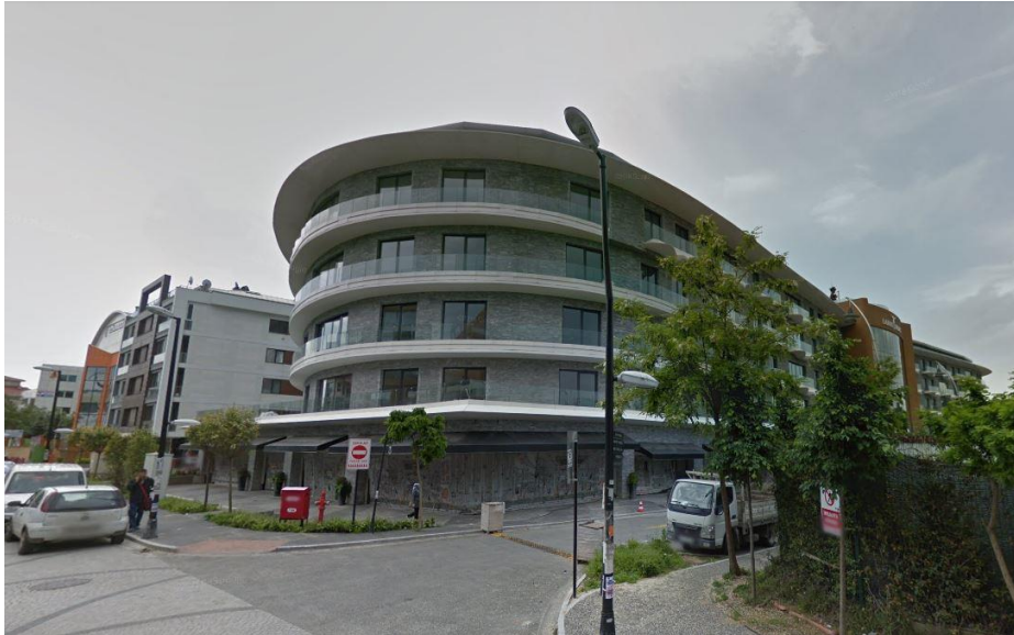
Şekil 5.8 Çalışma Alanından Seçilen Örnek Alandaki Binanın Güncel Hali
