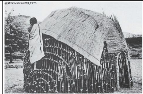
Şekil 4.9.b. Zulu Kulübesi Yapısal Detay Diyagramı (Guidoni, 1975, s.45)
