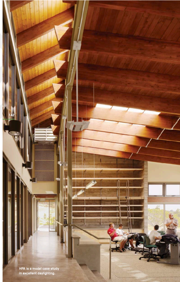
Şekil 4.10. Çatı açıklıkları ve doğal aydınlatma (Liljequist, 2016).
