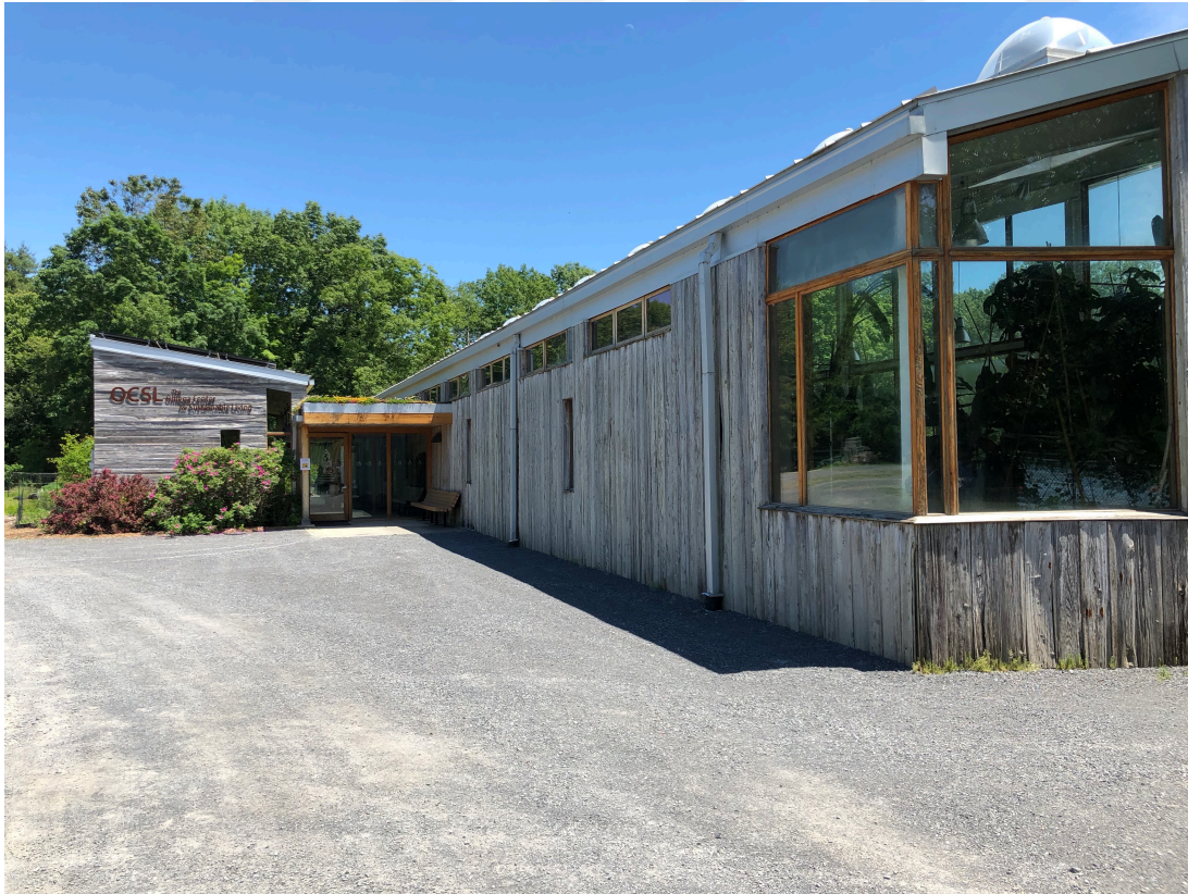
Şekil 4.11. Omega Center For Sustainable Living Binası (Serdar Vardar, Rhinebeck, NY, Mayıs 2019)
