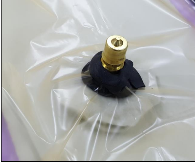
Resim 6.14. T Bağlantı borusunun vakum naylonuna yapıştırılması
