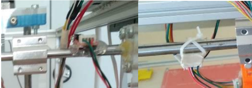
Şekil 3. 60. Limit switchler iii.
