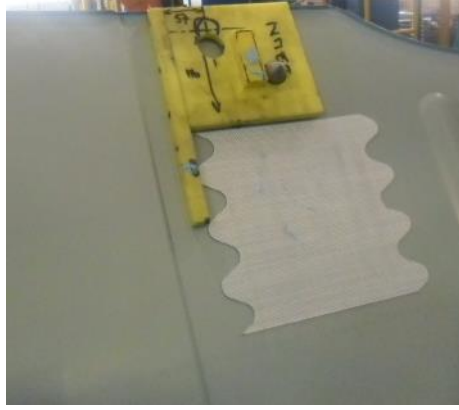
Şekil 2.23: Pad mastik işlemi
