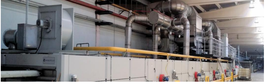
Şekil 1.1 Bir Germe Makinesi Üzerine Monte Edilmiş Isı Geri Kazanım Ünitesi
