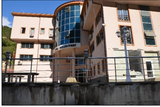
Fotoğraf 2.11. Dereli Belediye Hizmet Binasından Bir Görünüm.
