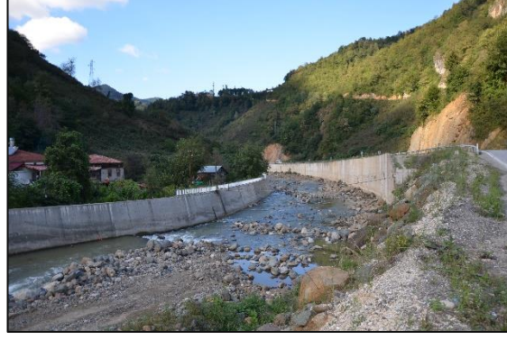
Fotoğraf 1.3. Aksu Deresi Taşkın Koruma Duvarından Görünüm.
