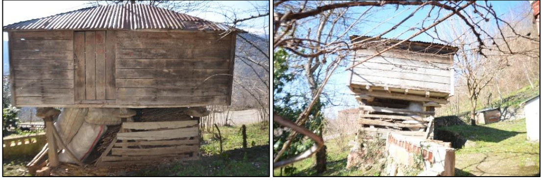
Fotoğraf 2.17. Dereli İlçesi Sütölçe Mahallesi'nde Yer Alan Serenderden Görünümler.
