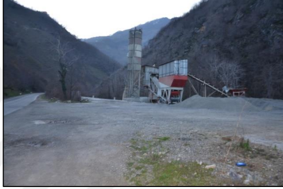
Fotoğraf 3.14. Dereli Hazır Beton İşletmesinden Bir Görünüm.
