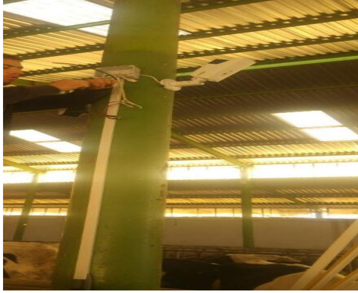
Şekil 2.5.: Çalışmaya ait kameraların montajı yapılırken.
