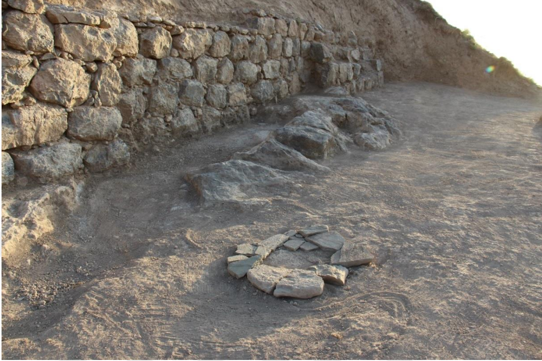
Resim 4: Ayaniş Kalesi Doęu Sur Duvarlarında Görülen Kiklobik Sur örneęi (Ayaniş Kalesi Kazı Arşivi, 2018)
