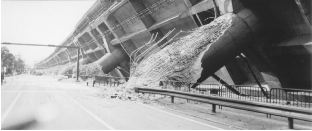
Şekil 2.3. 1995 Hyogo-Ken Nanbu depreminde yıkılan Higashi-Nada viyadüğü [5].
