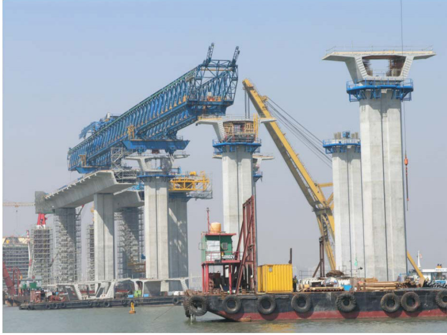
Şekil 4.5. Köprü ayaklarına oturan bir tür kren ile ardgermeli betonarme köprü inşaatı.
