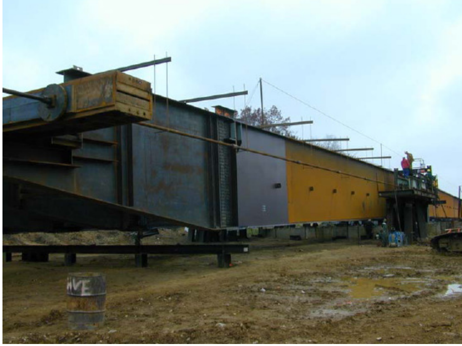
Şekil 5.6. Sürme metodunda kullanılan kuyruk yapısı ve yük aktarma halatları.
