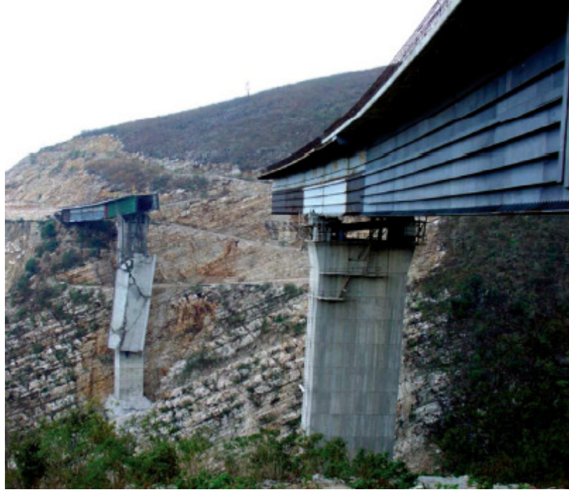
Şekil 5.21. Sürme esnasında göçmüş San Cristobal kompozit enkesitli çelik köprüsü.
