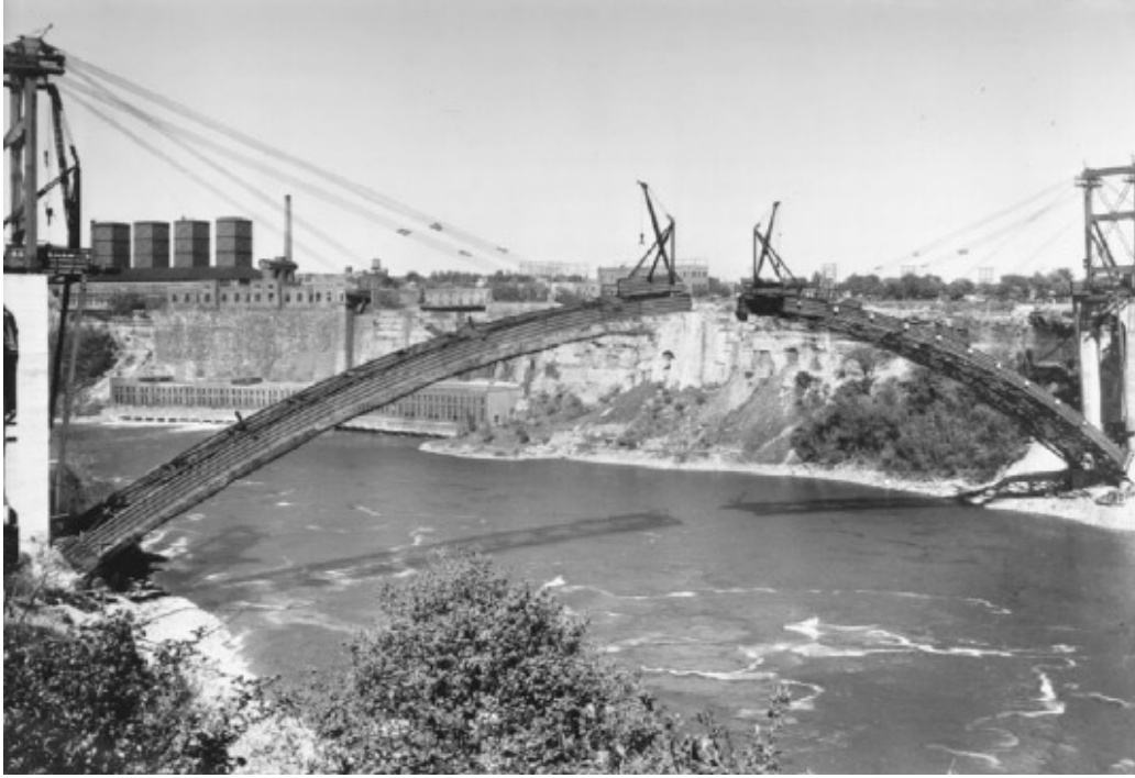
Şekil 4.3. Kemer köprüünün askı metodu ile inşası.
