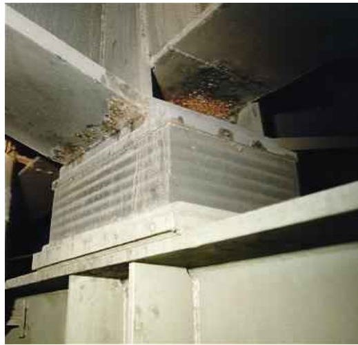
Şekil 3.28. Elastomer mesnet.
