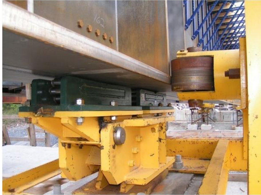
Şekil 5.8. Sürme metodunda kullanılan çok sayıda küçük silindirden oluşan mesnet.
