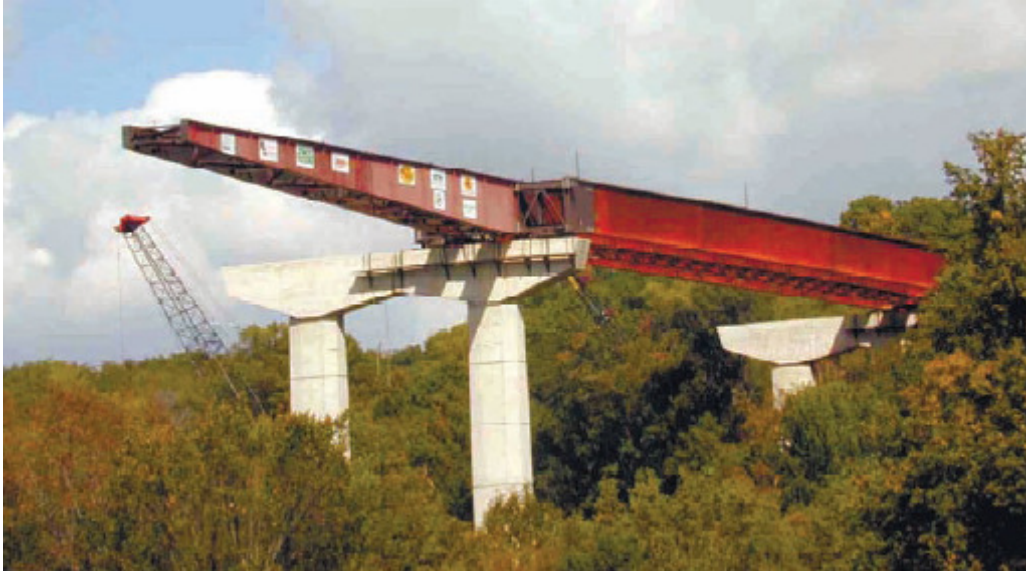
Şekil 5.1. Iowa nehri üzerinde sürme metoduyla inşa edilen köprü.
