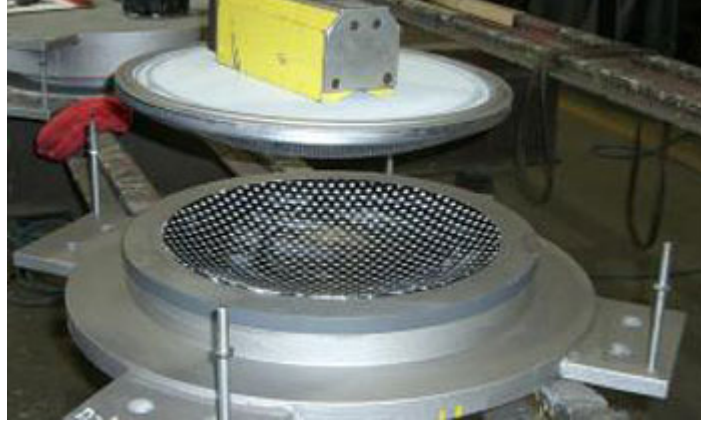
Şekil 3.29. Küresel kavisli mesnet.
