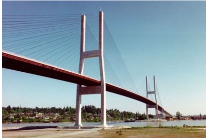
Şekil 3.19. Eğik askılı köprü örneği.
