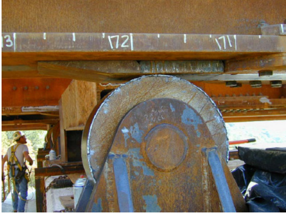
Şekil 5.7. Sürme metodunda kullanılan tek silindirli mesnet.
