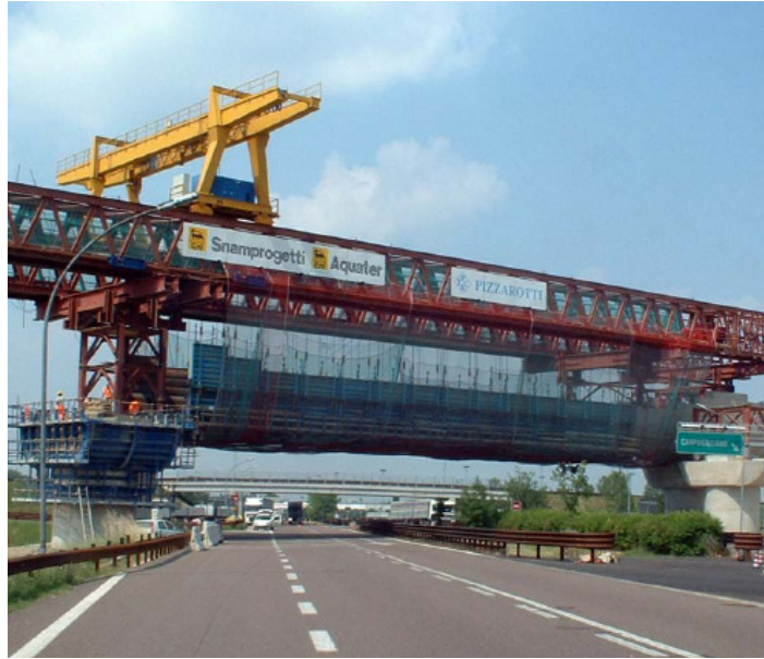
Şekil 4.4. Gezer vinç ve hareketli kalıp sistemi ile köprü inşası.
