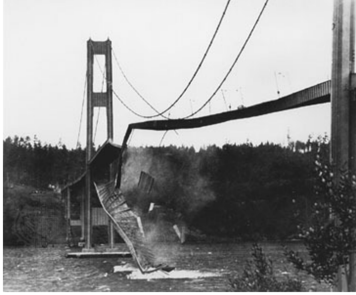
Şekil 2.2. Rüzgârın sebep olduğu rezonans sonucu yıkılan Tacoma asma köprüsü.
