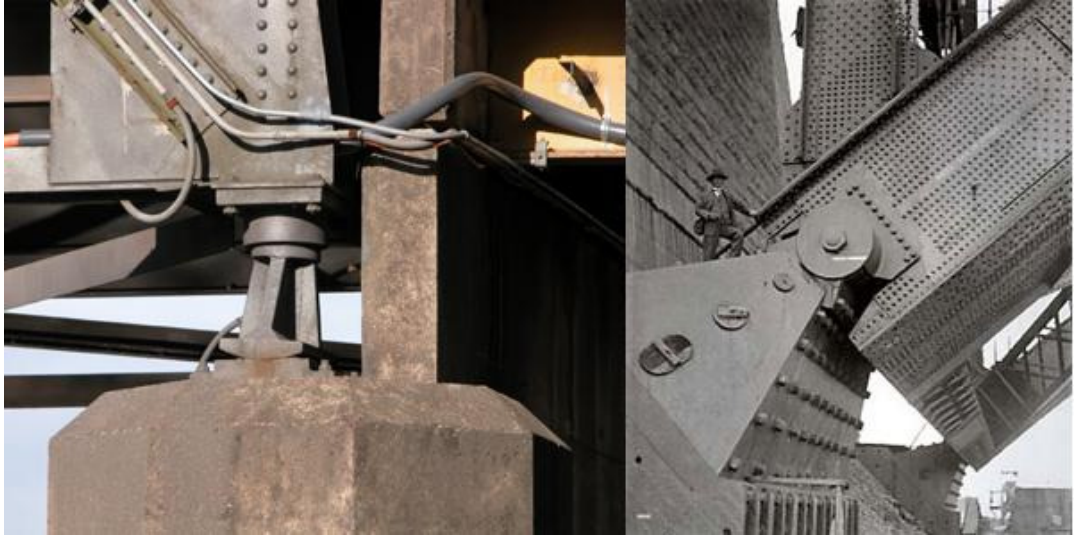
Şekil 3.26. Pandül (solda) ve pimli mesnetler.
