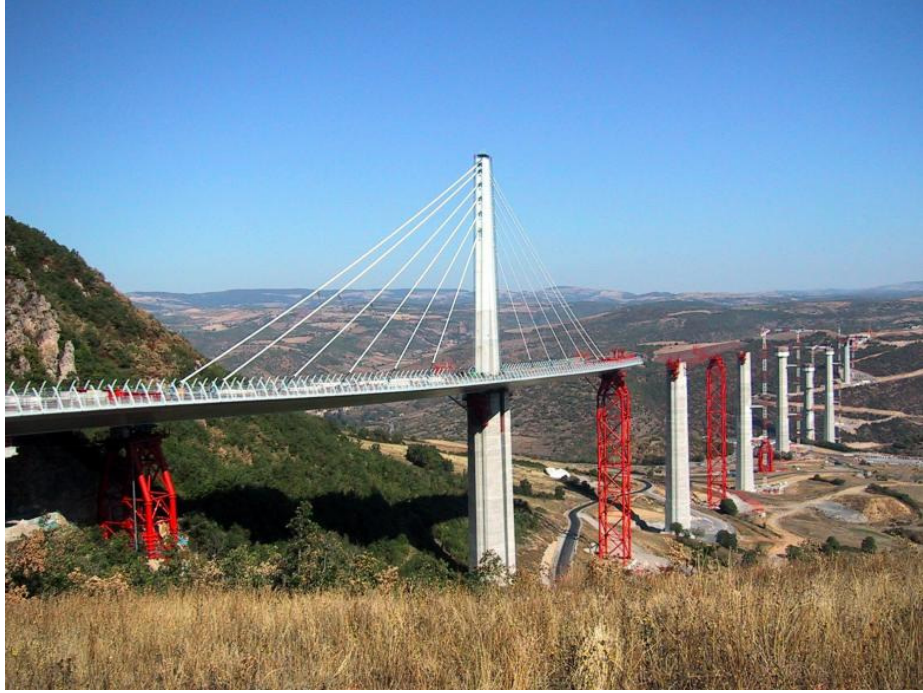
Şekil 5.4. Köprü inşaatında kullanılan geçici çelik ayaklar (kırmızı renkte).
