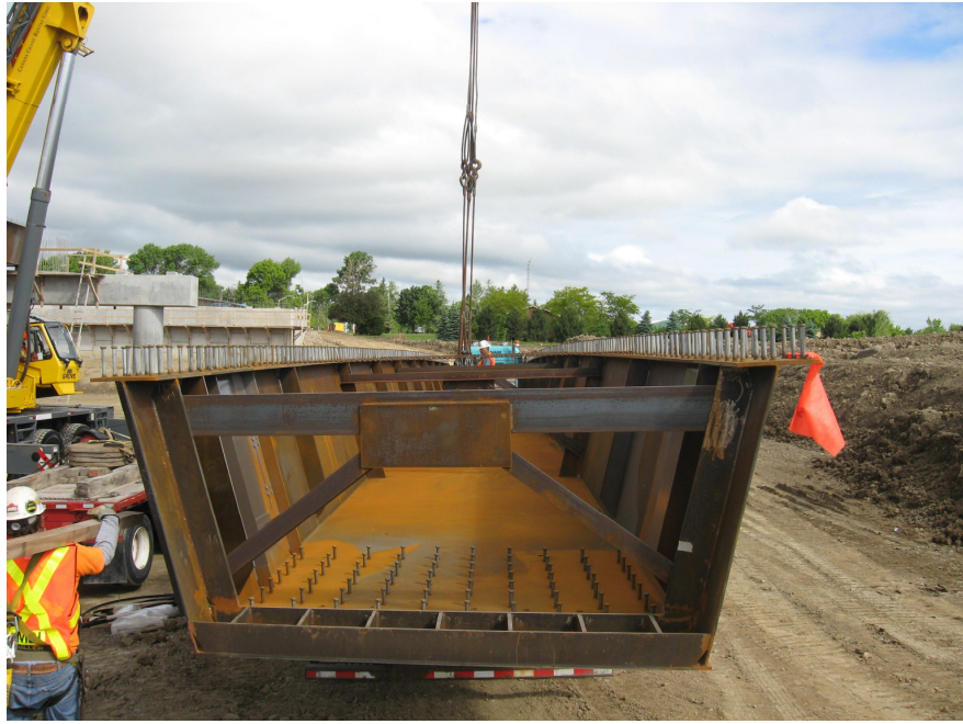
Şekil 3.4. Kutu enkesitli kompozit kirişli çelik köprü iskeleti.
