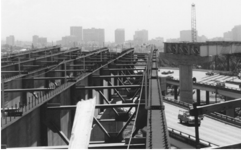
Şekil 3.2. Betonarme tabliyesi tamamlanmamış kompozit I köprü kirişli köprü iskeleti.
