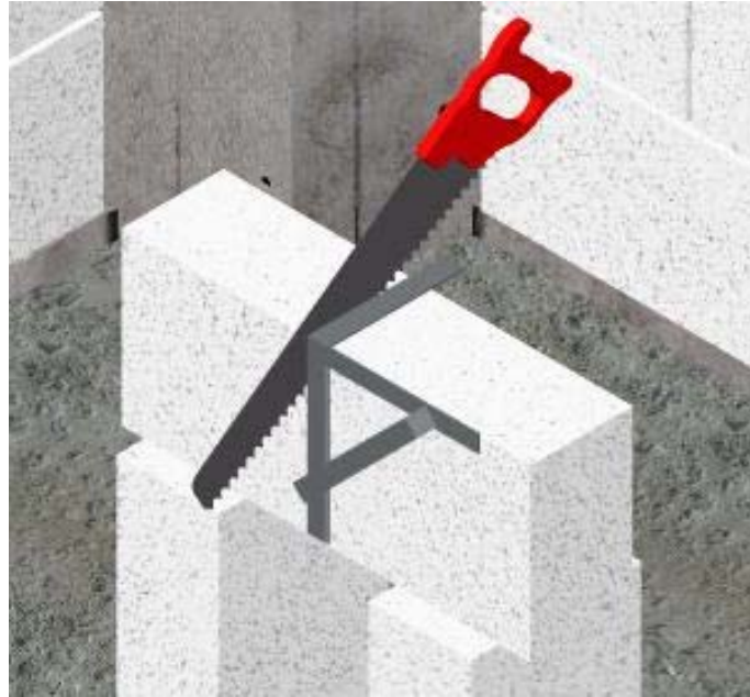
Şekil 2.3 Gazbeton izolasyon plakları kolay kesilir ve işlenebilir nitelikte bir ısı yalıtım kaplamasıdır (www.akg-gazbeton.com).
