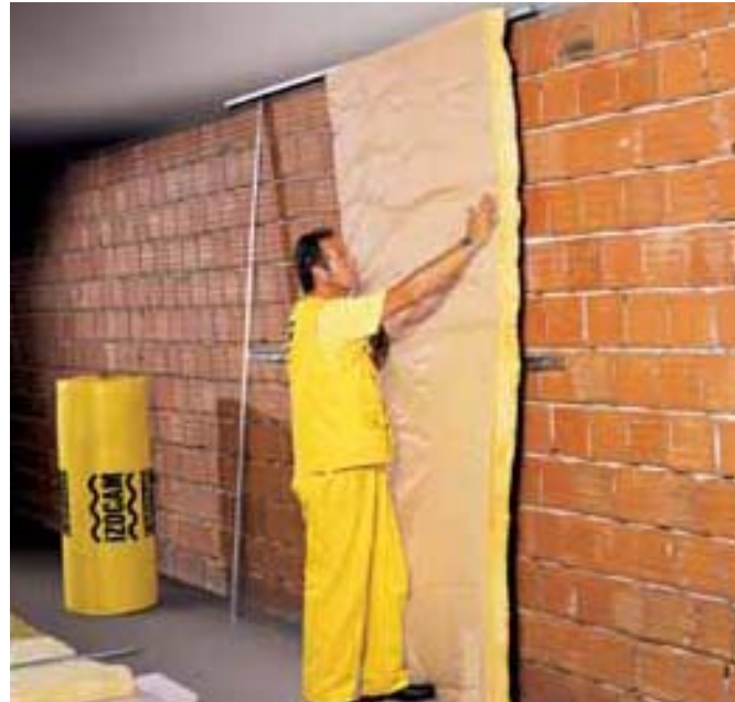
Şekil 3.7 Şilte yapıda olan cam yünü malzemenin dış duvarda iç yüzeyden yalıtım uygulaması (www.izocam.com).
