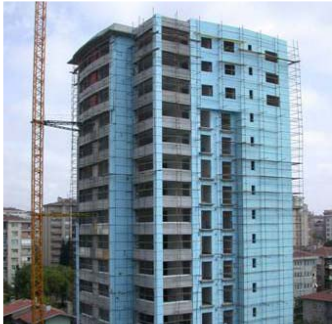
Şekil 3.2 Dış duvarlarda dıştan ısı yalıtımı uygulaması.
