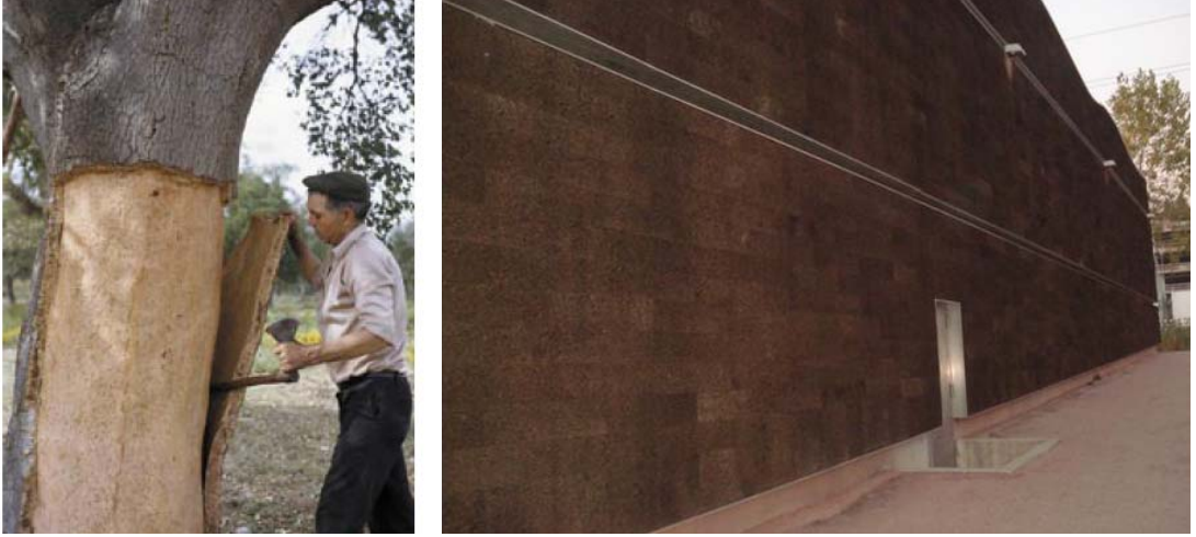
Şekil 2.8 Mantarın ağaçtan soyulması işlemi ve proseslerden geçen mantar plakaların dış cephede uygulanması (Portekiz Pavyonu, Expo 2000, Hanover).
