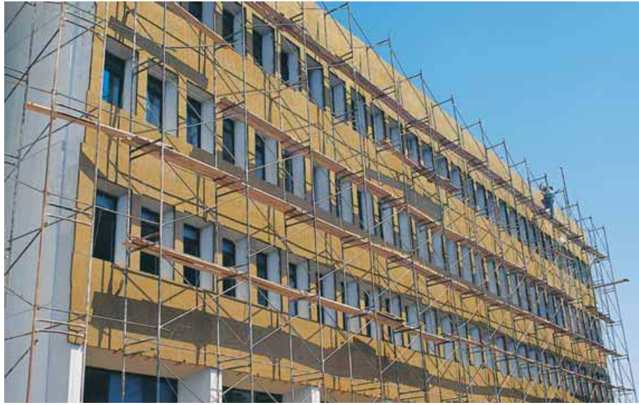
Şekil 2.12 Taş yünü ile mantolama uygulaması.
