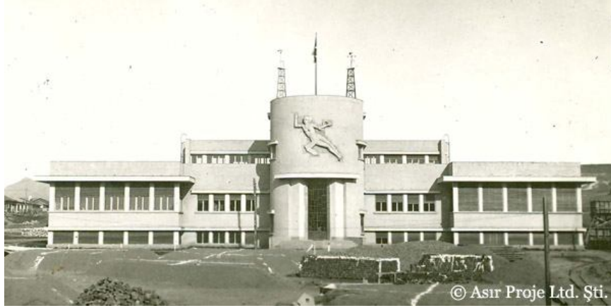
FOTOĞRAF NO 38: Ankara Hıfzısıhha Genel Müdürlüğü binası.
