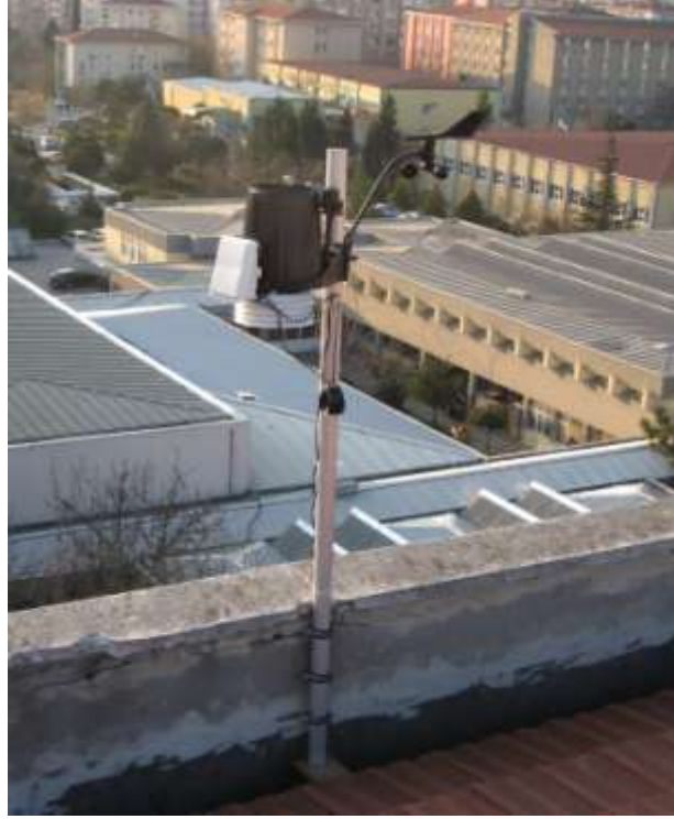
Şekil IV.8 Montajı Yapılmış Meteoroloji İstasyonu.
