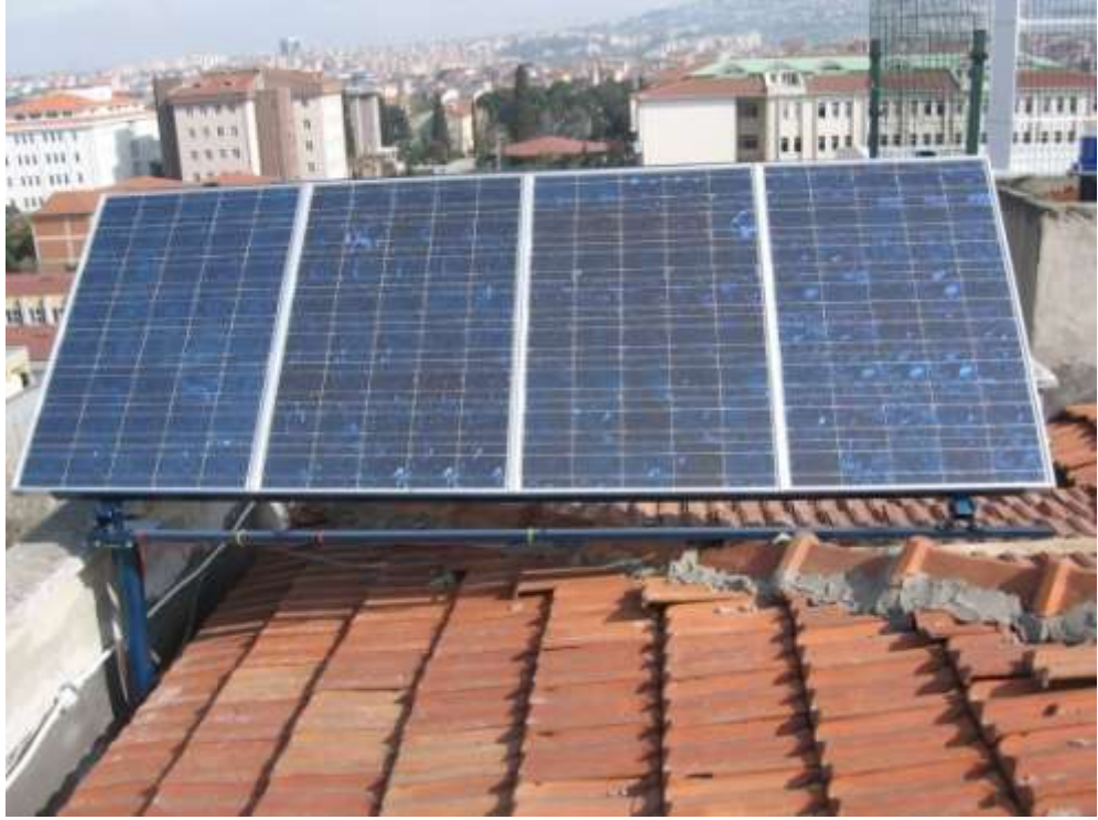
Şekil IV.4 Montajı Yapılmış Fotovoltaik Paneller.
