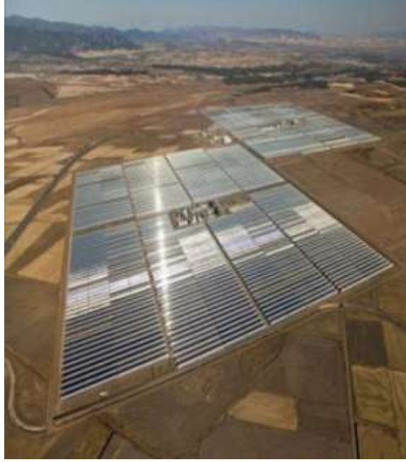
Şekil III.10 Güneş Termik Santral Uygulaması (İspanya)[60].
