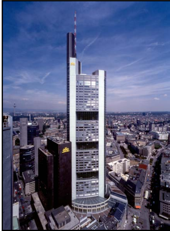
Resim 3. 6. Akıllı Bina Örneği Commerzbank Binası, Frankfurt ( http://www.diro-online.com/wordpress/wp-content/uploads/2009/04/imgdb_hochhaus_turm.jpg )
