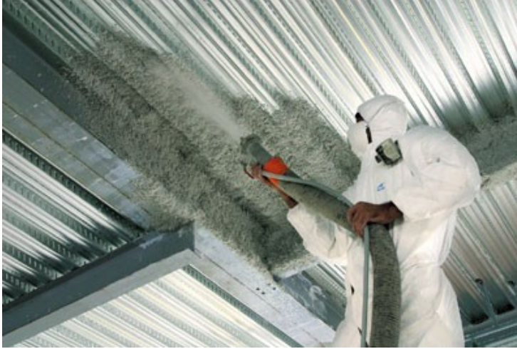
Şekil 4.15. Püskürtme sistemlerin çelik kirişe uygulanması[26]
