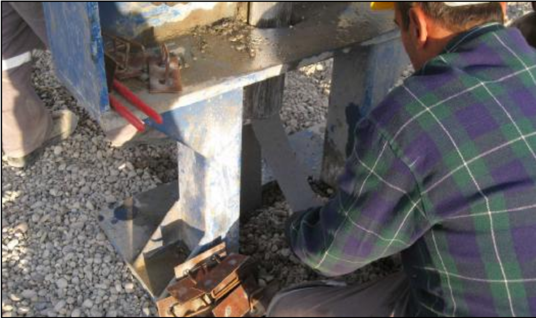
Şekil 3.10. Bant Drenlerin Çelik Millerle Zemine Çakılması.
