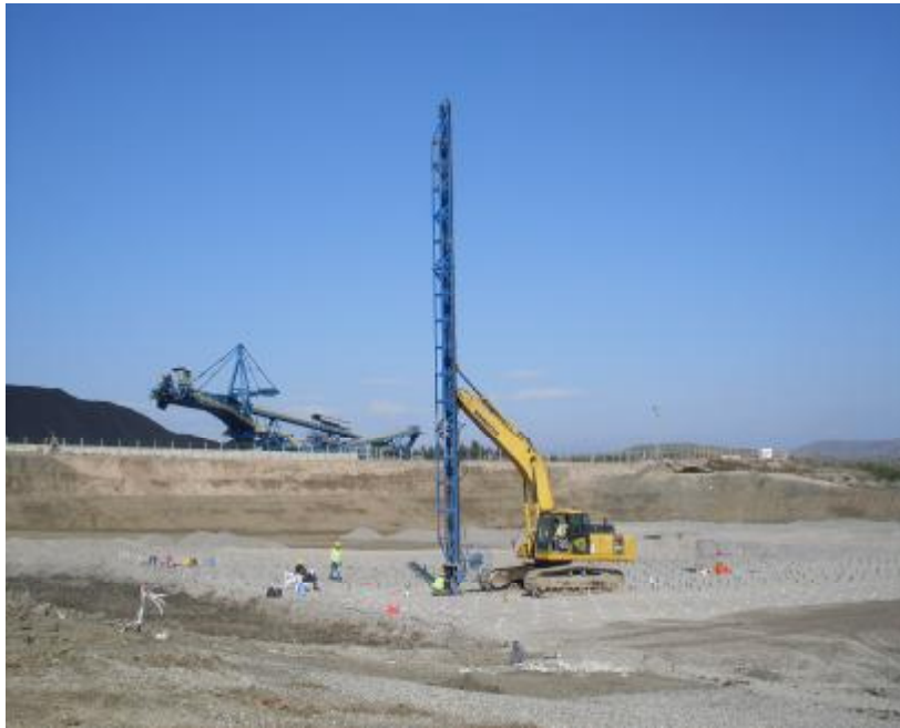
Şekil 3.3. Stitcher (dikici) Dren Makinesi.
