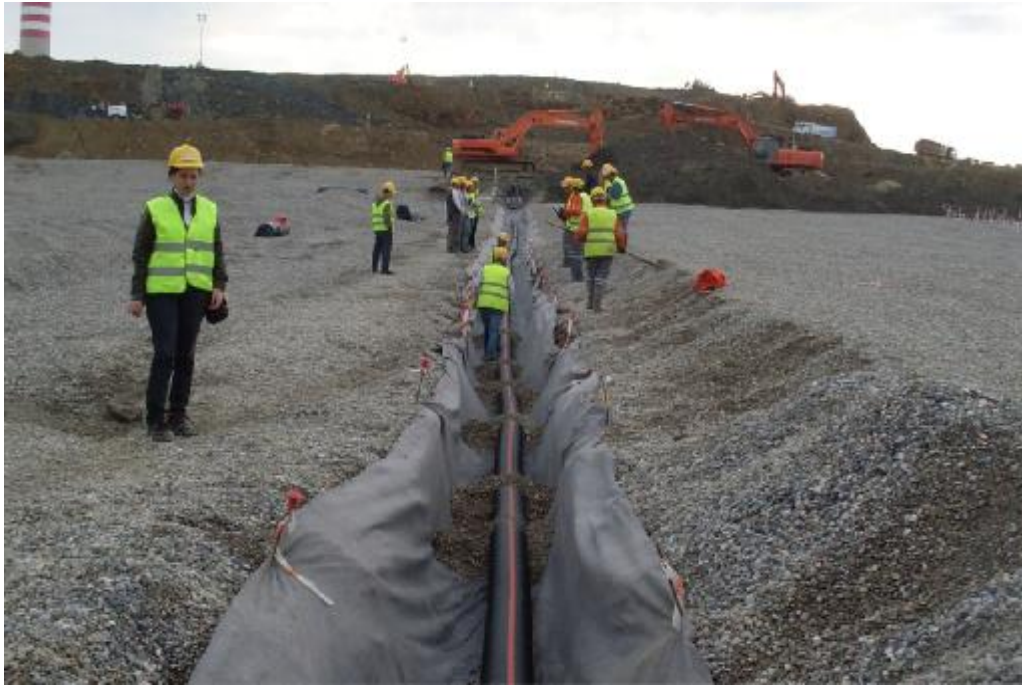
Şekil 3.8. Ana Drenaj Kanalının Jeotekstil ile Yerleştirilmesi (D – B doğru).
