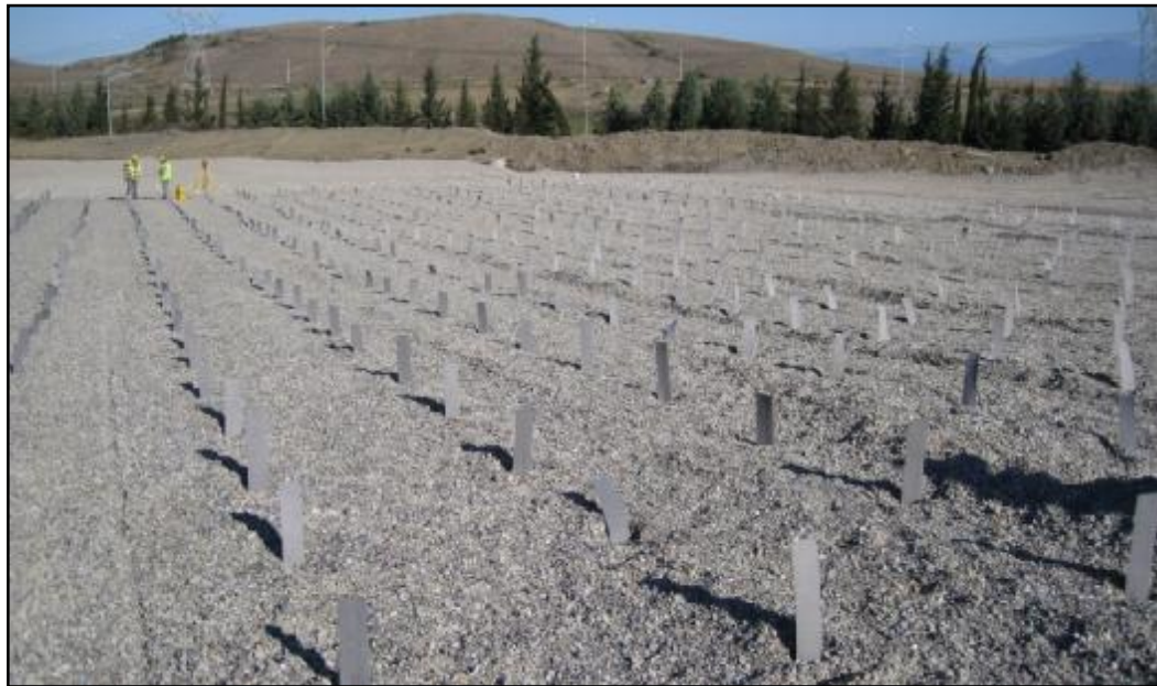
Şekil 3.12. Fitillerin 1.50 m Aralıkla Kare Dizayn Şeklinde Çakılmaları.
