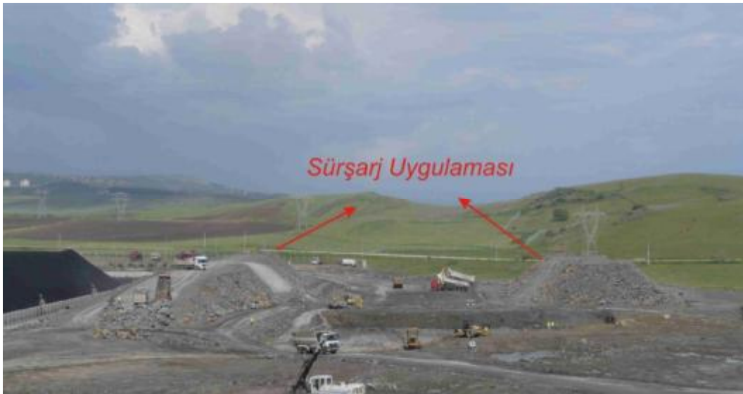
Şekil 3.17. Surşarj Uygulaması.
