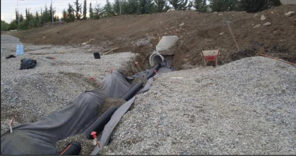
Şekil 3.7. Ana Drenaj Kanalının Jeotekstil ile Yerleştirilmesi (B – D doğru).
