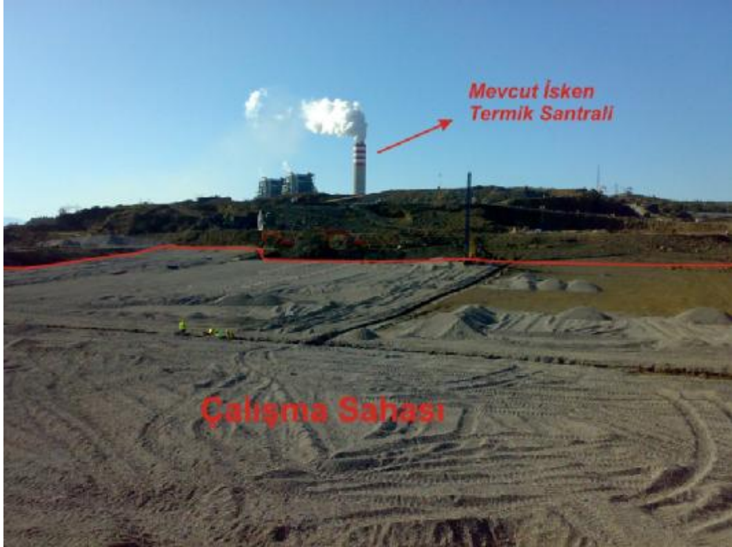
Şekil 1.3. Çalışma Sahasının Görünümü.
