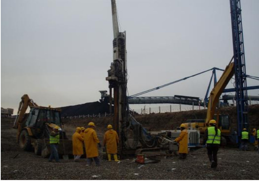
Şekil 3.15. Ön Delgi ve Ardından Fıtılleme İşlemi.
