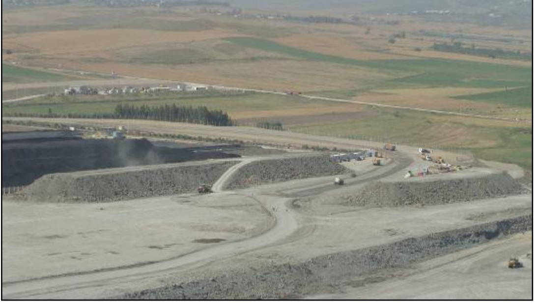
Őekil 4.10. A ve B Aksında Surőarj Uygulamasının Genel Görünümü.
