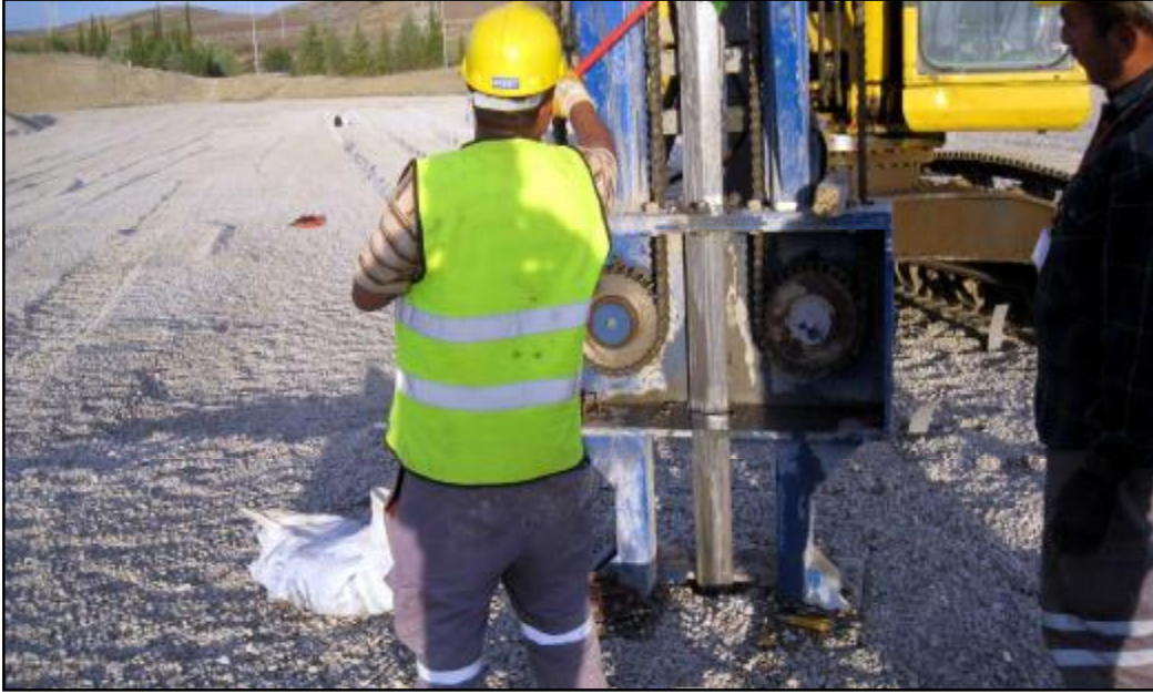
Şekil 3.9. Bant Dren, Demir Mil ve Çapa Materyalleri.
