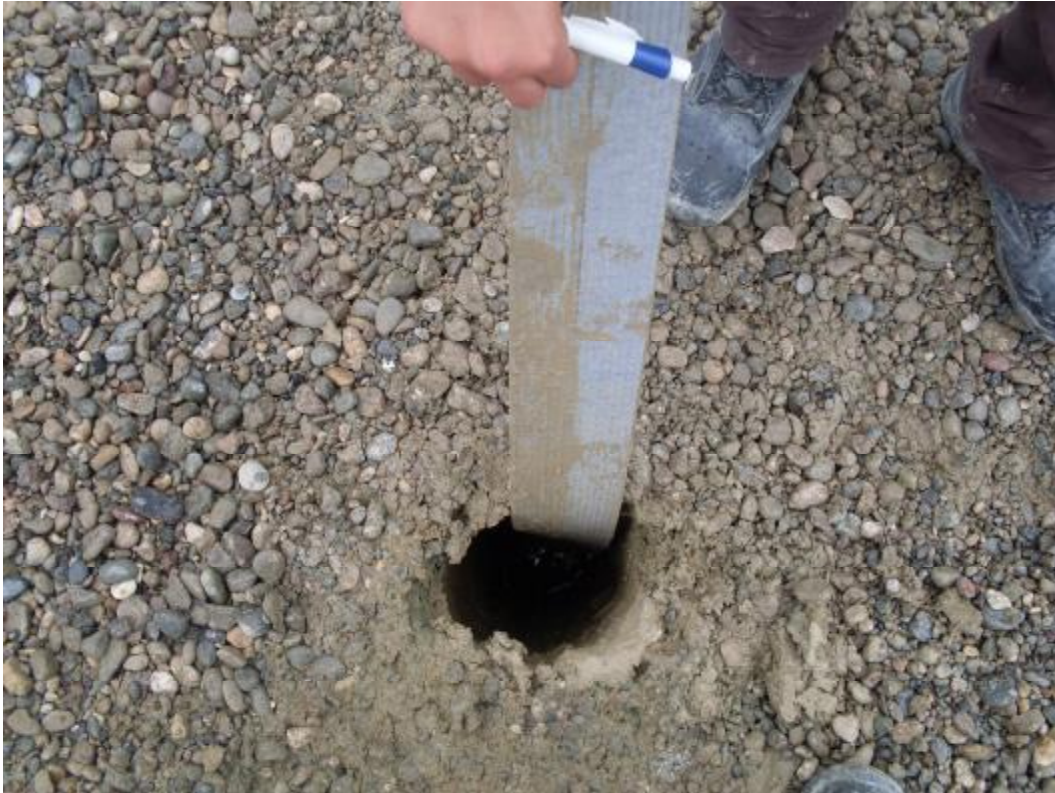
Şekil 3.16. Ön Delgi ve Fıtıl Uygulaması Sonucu.
