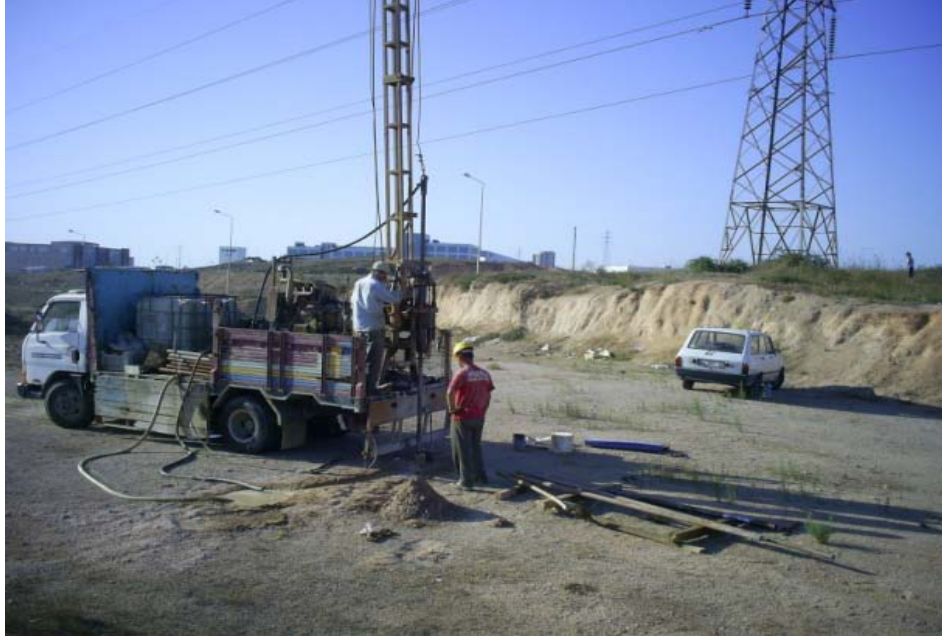
Şekil 4.16: Arazide sondaj kuyusu açılması ve SPT uygulaması
