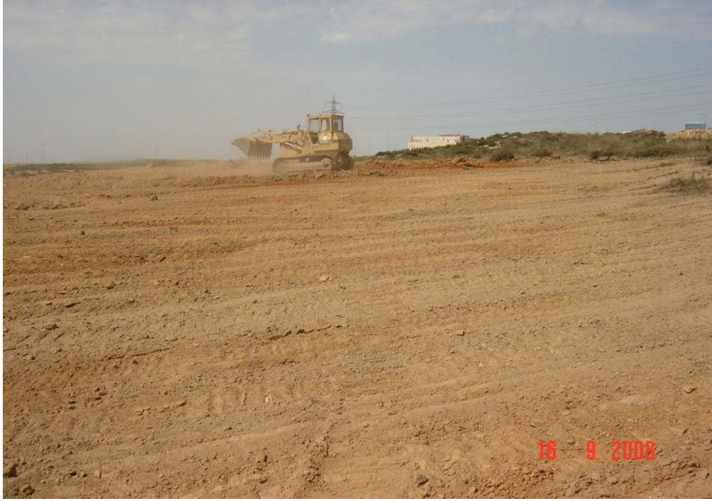
Şekil 4.17: Bitkisel toprak kazısı
