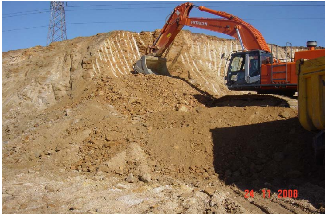
Şekil 4.18: Arazide kazı çalışmaları
