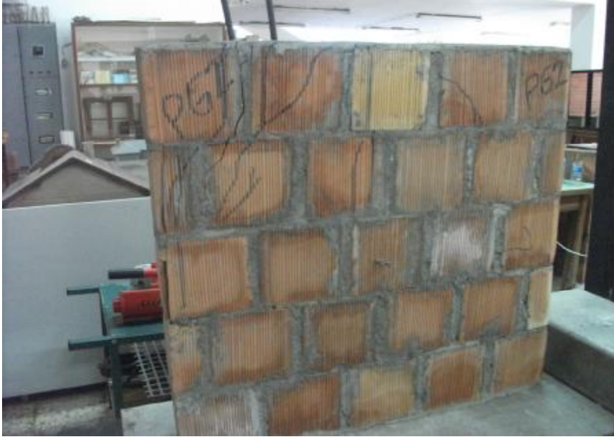
Sekil 4.55. Güçlü Harçlı 1x1m'lik Yatay Delikli Panel Numunesi (PG2) Yükleme Sonrası Oluşan Çatlakların Görünümü.
