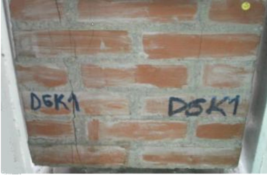
Şekil 4.90. DGK1 Numunesi Yükleme Sonrası Derzlere Paralel Oluşan Eğilme Çatlakları
