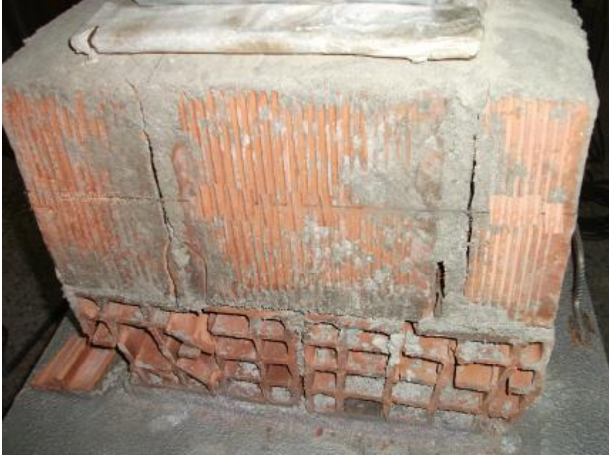
Sekil 4.106. YZ1 Duvar Numunesi Göçme Anı ve Düşey Yönde Oluşan Simetrik Çatlaklar
