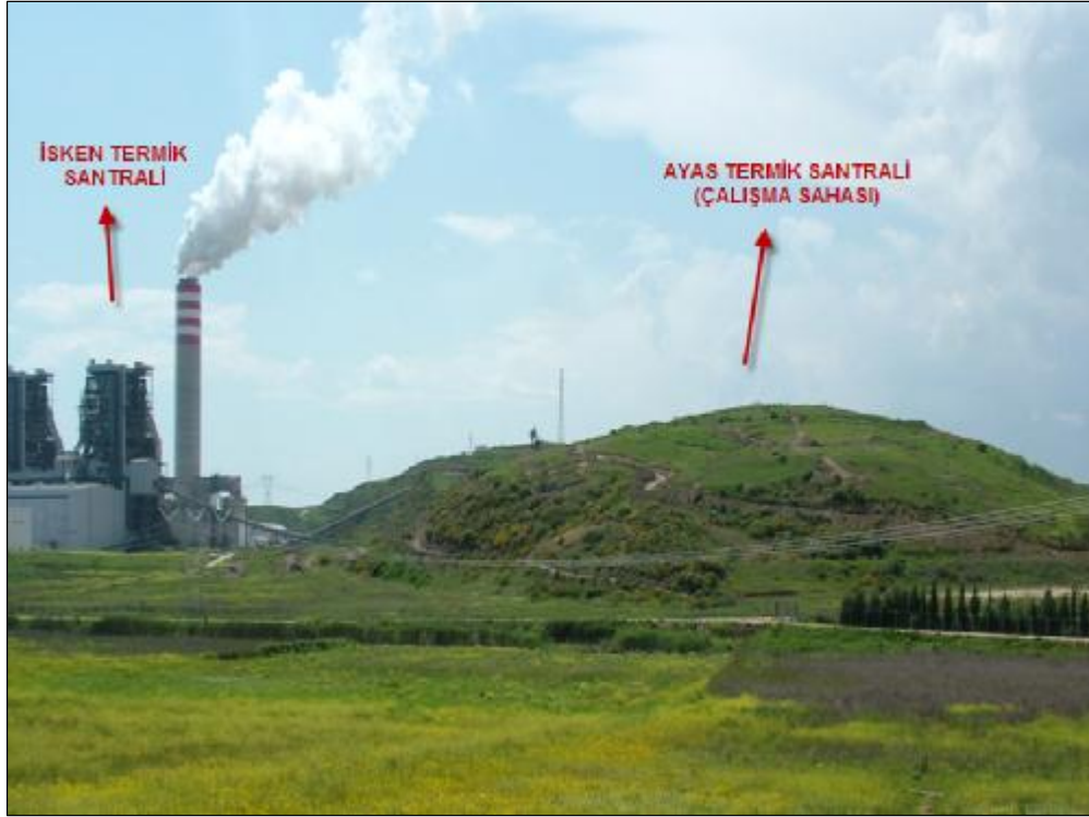
Şekil 1. 2. Çalışma Sahasının Görünümü.
