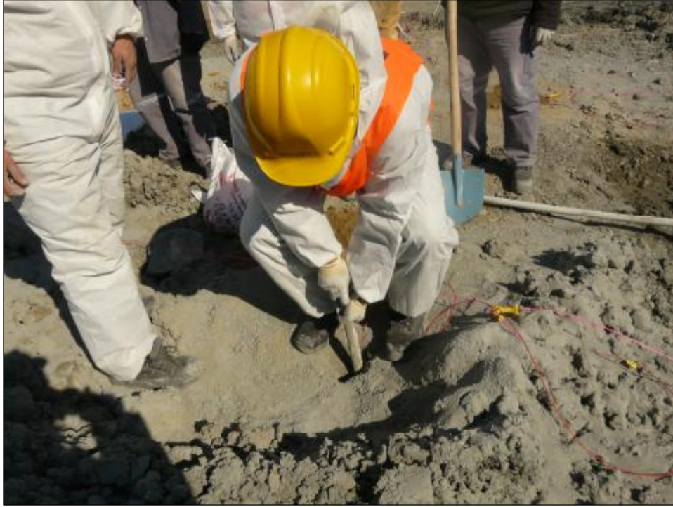
Şekil 3. 3 Arazide Patlayıcı Yerleşimi
