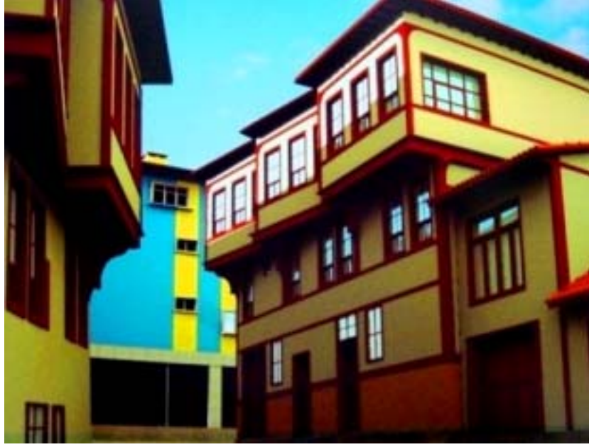
Max 4.15: Karaa Sokak Balıklı Mahallesi (Kapı No : 24)
