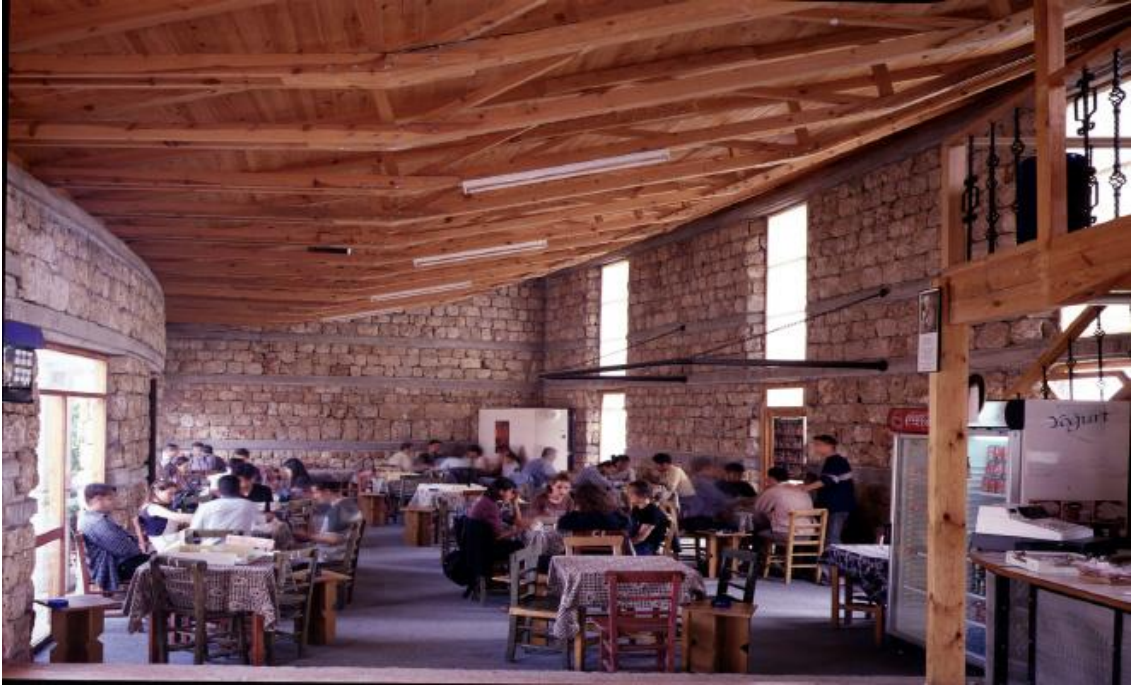
Şekil 4.a.2.12 – Çatı konstrüksiyonunu taşıyan ahşap makaslar
