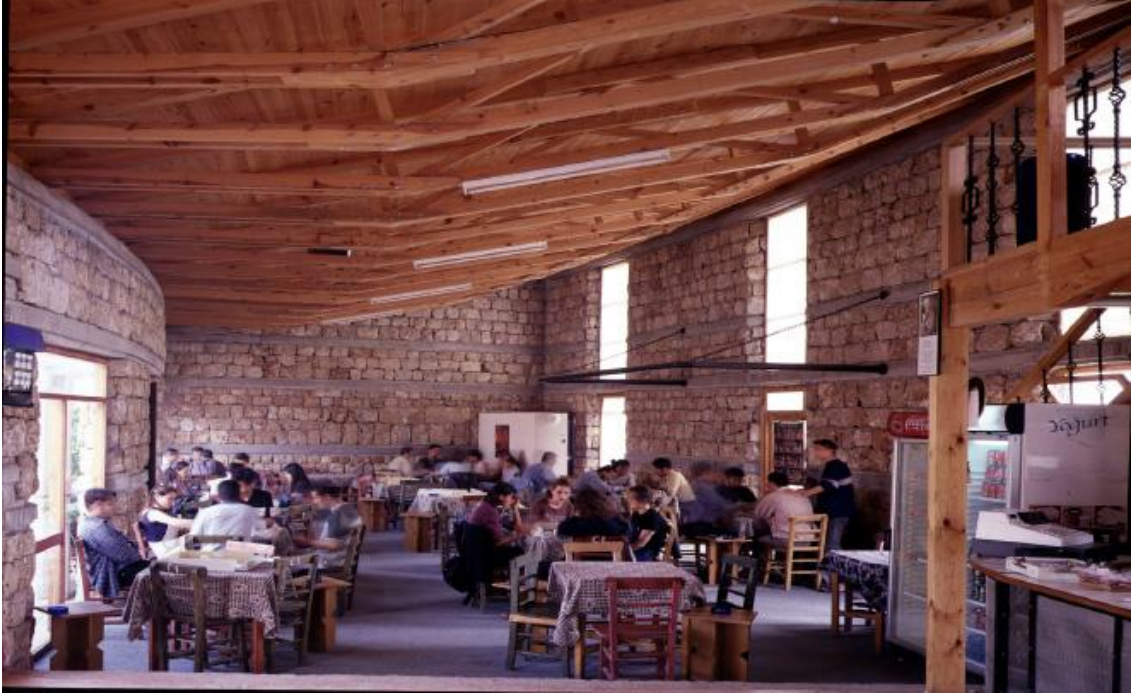
Şekil 4.a.23 – Hibrid taş duvarlara oturan ahşap makaslar
