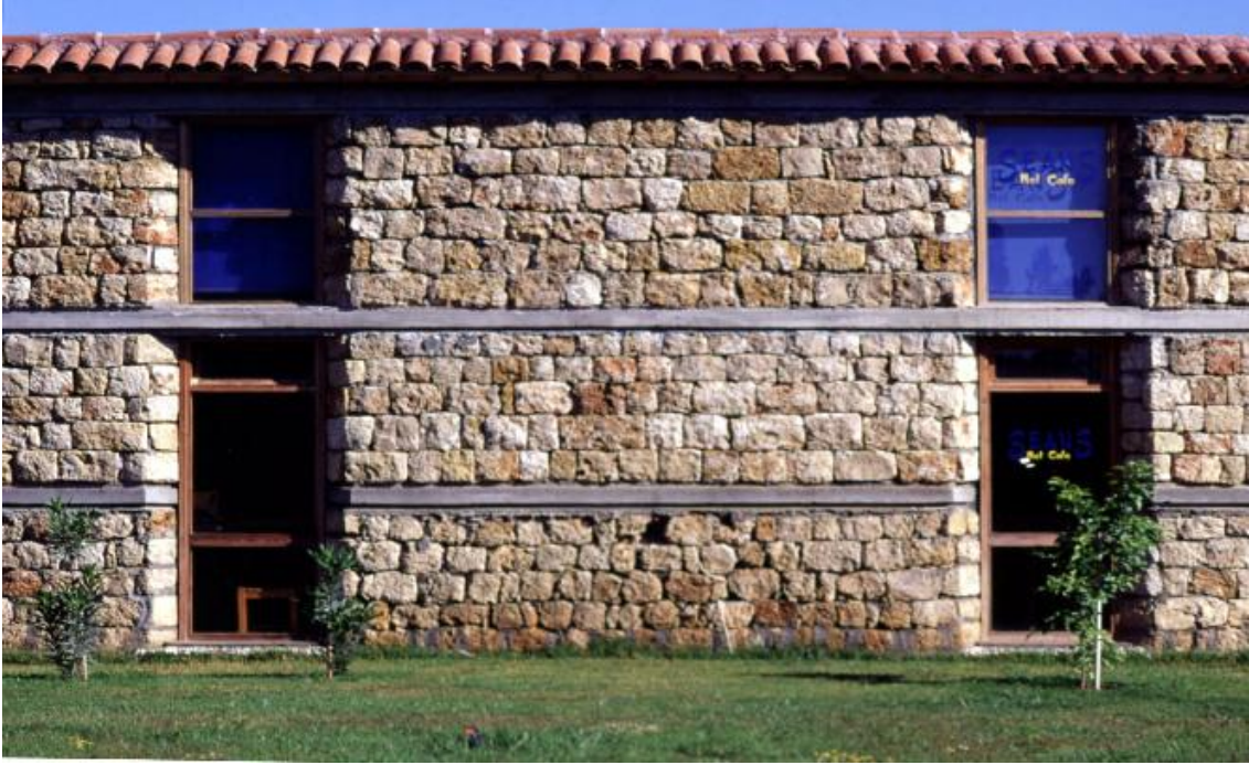
Şekil 4.a.2.11 – Betonarme hatıllı taş duvarlar
