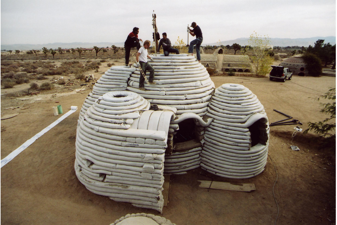
Şekil 2.2 - Kum torbası barınak prototipi(sand bag shelter prototype)
