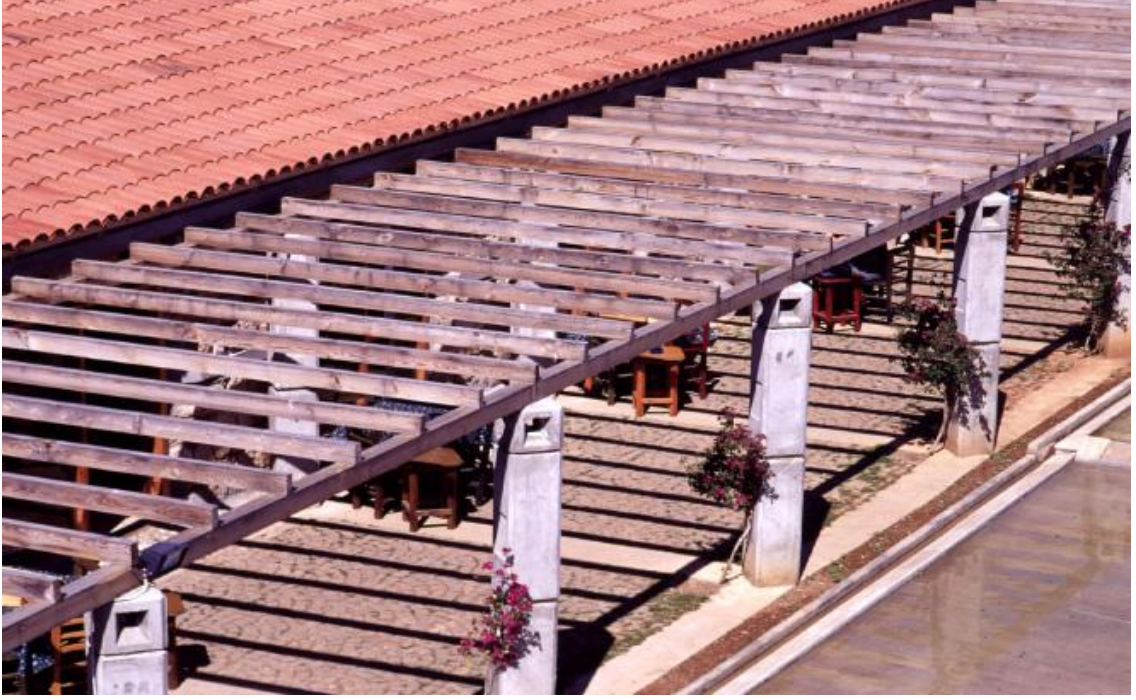
Şekil 4.a.2.13 – Pergolaları taşıyan prekast kolonlar
