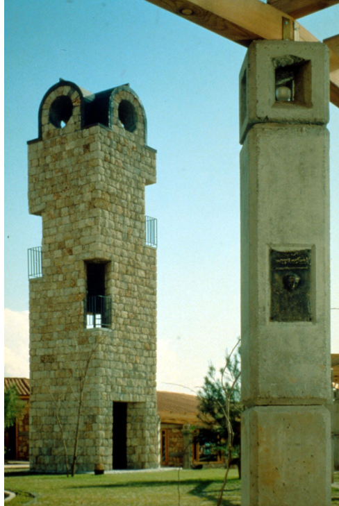
Şekil 4.a.2.14 – Prekast kolonlar üzerinde bulunan piriç plakalar
