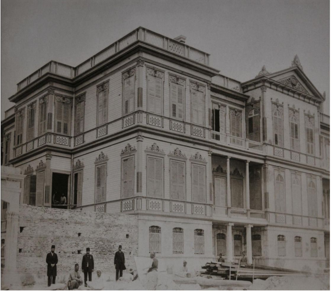
Ortaköy Defterdarburnu'nda Zekiye Sultan Yalısı'nın 1891 yılına ait fotoğrafı (Sultan II. Abdülhamid Arşivi İstanbul Fotoğrafları, s.215). Kereste ve işçiler yalının inşaatının devam ettiğini gösteriyor.
